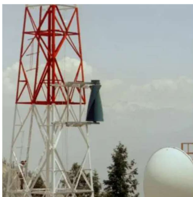
Obrázek 79: SVAWT jako zdroj energie pro telekomunikační věž [61]
