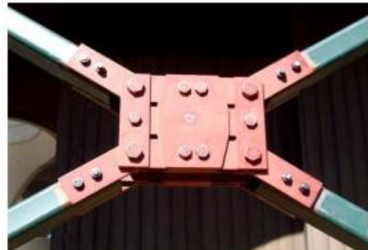
Obrázek 3-11 - Třecí tlumič [12]
