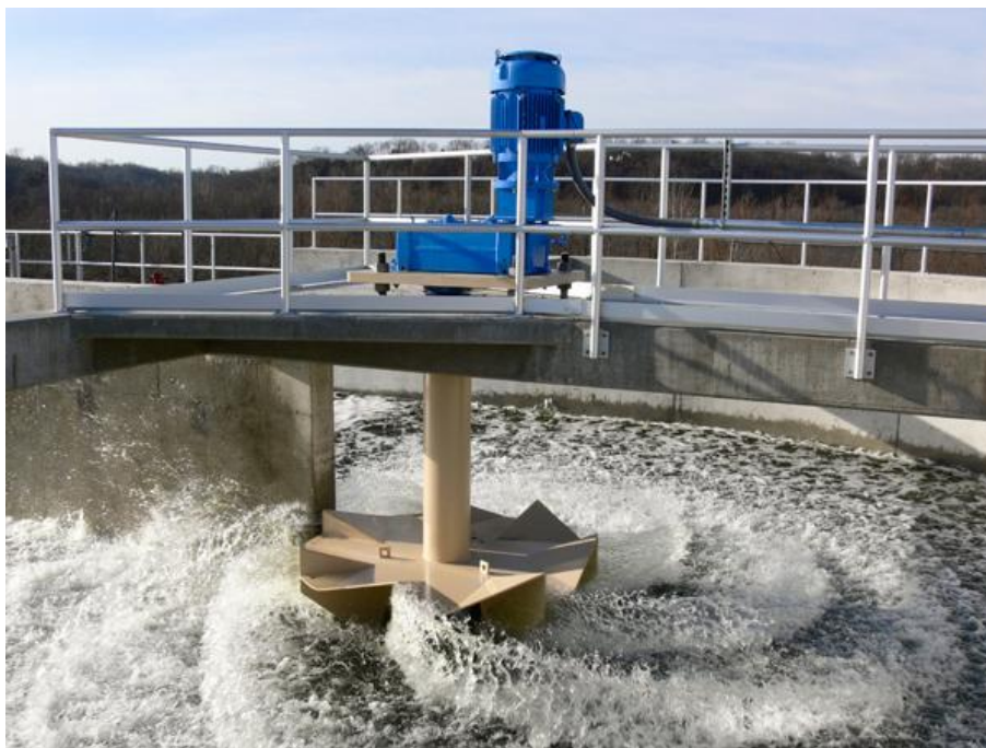
Obr. 7 Mechanické aerátory, a) schéma konstrukčních variant mechanického aerátoru [31], b) využití mechanického aerátoru v technologii čištění odpadních vod [33]
