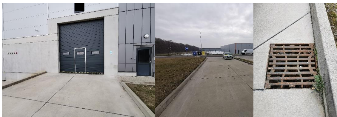
Obrázek 9: Současný stav pracoviště ve skladu SK01 (zleva pohled na sklad, uprostřed pohled od skladu, vpravo ukázka odtoku(kanalizace))
