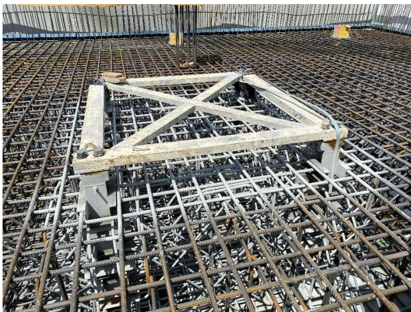
Obr.12 – Založení věžového jeřábu
