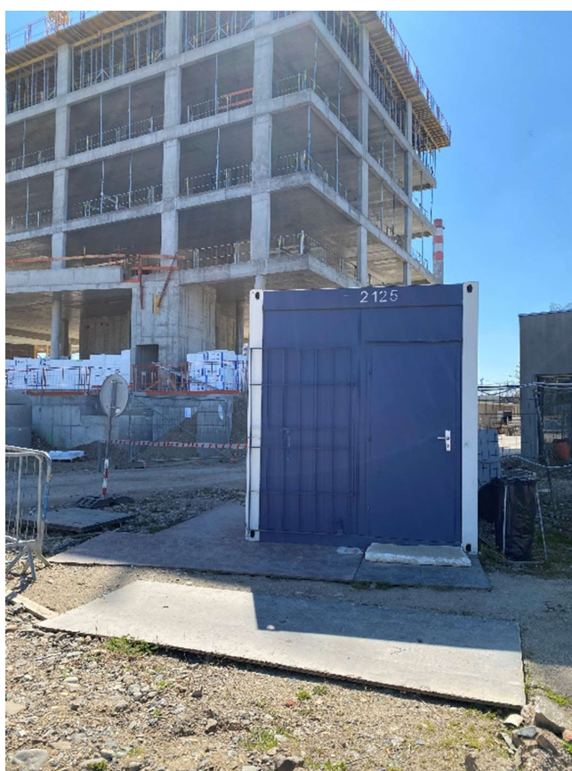
Obr.10 – Buňka TOI TOI BK2 na stavbě
