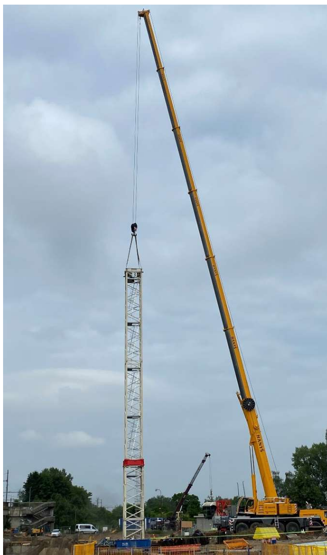
Obr.11 – Montáž věžového jeřábu
