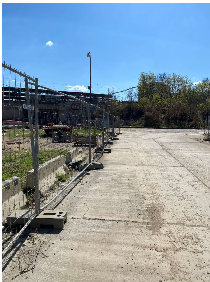
Obr.2 – Oplocení staveniště dratěný plot
