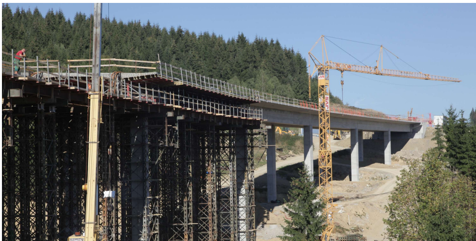
Obr. 2.3.13: Konstrukce stavěná na přestavné skruži [5]
