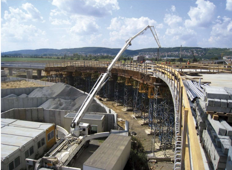
Obr. 2.3.12: Konstrukce betonovaná na skruži [4]
