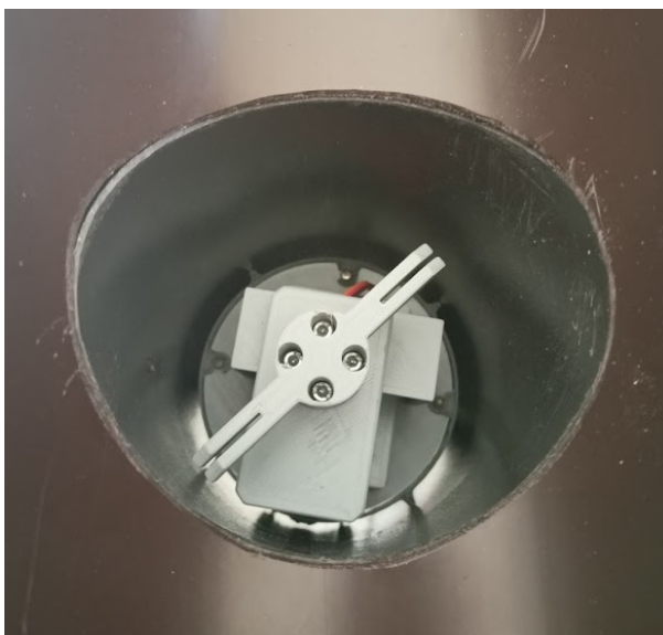
Obr. 24: Svislý pohyb robota ve svodu
