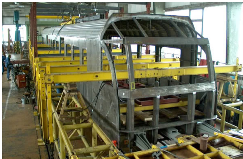
Obrázek 3: Statická zkouška hrubé stavby skříně, zdroj: [40]
