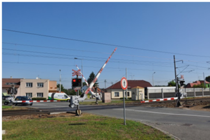
Obrázek 21: ŽP vybavený sekvenčním sklápěním závor, zdroj: [58]
