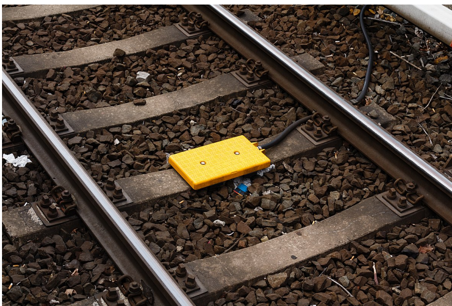
Obrázek 18: Eurobalíza - traťová část ETCS, zdroj: [56]
