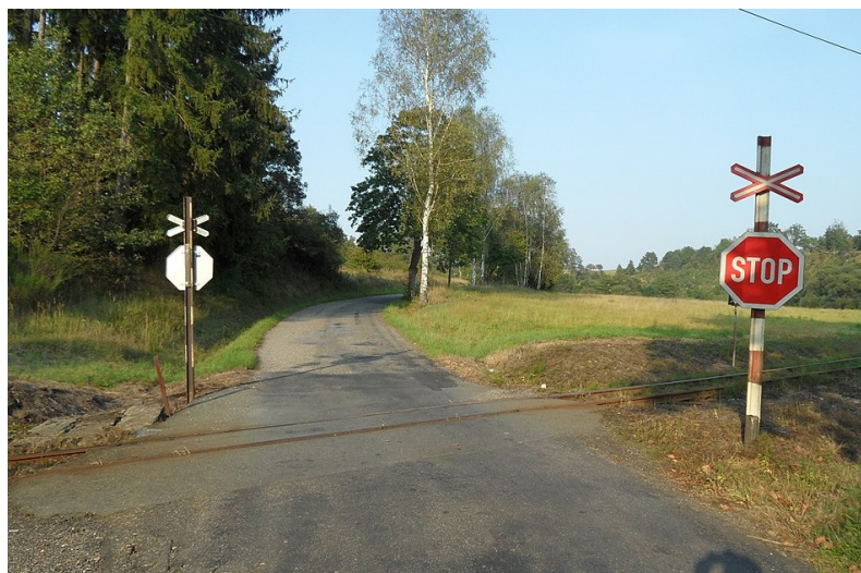
Obrázek 19: Přejezd zabezpečený výstražnými kříži, zdroj: [24]
