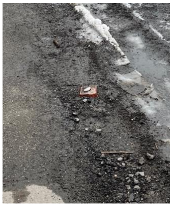
Obr. 40 – Bod č. 5 v terénu
