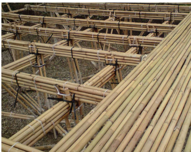
Obrázek 100 Provedení bambusové rámové konstrukce
