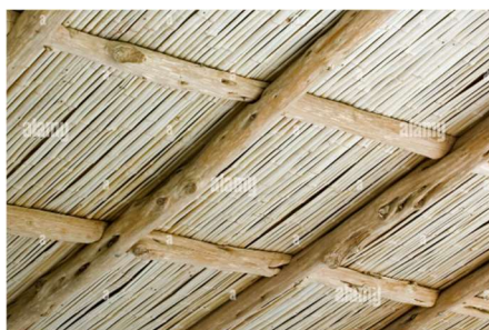
Obrázek 92 Bambusový rastrový strop s dřevěnými trámy a bambusovými proužky
