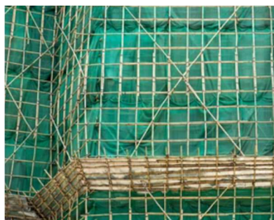
Obrázek 59 Bambusové lešení na výškové budově s malou konzolou
