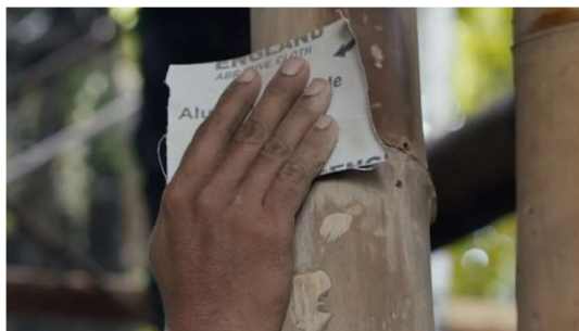
Obrázek 111 Obroušení bambusové konstrukce brusným papírem
