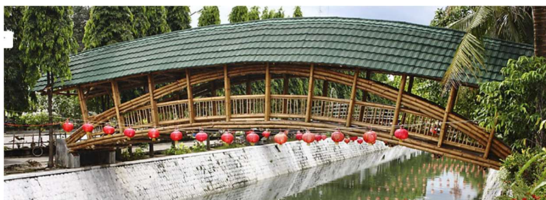
Obrázek 114 Finální konstrukce lávky v Solo
