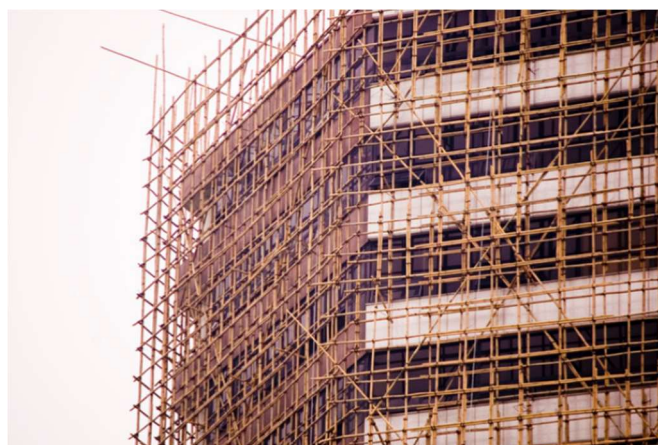
Obrázek 61 Bambusové lešení na výškové budově
