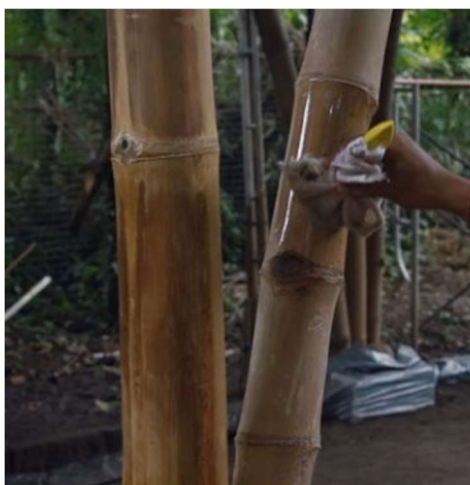
Obrázek 112 Finální nátěr bambusové konstrukce
