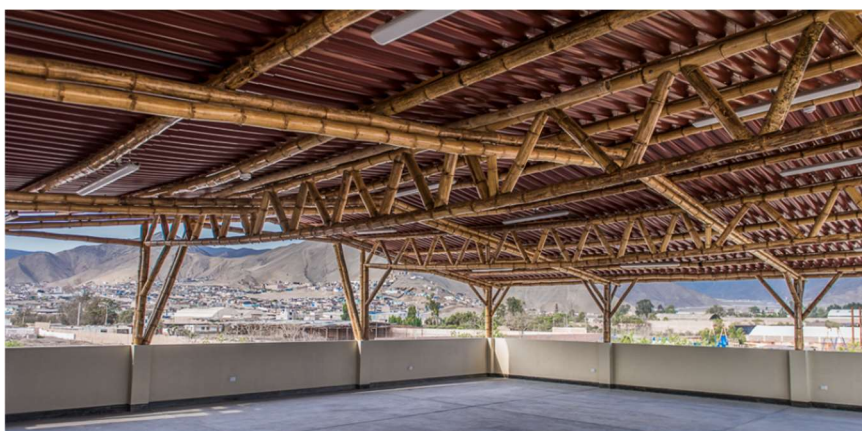
Obrázek 63 Střešní konstrukce tvořená bambusovými příhradovými nosníky
