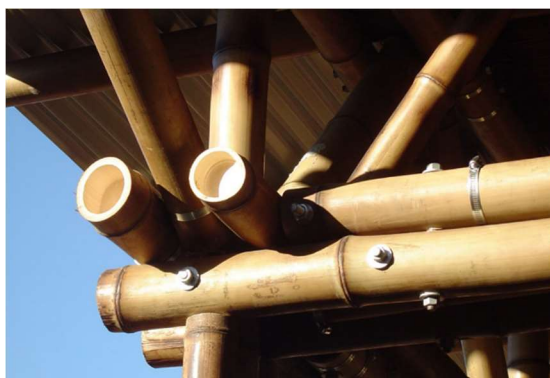
Obrázek 137 Ukázka šroubového spoje na konstrukci
