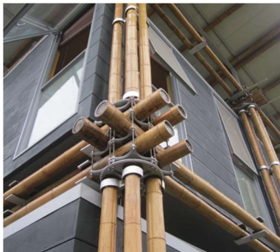
Obrázek 146 Kombinovaný spoj
