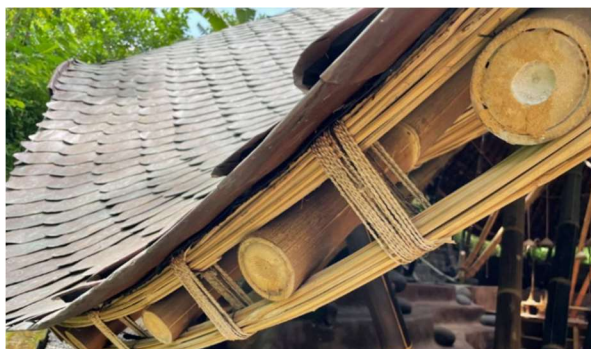
Obrázek 110 Zakrytí konců bambusových tyčí
