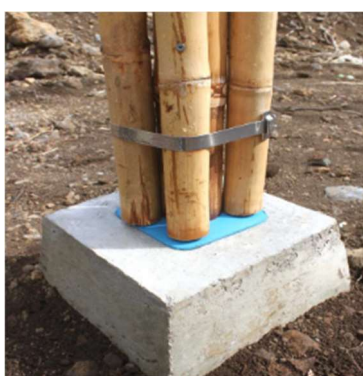
Obrázek 84 Zabetonovaný sloup do základů
