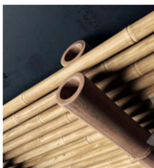
Obrázek 90 Jednoduchý bambusový trámový strop s dvěma tyčemi
