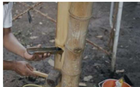
Obrázek 106 Usazování betonu za pomocí klepání na stěnu tyče
