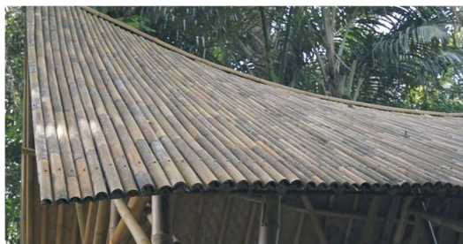
Obrázek 71 Střešní krytina bambusové prejzy
