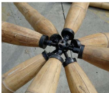
Obrázek 144 Pan knot space truss
