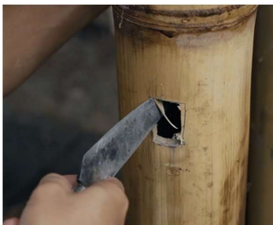
Obrázek 104 Vysekání otvoru do bambusového sloupu
