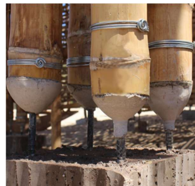
Obrázek 86 Navázání sloupů na výztuž základů
