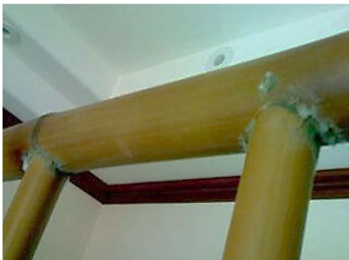
Obrázek 148 Napadení skvrnitými houbami
