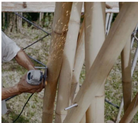
Obrázek 107 Čištění a detailní úprava bambusové konstrukce
