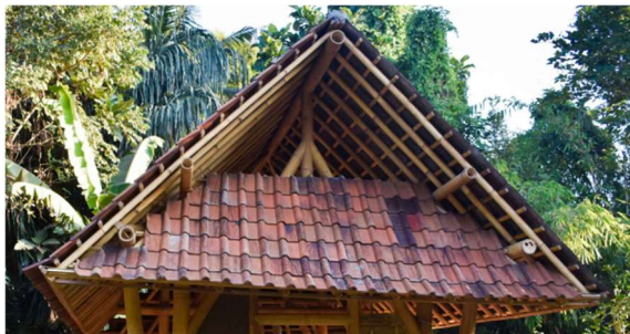
Obrázek 73 Terakotová krytina na bambusovém krovu
