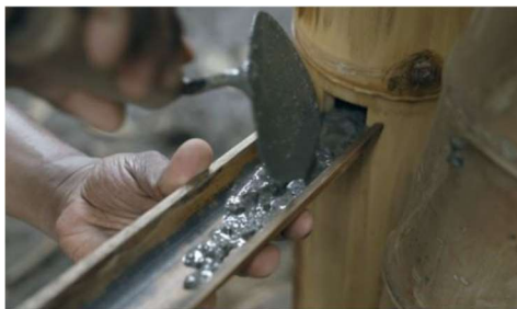
Obrázek 105 Lití betonu do otvoru v bambusovém sloupku
