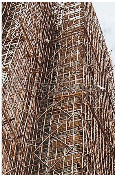
Obrázek 58 Bambusové lešení na výškové budově
