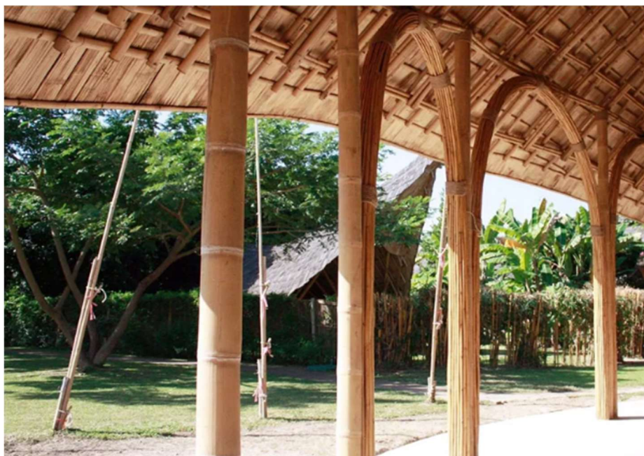
Obrázek 87 Masivní sloup z jedné tyče u tělocvičny v thajském Čiang Mai
