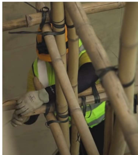
Obrázek 57 Vázání bambusových tyčí nylonovými páskami
