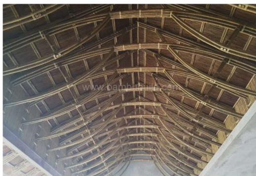
Obrázek 65 Konstrukce bambusového krovu
