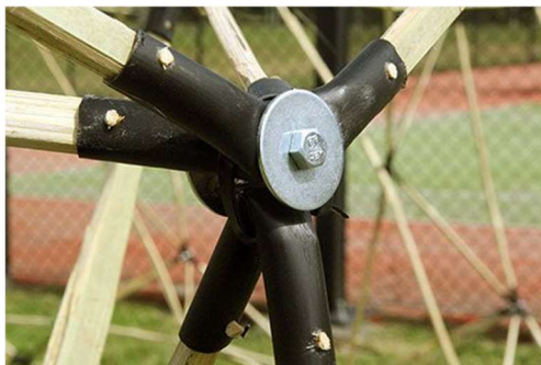
Obrázek 139 Uzlový spoj pro připojení více tyčí
