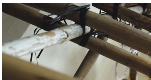
Obrázek 56 Svázané tyče k sobě nylonovými vlákny
