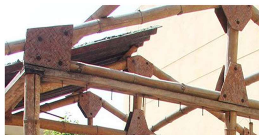
Obrázek 141 Použití deskového spoje
