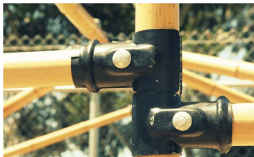
Obrázek 138 Ukázka spoje za pomoci svorníků
