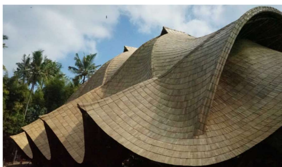
Obrázek 74 Krytina z bambusových rohoží na zakřiveném krovu.
