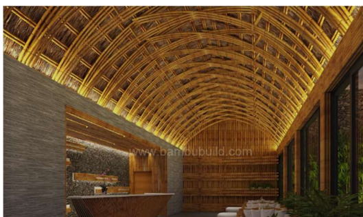
Obrázek 67 Konstrukce bambusového krovu
