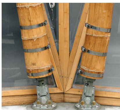
Obrázek 85 Kloubový spoj sloupů se základem
