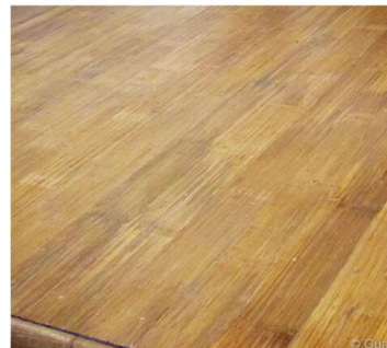
Obrázek 49 Podlaha z bambusových rohoží
