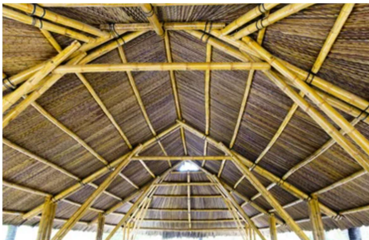
Obrázek 64 Konstrukce bambusového krovu
