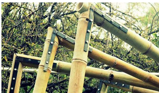
Obrázek 140 Použití páskového spoje
