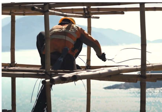
Obrázek 55 Vázání bambusových tyčí nylonovými páskami
