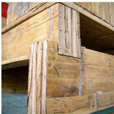
Obrázek 47 Nosníky z bambusových rohoží
