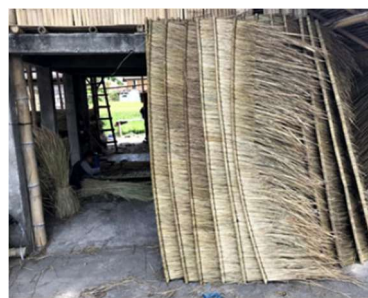
Obrázek 70 Latě připravené na upevnění ke krovu
