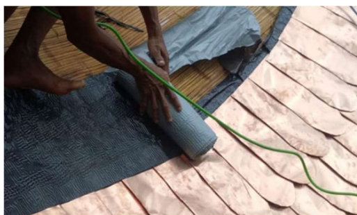
Obrázek 75 Ukázka upevnění měděné krytiny
