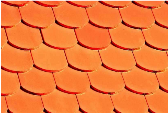
Obr. 43 - bobrovky, šupinové krytí
