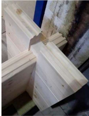
Obr. 49 - fotka nárožního spoje
