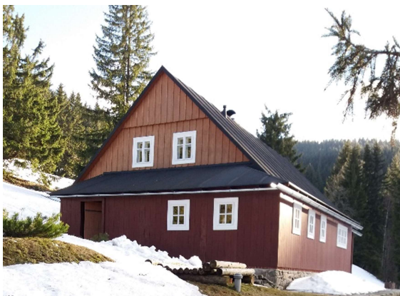
Obr. 82 - roubený dům s přístavbou zádveří
