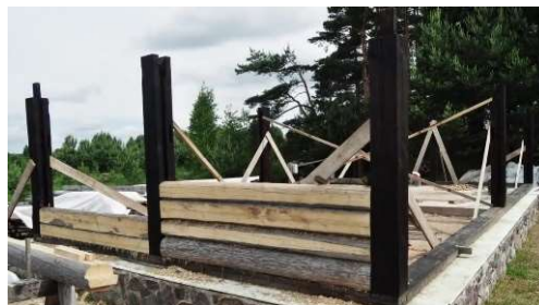
Obr. 22 - zapažení roubené stěny
