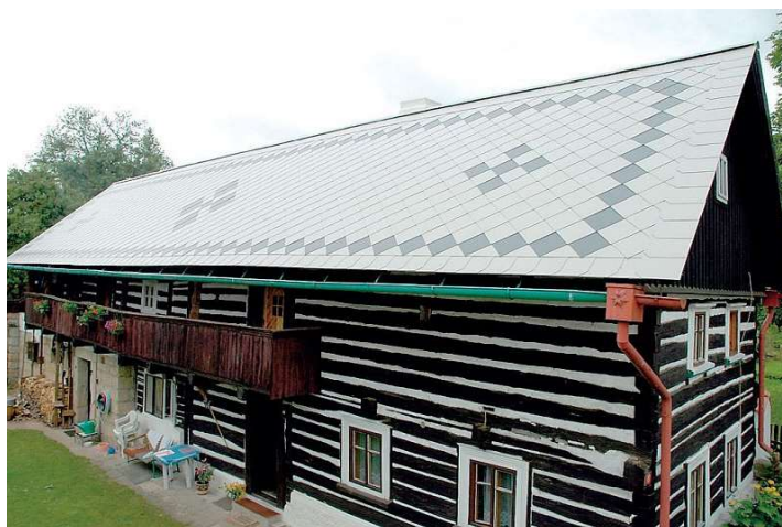
Obr. 45 - střecha s eternitovou krytinou
