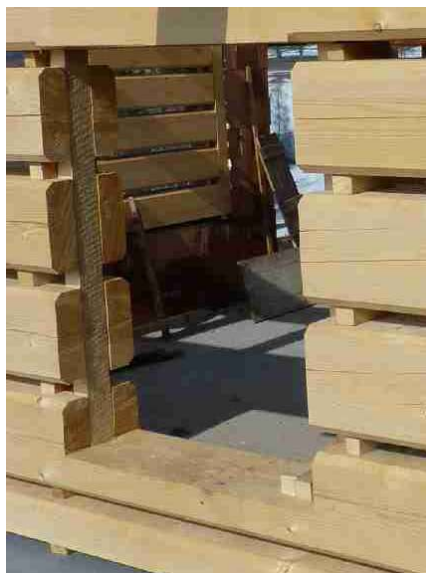
Obr. 23 - ukončení sloupkem u okenního otvoru
