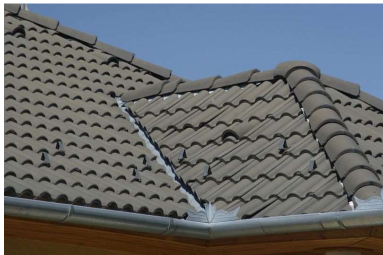
Obr. 44 - betonové střešní tašky
