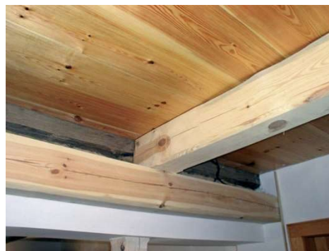
Obr. 36 - zákloповý strop na sraz
