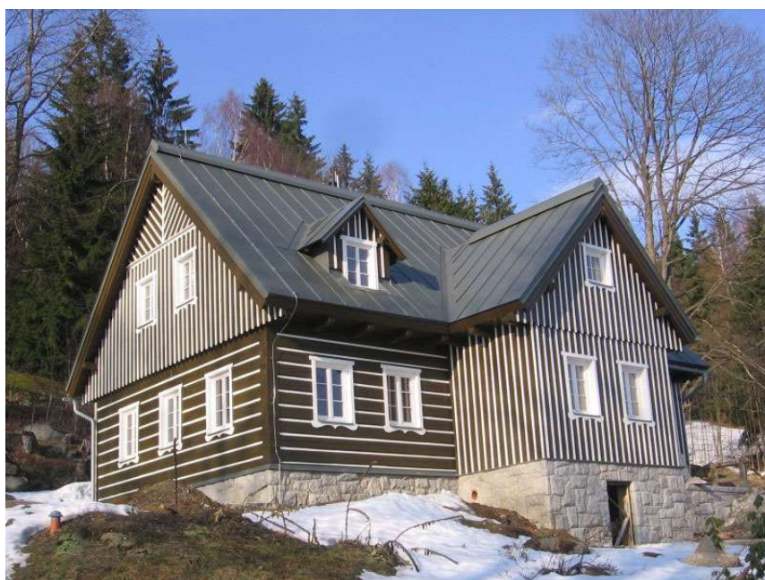
Obr. 46 - střecha s falcovaným plechem
