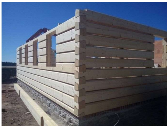
Obr. 30 - jednoduchá stěna s podélnou spárou
