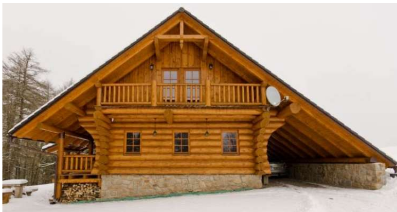
Obr. 15 - dostatečný přesah střechy
