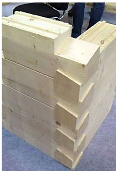
Obr. 29 - jednoduchá stěna na pero a drážku
