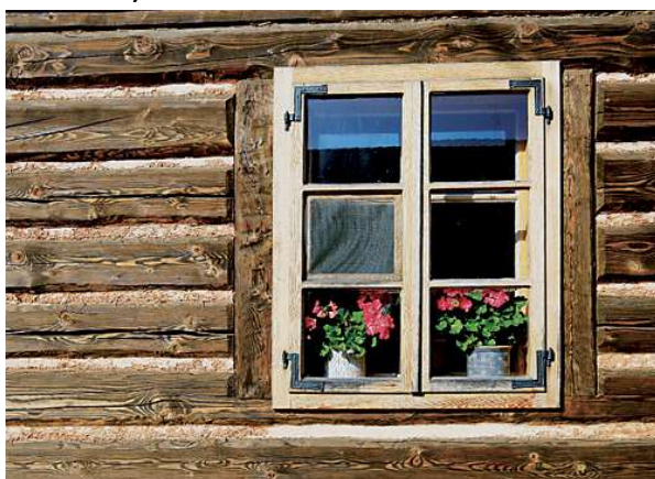
Obr. 33 - spáry s hliněnou mazaninou
