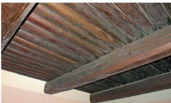
Obr. 35 - povalový strop
