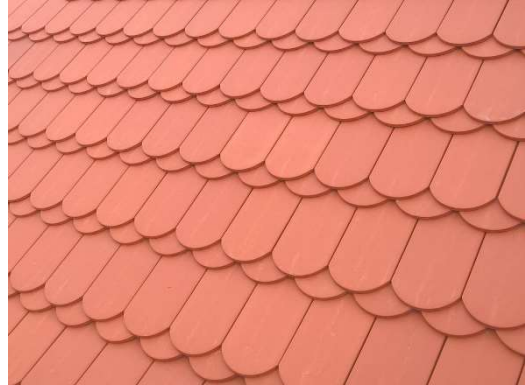
Obr. 42 - bobrovky, korunové krytí
