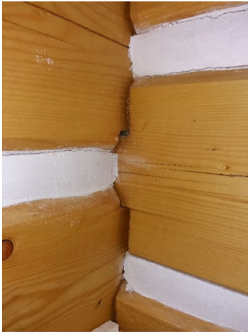
Obr. 24 - napojení vnitřní stěny, pohled zevnitř
