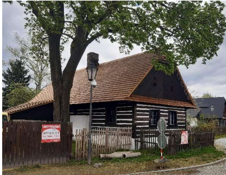
Obr. 39 - střecha s dřevěnými šindeli
