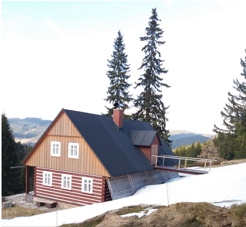
Obr. 47 - střecha s asfaltovou krytinou
