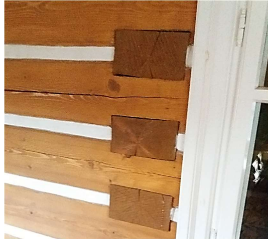
Obr. 25 - napojení vnitřní stěny, pohled zvenku
