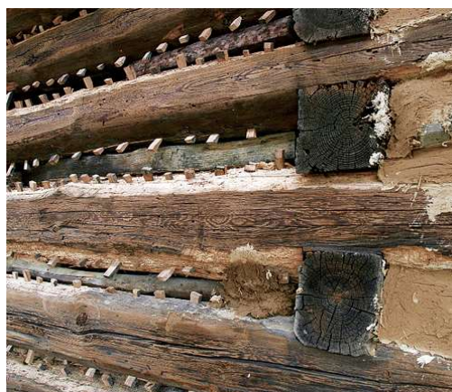
Obr. 32 - zatlučené kolíčky pro lepší soudržnost s mazaninou
