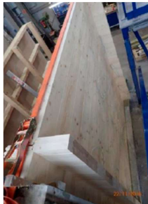
Obr. 48 - fotka stěny ze shora
