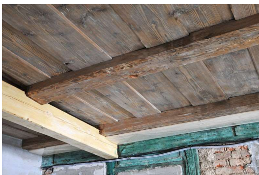
Obr. 37 - zákloповý strop překládaný
