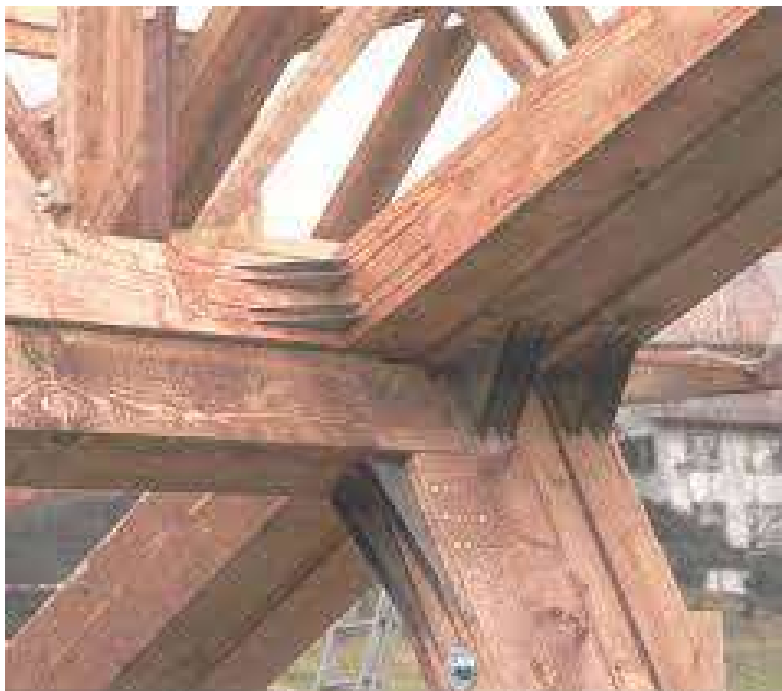
Obrázek 37- Typ systému GREIM BAU [50]
