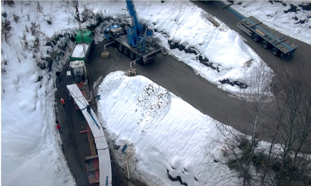
Obrázek 48- Komplikovaná doprava částí pilíře na kopec [42]
