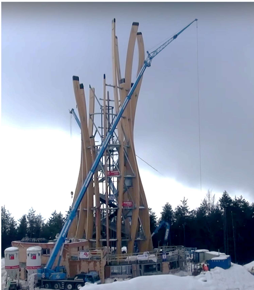
Obrázek 49- Výstavba skládaných pilířů věže z lepeného lamelového dřeva [42]
