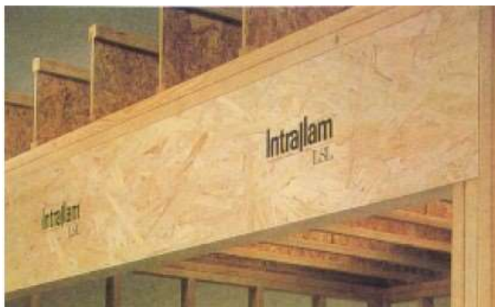
Obrázek 14- Nosník z Intrallam LSL [54]
