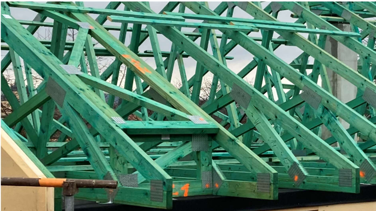
Obrázek 34- Krov z příhradových vazníků spojený deskami s prolisovanými trny
