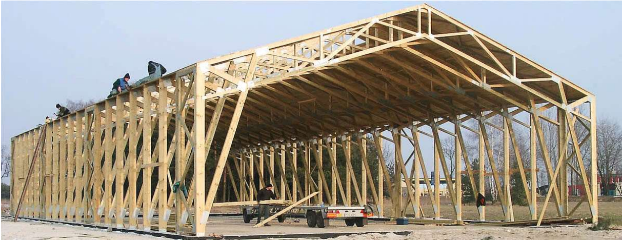
Obrázek 31- Konstrukční systém rámový roh z příhradových nosníků [21]
