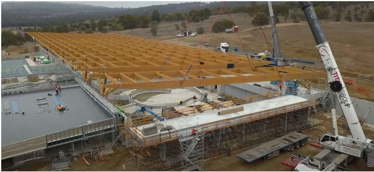
Obrázek 18- Montáž spojených nosníků [33]
