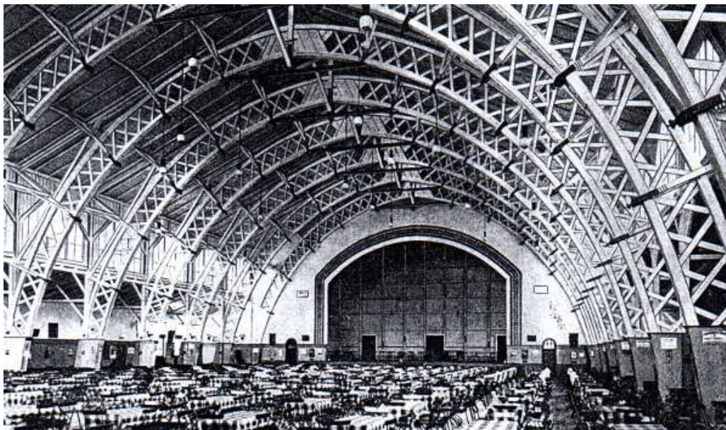
Obrázek 3- Střešní konstrukce Stephanovy soustavy [1]
