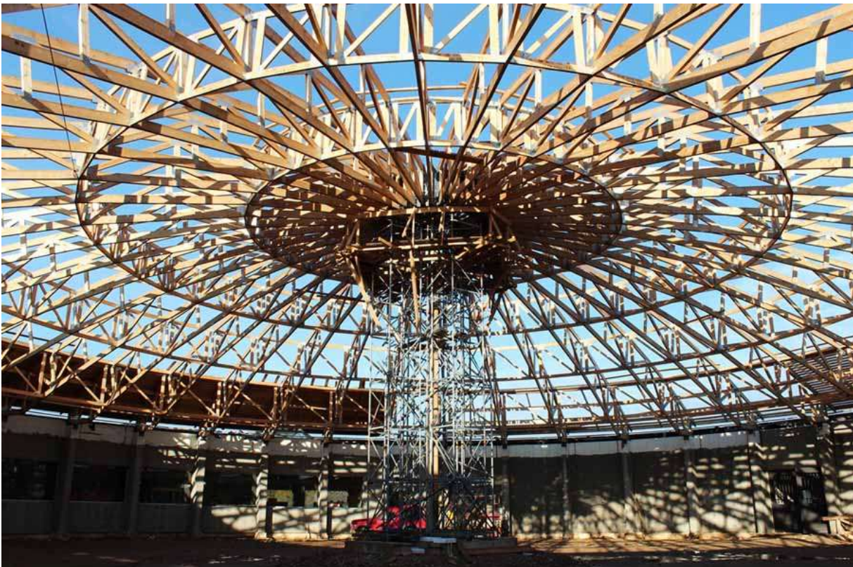
Obrázek 32- Kopulová konstrukce z příhradových nosníků [21]
