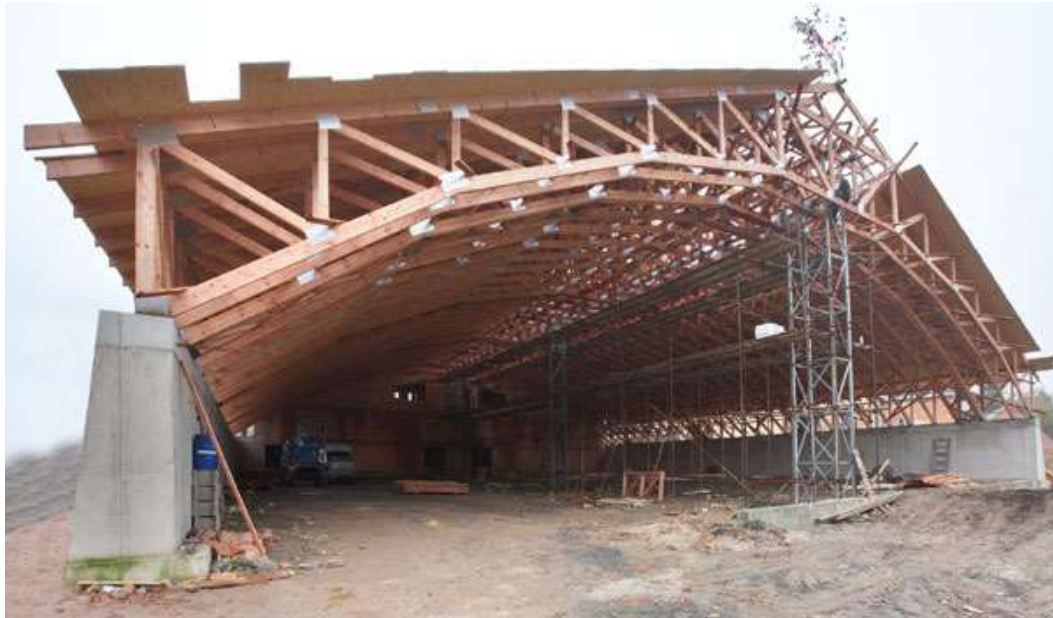
Obrázek 43- Turnov – tenisová hala, příhradový vazník uložený na železobetonovou stěny[38]
