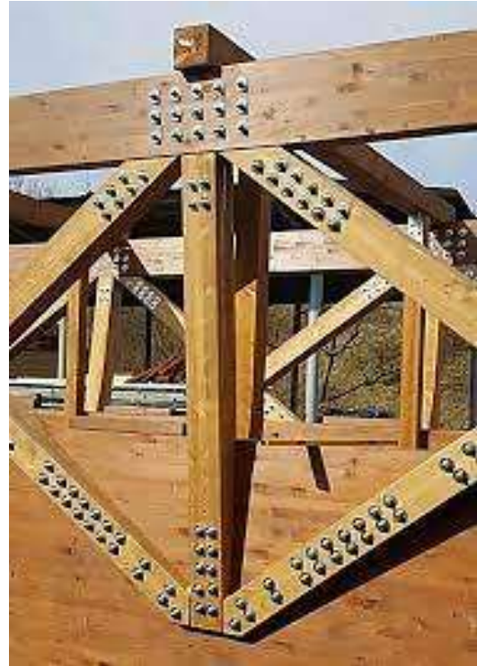
Obrázek 36- Typ systému GREIM BAU [51]
