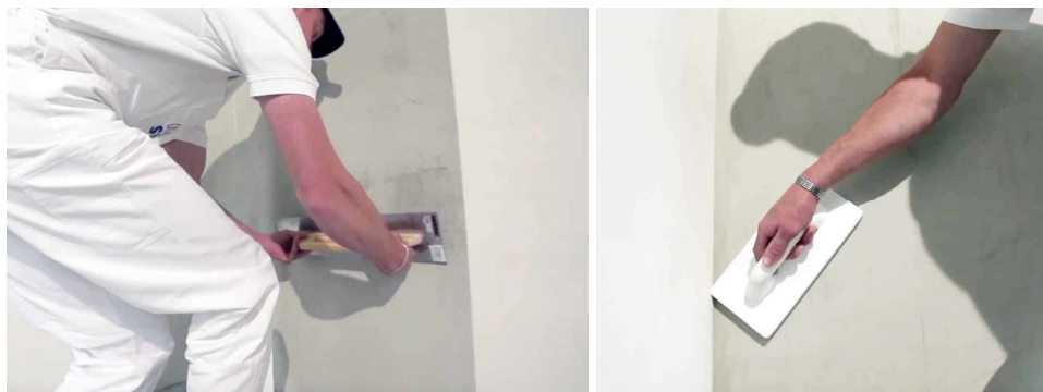
Obrázek 15. Nanášení štukové omítky hladítkem (vlevo) a hlazení omítky filcovým hladítkem (vpravo) [57]
