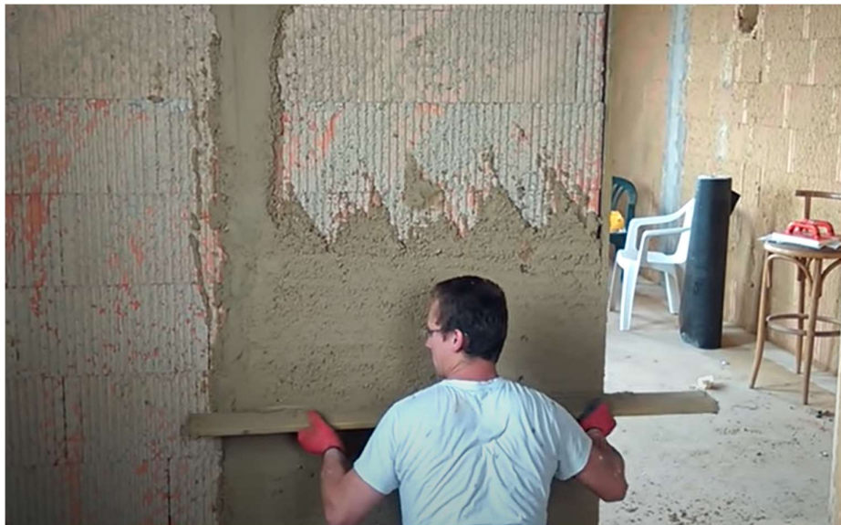
Obrázek 14. Stržení omítky dřevěnou stahovací latí [91]
