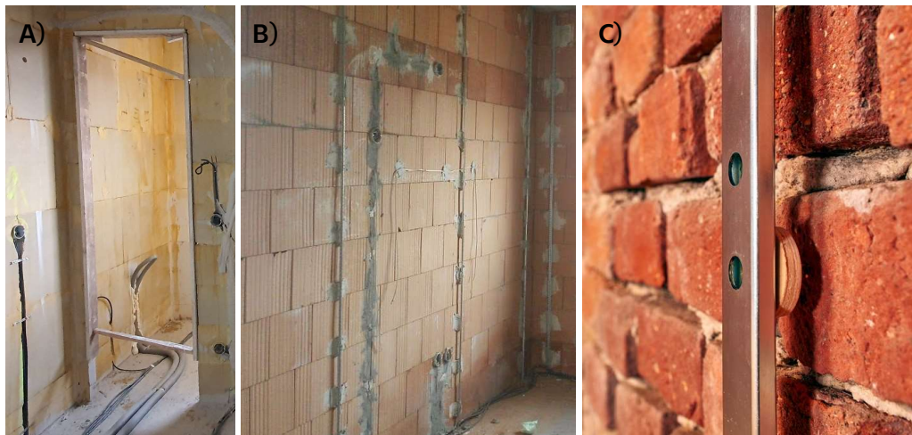
Obrázek 11. A) Provizorní bednění vnitřního otvoru zdi [vlastní tvorba], B) Montáž běžných pozinkovaných omítníků [88], C) Montáž hliníkových omítníkových lišt [89]
