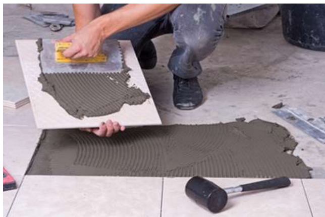
Obrázek 27. Metoda „Buttering - Floating“ [94]
