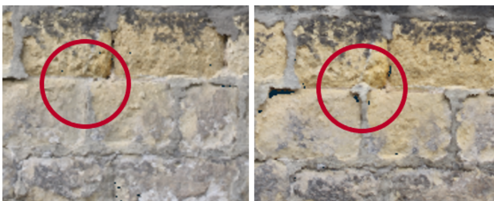
Obrázek 6.3: Uvolněná cementová výplň 2
