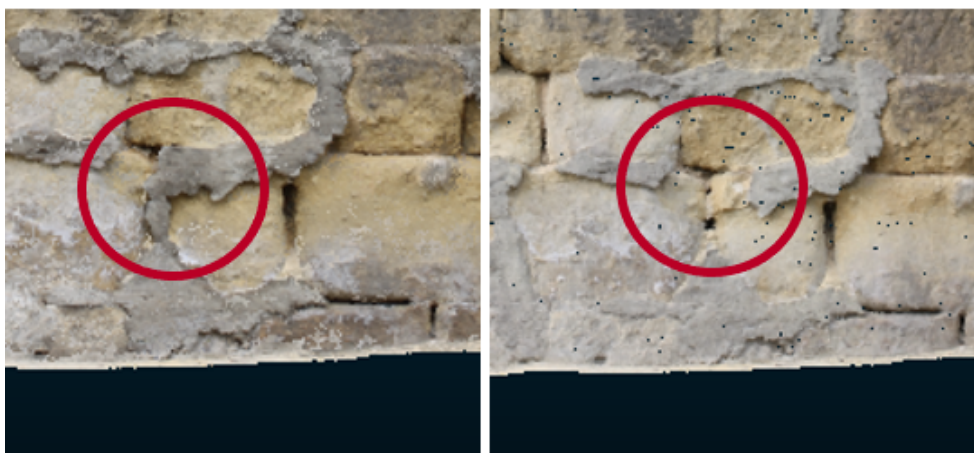
Obrázek 6.2: Uvolněná cementová výplň
