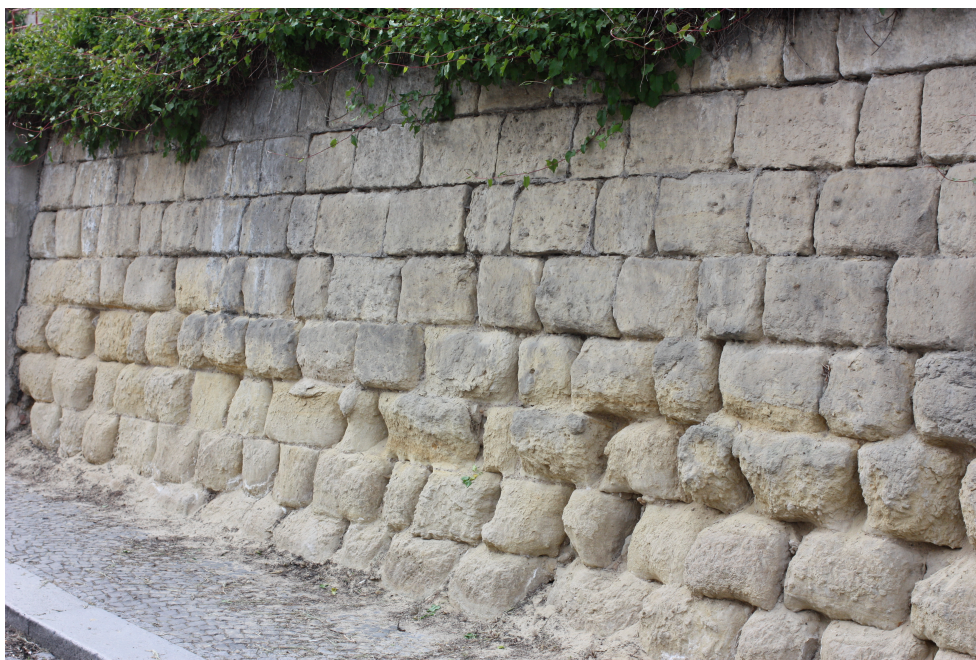
Obrázek 2.3: Zeď narušená solným zvětráváním a trvalým promáčením
