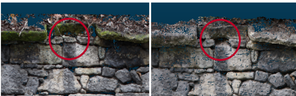
Obrázek 6.4: Uvolněné kameny
