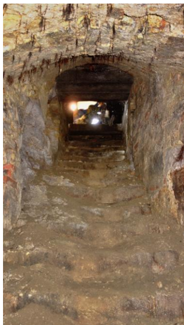
Obrázek 21: Schody do 2. patra
