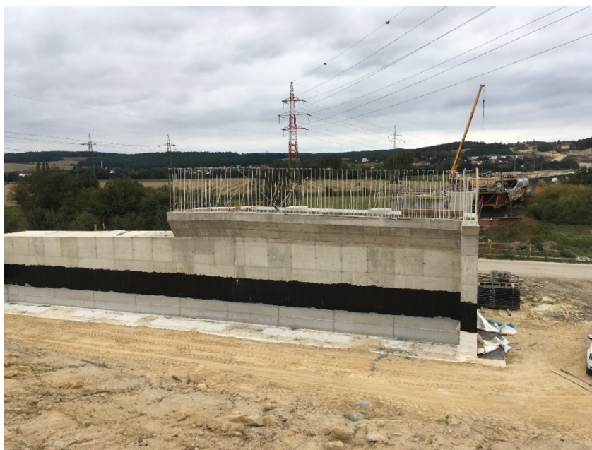
Obr. 22 - Opěra OP1 během výstavby
