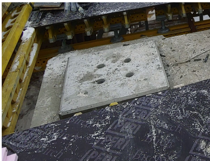
Obr. 28 – Podložiskový bloček před osazením ložiska
