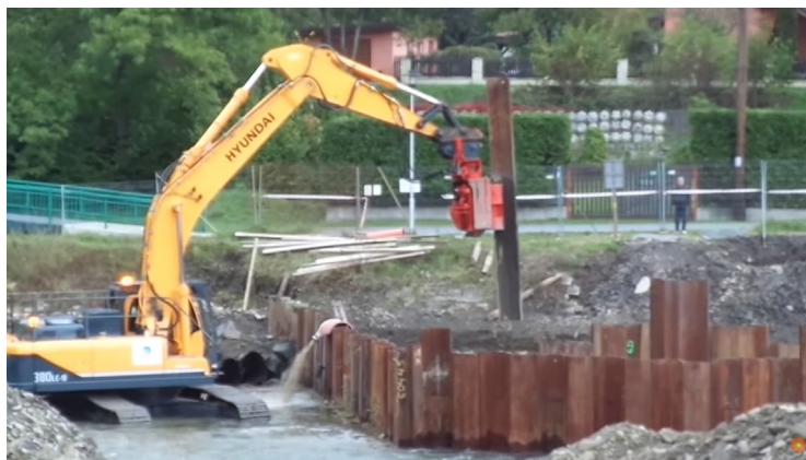
Obr. 18 - Ukázka pažení pomocí štětovnic [17]
