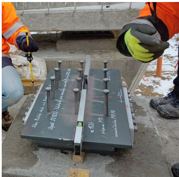
Obr. 30 – Osazování ložiska
