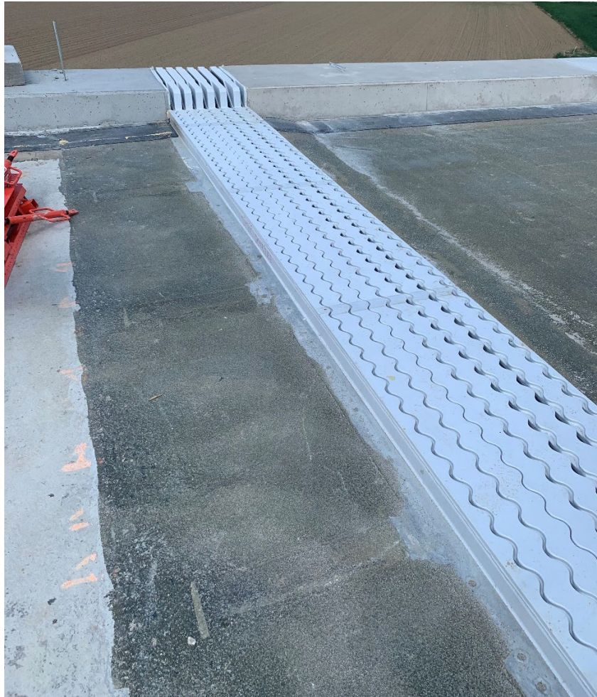
Obr. 46 - Osazený mostní závěr
