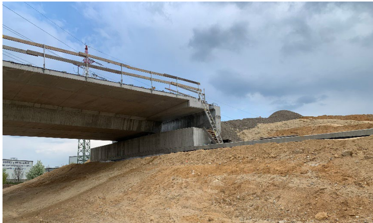
Obr. 23 - Závěrná zídka a úložný práh opěry OP1
