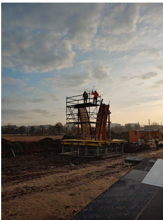
Obr. 26 - Rovnání bednění hlavice pilíře
