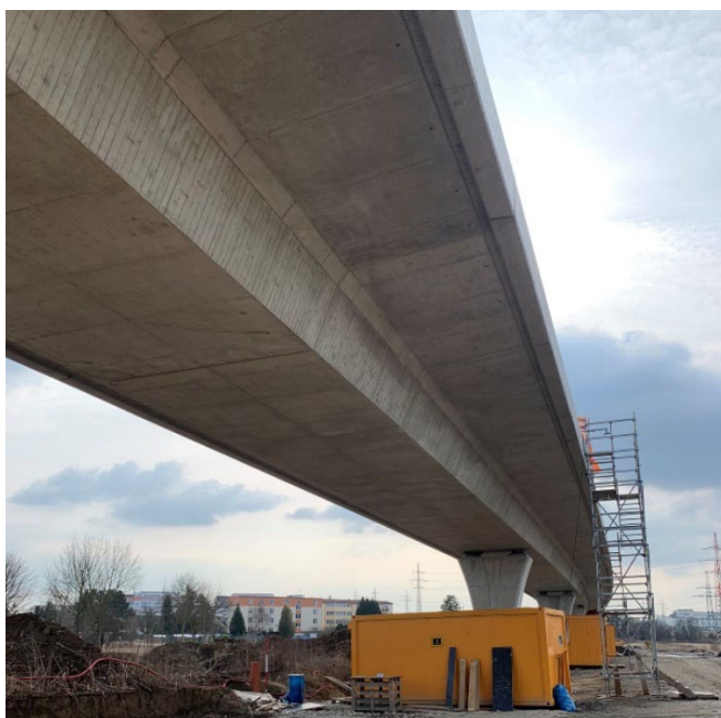
Obr. 39 - Nosná konstrukce a mostovka po odbednění
