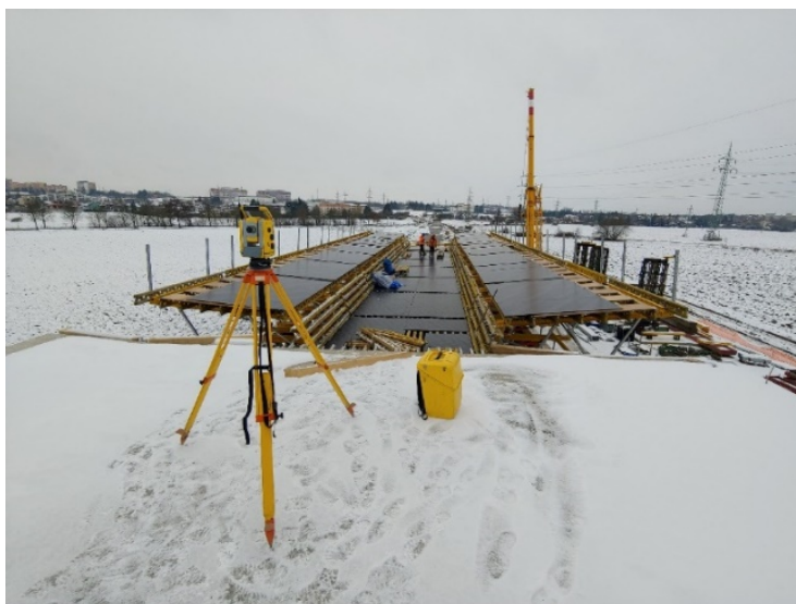
Obr. 32 - Pohled na bednění betonážního taktu nosné konstrukce
