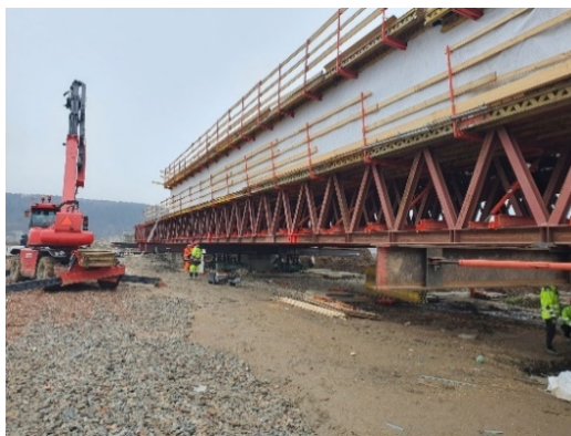
Obr. 37 - Posuvná skruž [20]
