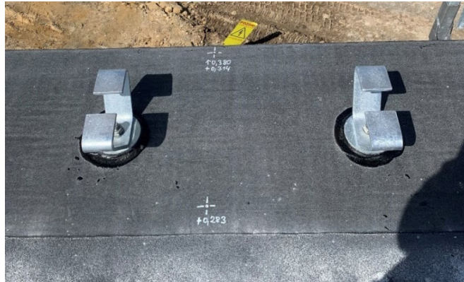
Obr. 43 - Ukázka z vytyčování mostní římsy
