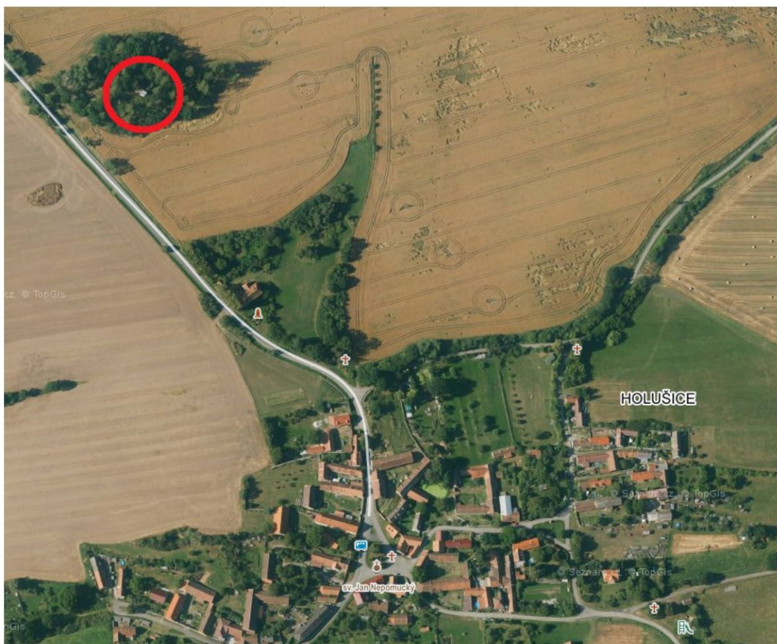
Obr. 7.5.1: Letecký snímek s vyznačením vodojemu Holušice [43].
