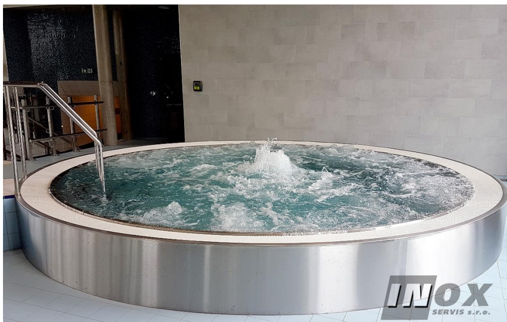
Obr. 10 Pohled na masážní bazén s atrakcemi [24]
