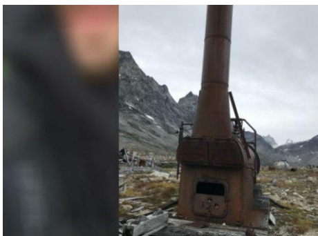
Obr. 31 – Kotel sloužící k vytápění hangárů [24]
