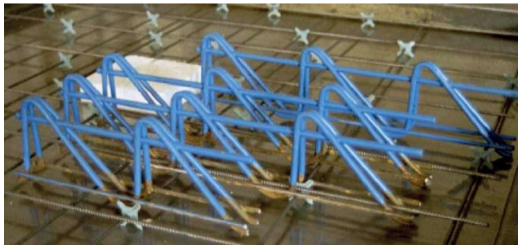
Obr. 3.34 Smyková výztuž proti protlačení – příhradové lišty [43]
