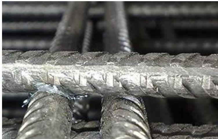
Obr. 3.6 Detail spojovacího svaru výztužné sítě [23]
