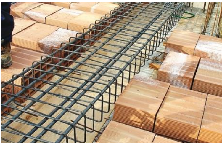
Obr. 3.16 Armování průvlaku s kontinuálními třmínky [31]
