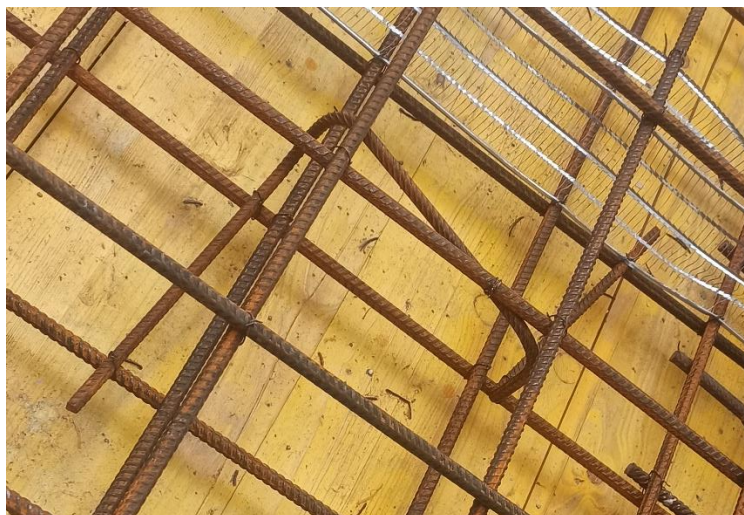
Obr. 3.28 Distanční podložka ve stropní desce - kozlík
