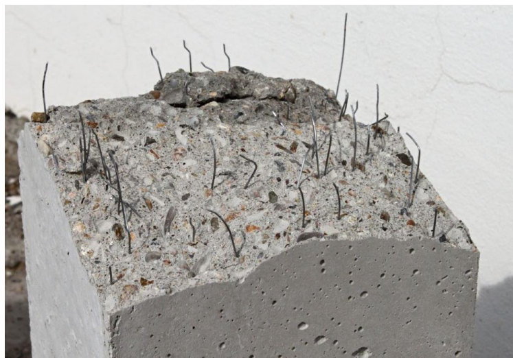
Obr. 2.6 Rozlomený trámek z vláknobetonu [13]
