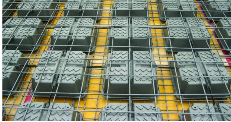
Obr. 3.14 Vylehčená stropní deska - U-Boot system firmy Daliform [30]
