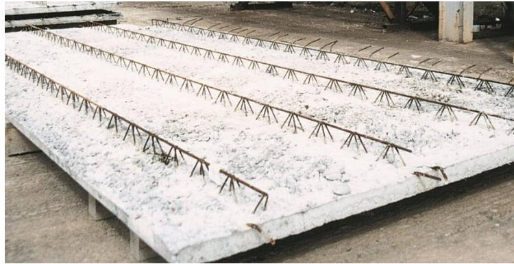
Obr. 3.22 Prefabrikovaný panel s výztužnými příhradovými nosíky [36]
