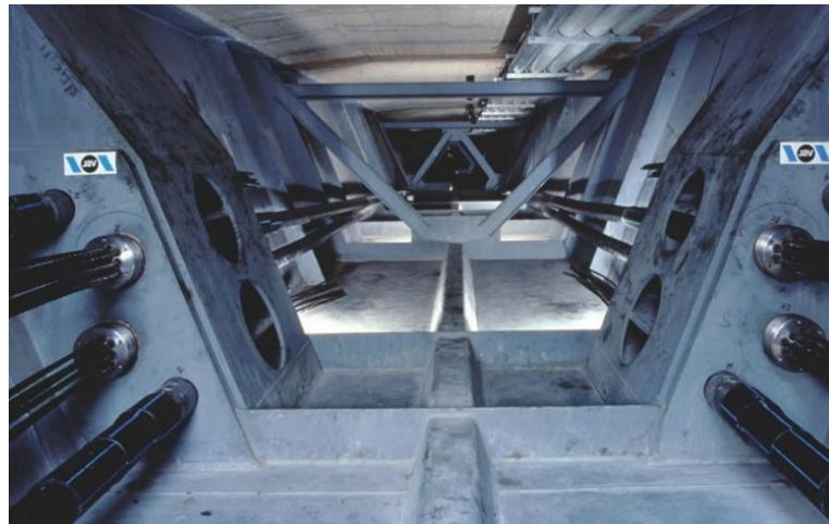
Obr. 2.2 Vnější dodatečné předpínání v mostní konstrukci [6]
