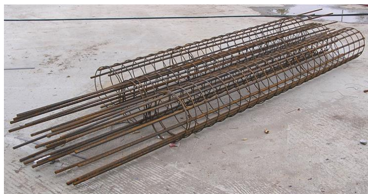
Obr. 3.15 Svařované armokoše se spirálovými třmínky
