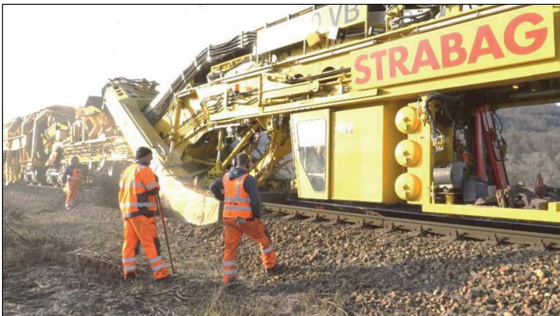
Obr. 7: Strojní čistička kolejového lože RM 900 VB [15]
