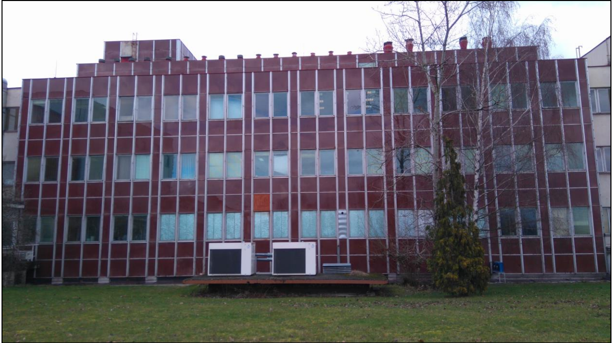
Obr. 4 západní pohled na původní stav konstrukce
