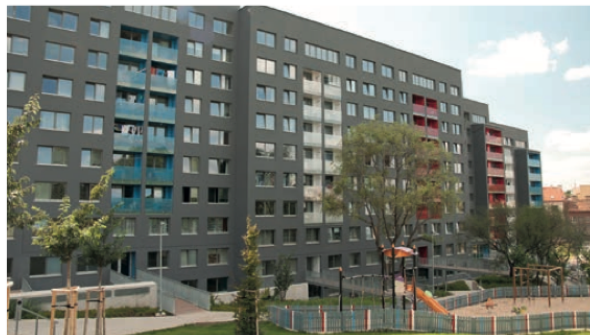
Bytový dům Lupáčova ulice, Praha – Alpolic®/fr – ACM, kombinace odstínů
