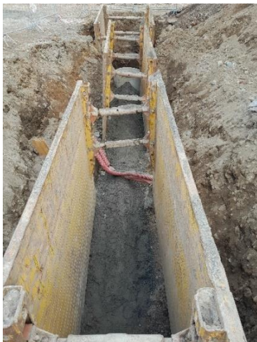
Obrázek 37: Zajištění výkopu pažíciemi boxy [autor]
