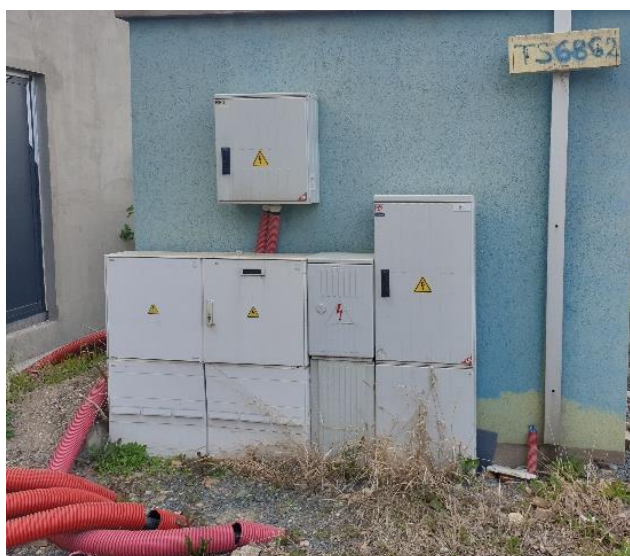
Obrázek 25: Připojovací bod elektrické energie [autor]
