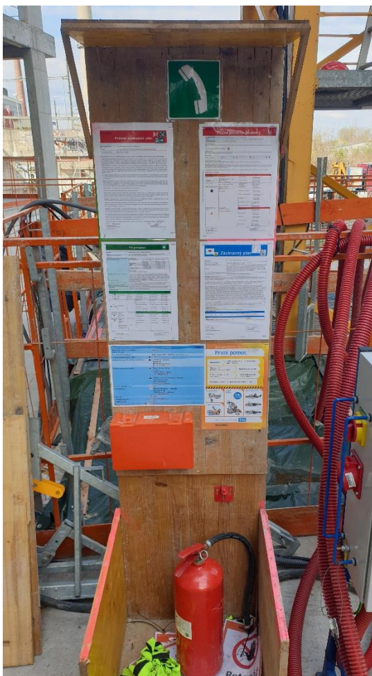
Obrázek 21: Safety point na stavbě [autor]
