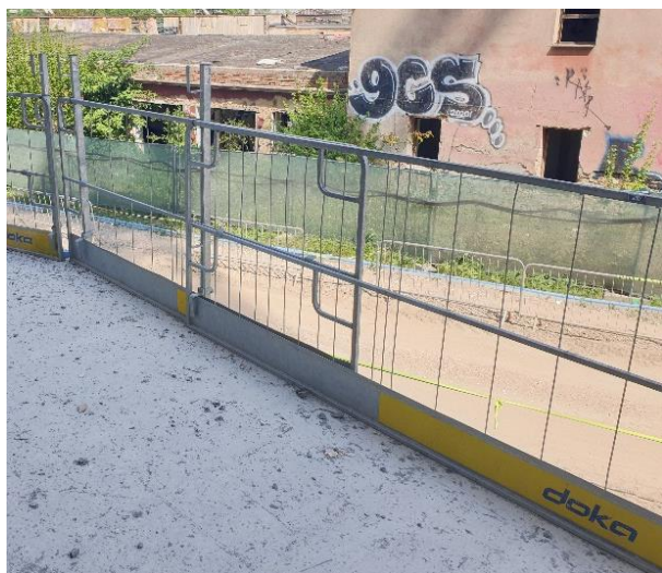
Obrázek 53: Ochrana proti pádu ve stavebním objektu [autor]
