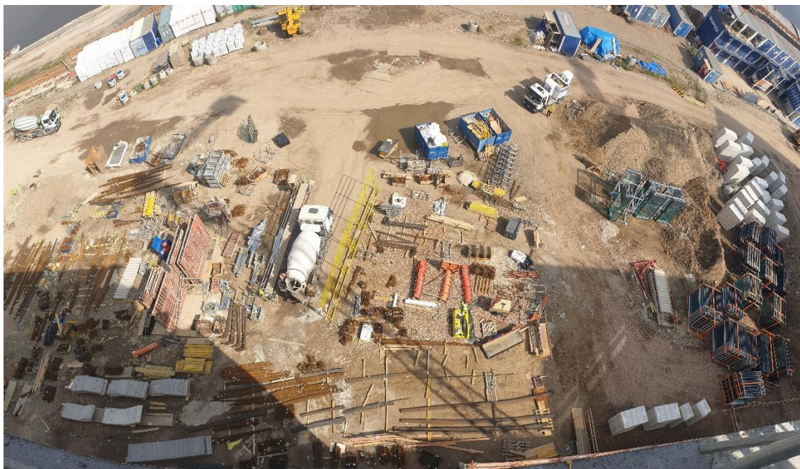
Obrázek 16: Prostor pro skladování stavebního materiálu [autor]
