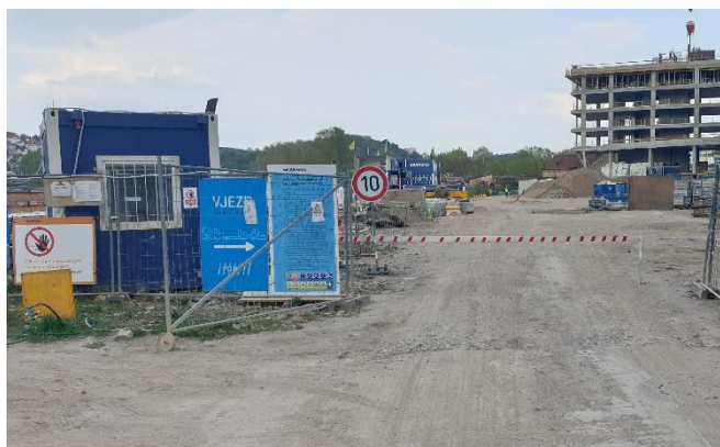
Obrázek 12: Vjezd na stavenišťe [autor]
