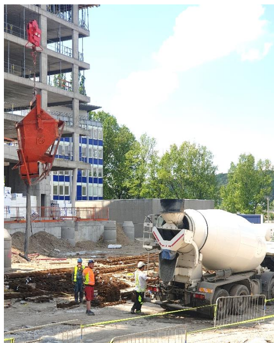
Obrázek 40: Betonáž pomocí bádie [autor]
