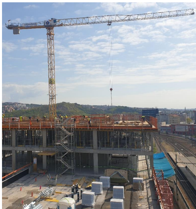
Obrázek 30: Věžový jeřáb [autor]
