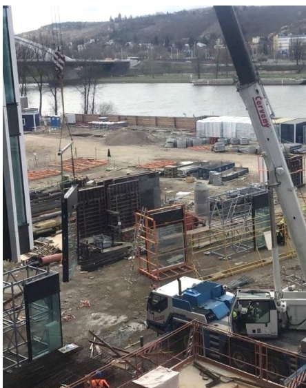
Obrázek 44: Montáž fasády [autor]
