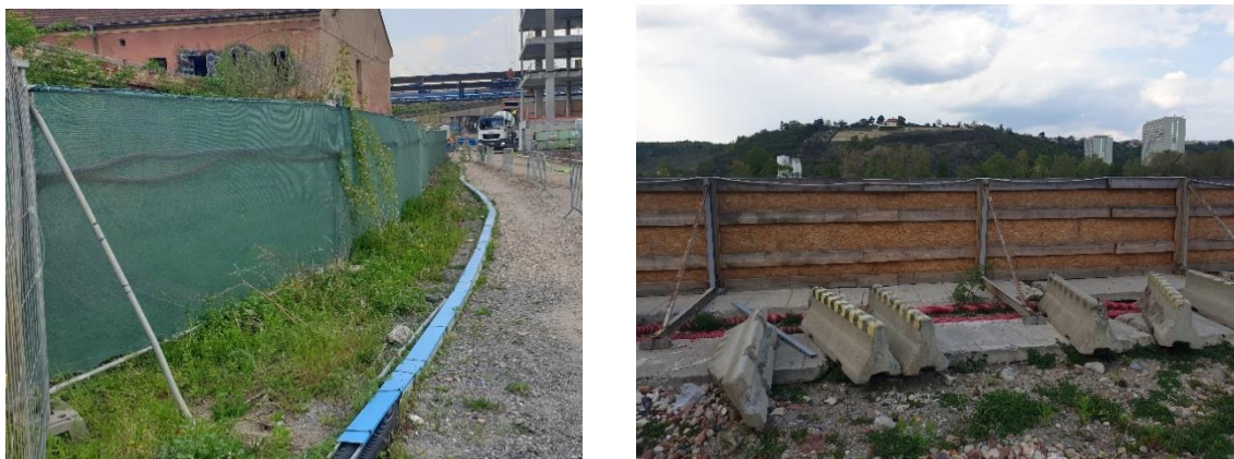
Obrázek 11: Staveništní oplocení [autor]
