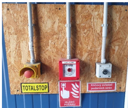
Obrázek 20: Total stop se spínačem požárního hlásiče [autor]
