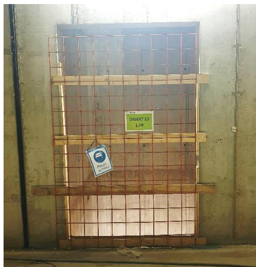
Obrázek 52: Ochrana proti pádu do výtahové šachty [autor]
