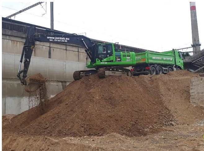
Obrázek 36: Odvoz natěžené zeminy ze stavební jámy [autor]
