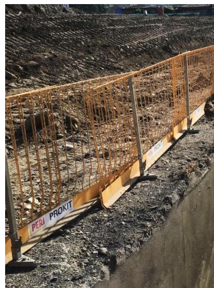
Obrázek 34: Zabezpečení proti pádu PERI PROKIT EP110 [autor]
