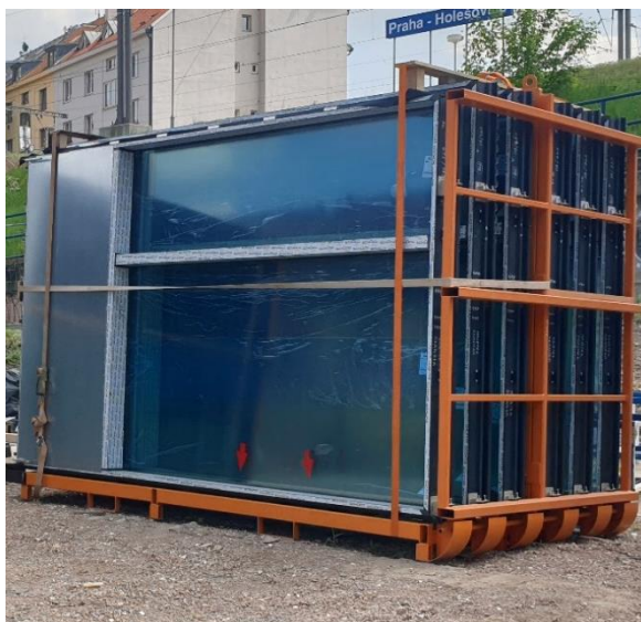
Obrázek 45: Uskladněné fasádní bloky [autor]
