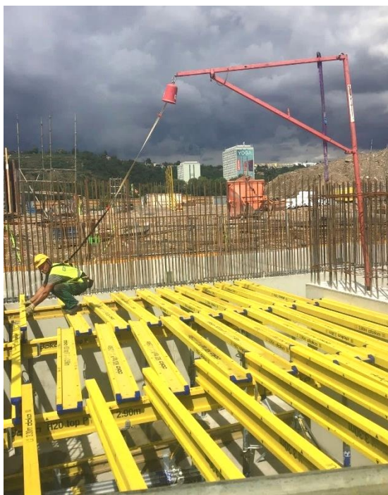
Obrázek 41: Jištění pomocí systému Alsipercha [autor]
