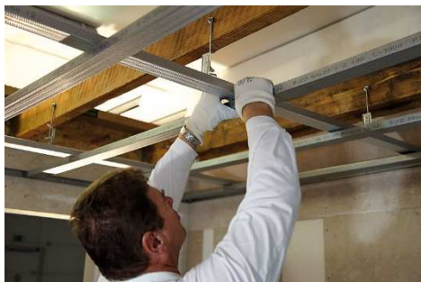
Obr. 25 Zavěšení montážních profilů (Rigips)
