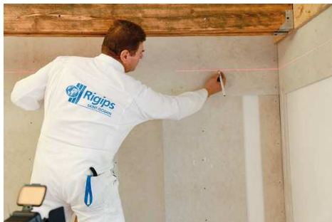
Obr. 21 Vyměření pozic obvodových profilů (Rigips)
