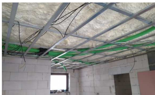
Obr. 27 Vedení instalací nad nosným roštem (Svépomocí.cz)
