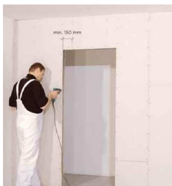
Obr. 15 Opláštění skeletové konstrukce z jedné strany (Rigips)
