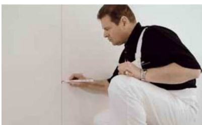
Obr. 12 Vyznačení poloh obvodových profilů (Rigips)
