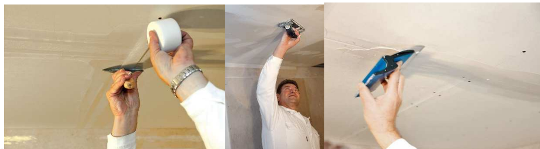
Obr. 30. 31, 32 tmelení spár a vrutů, broušení, povrchová úprava (Rigips)
