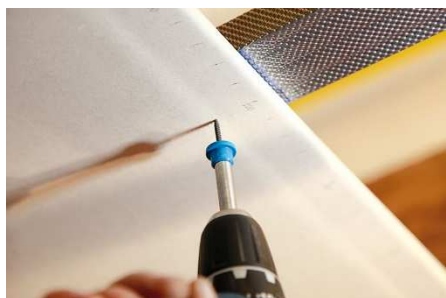
Obr. 28 Opláštění nosného roštu pohledu (Rigips)
