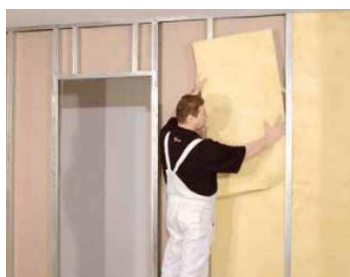
Obr.17: Vkládání zvukové izolace (Rigips)
