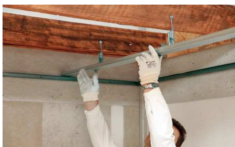
Obr. 24 Zavěšení nosných profilů R-CD
