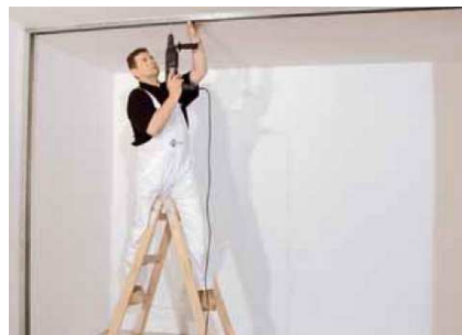
Obr. 13 Montáž obvodových profilů SDK příček (Rigips)
