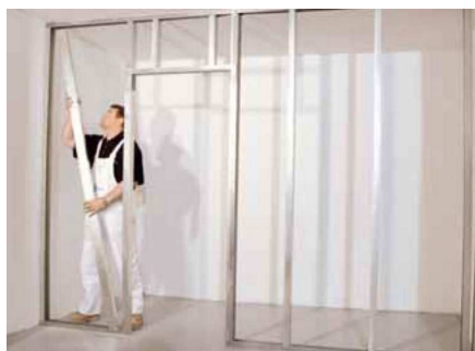
Obr. 14 Vkládání svislých profilů (Rigips)
