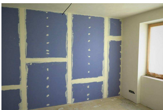
Obr. 19 Vytmelení spár a vrutů (Svépomocí.cz)
