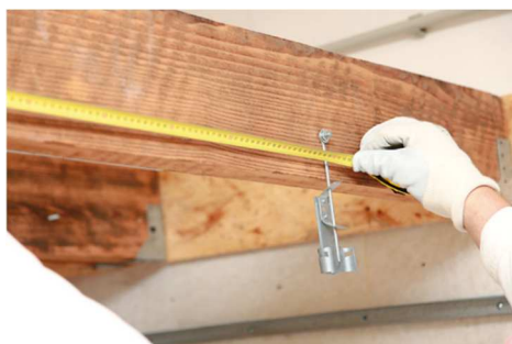
Obr. 23 Montáž pérových závěsů (Rigips)
