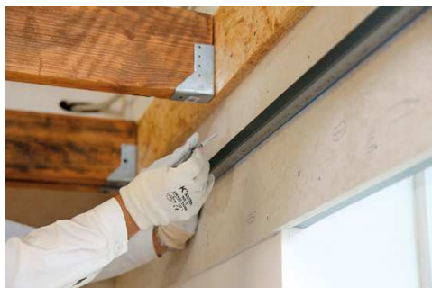
Obr. 22 Uložení obvodových profilů R-UD (Rigips)
