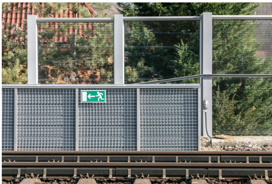
Obrázek 3.13: Sklopná protihluková clona [36]
