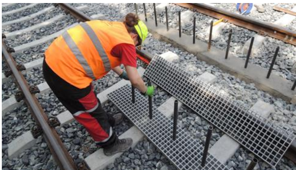
Obrázek 5.14: Kompozitní mříž použitá jako výztuž základu [41]
