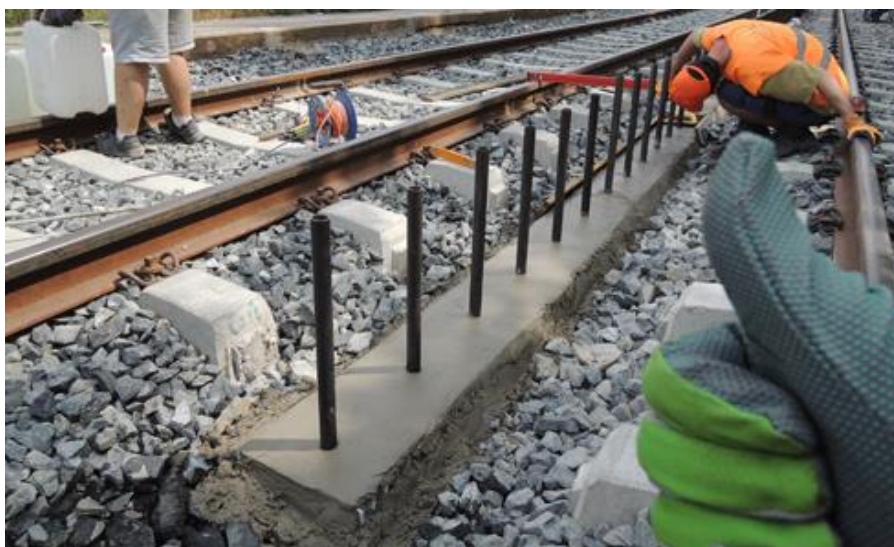
Obrázek 5.13: Uložení MPHC pomocí základu [41]
