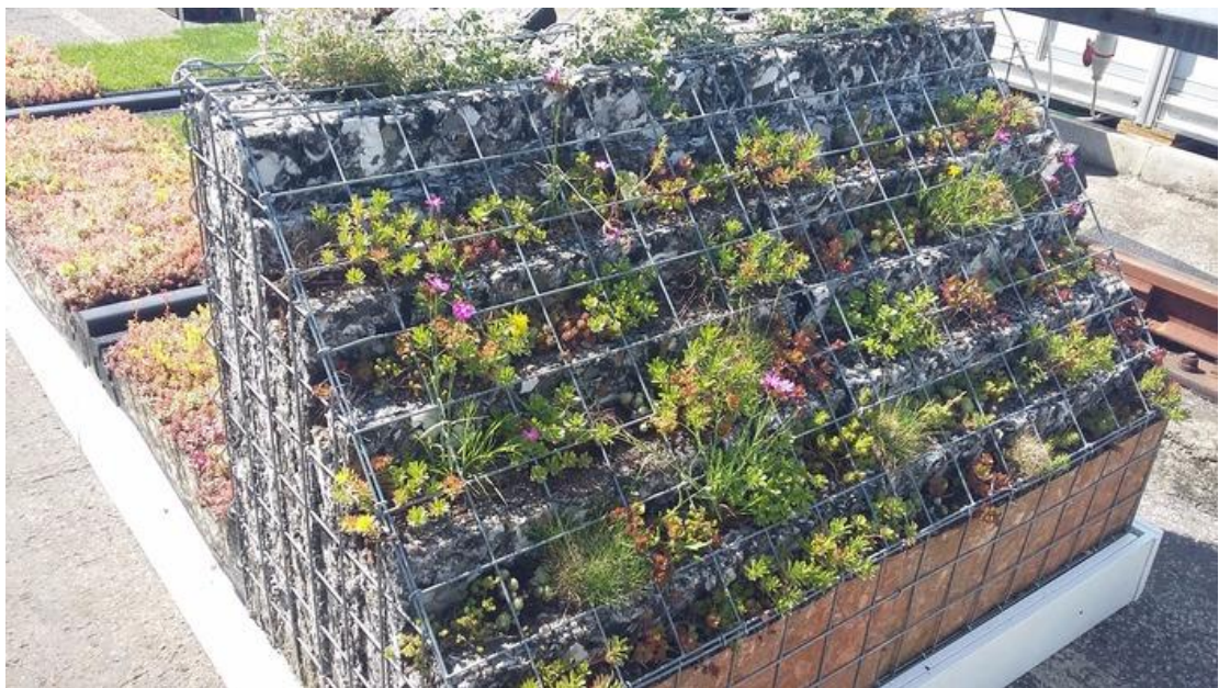
Obrázek 3.11: Gabionová clona z recyklovaného materiálu [34]
