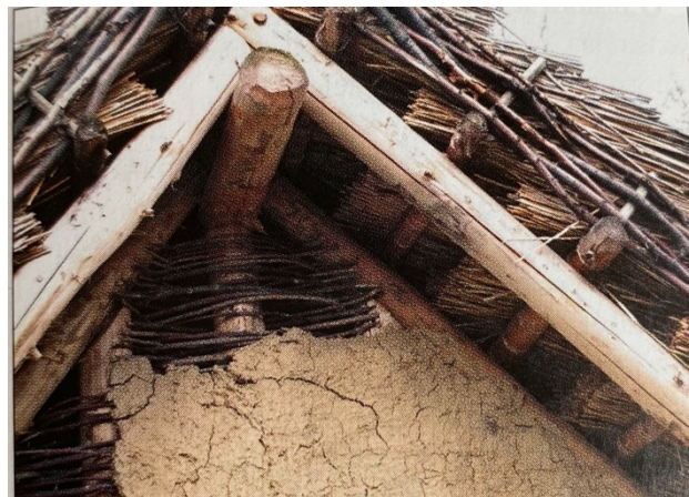
Obr.1,2: proutěné vyplétané plochy [1]
