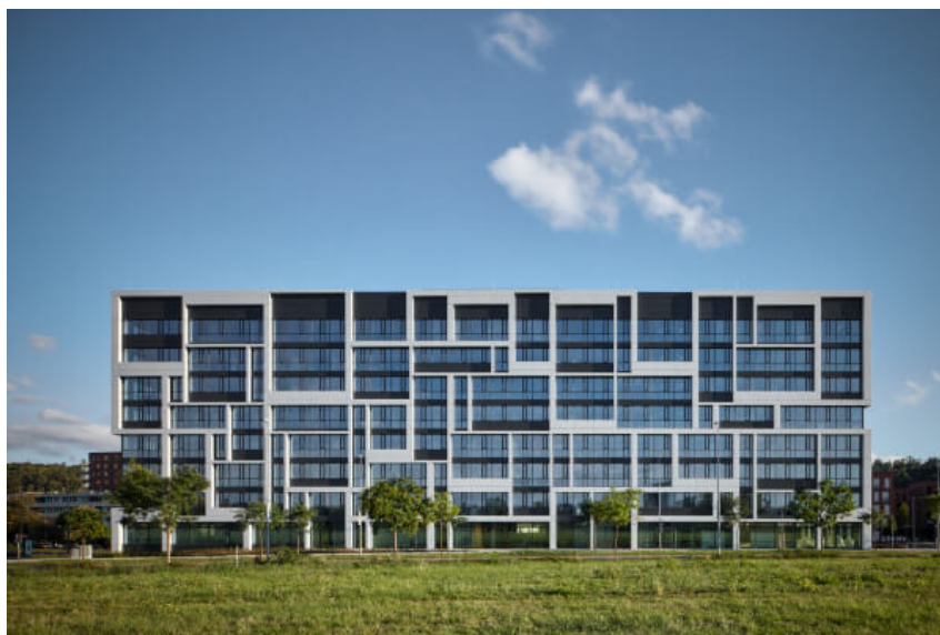
Obr.7: příklad lehkého obvodového pláště [13]
