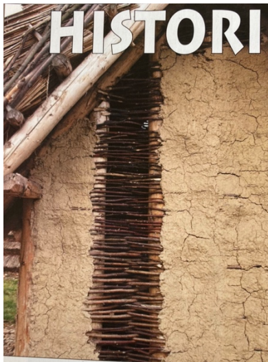
Obr.1,2: proutěné vyplétané plochy [1]
