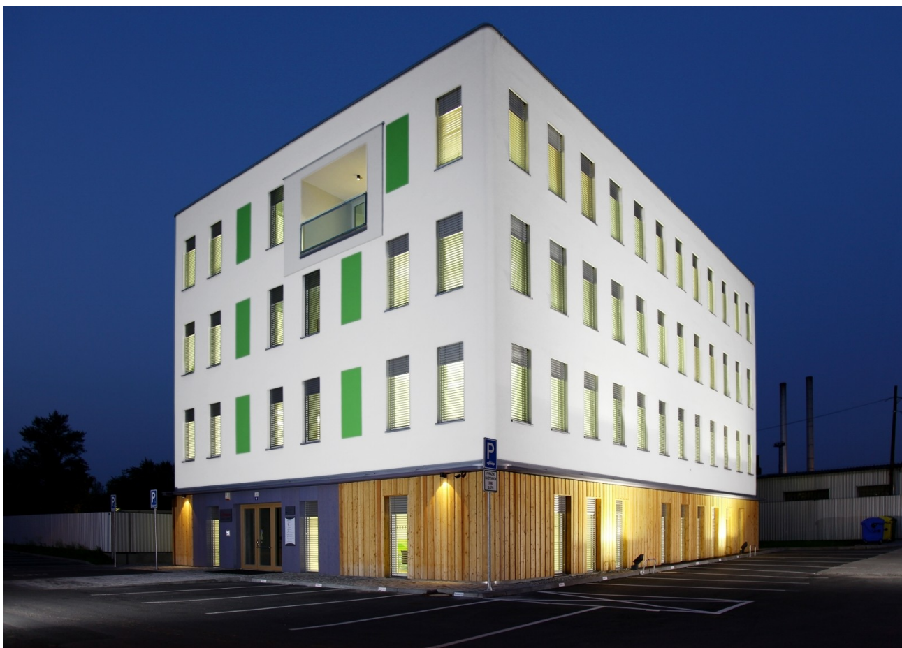
Obr. 3.1.1 – pohled na referenční stavbu INTOZA [15]
