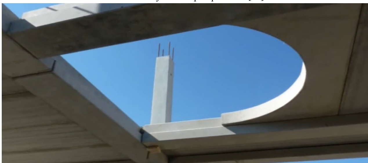
Obr. 3.1.4. Skutečná realizace při výstavbě objektu [19]
