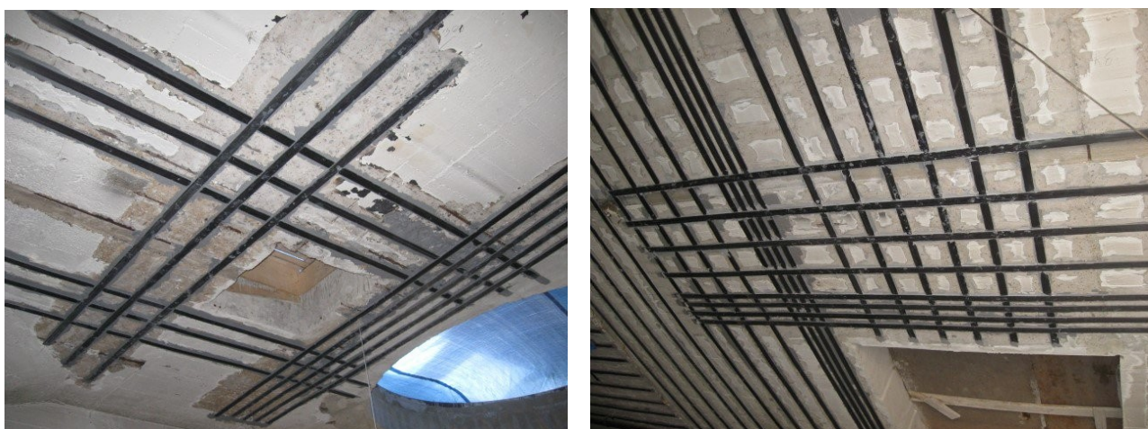
Obr. 2.3.2 - Ukázka zesílení stropní desky kolem prostupu s využitím uhlíkových lamel [13]
