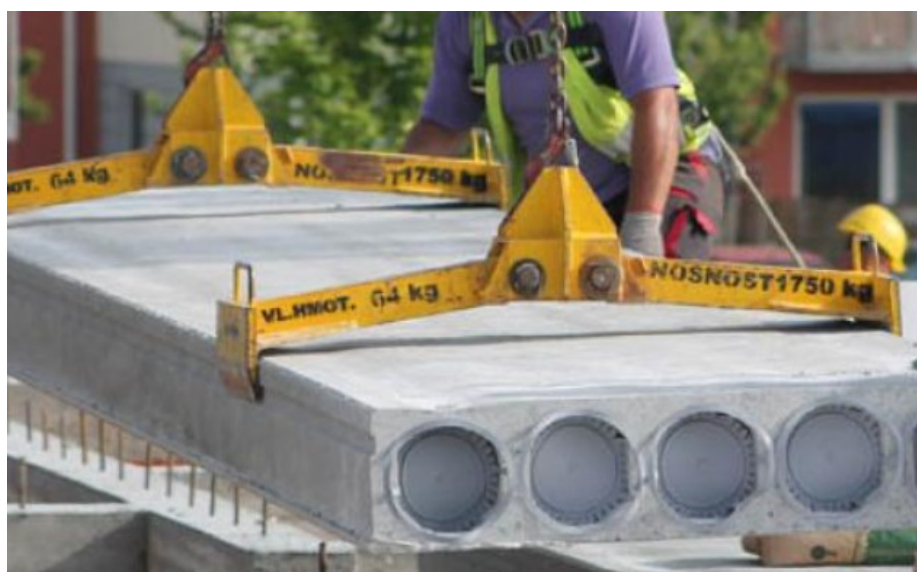
Obr. 3.1.11 – ukázka manipulačních kleští pro panely SPIROLL [25]
