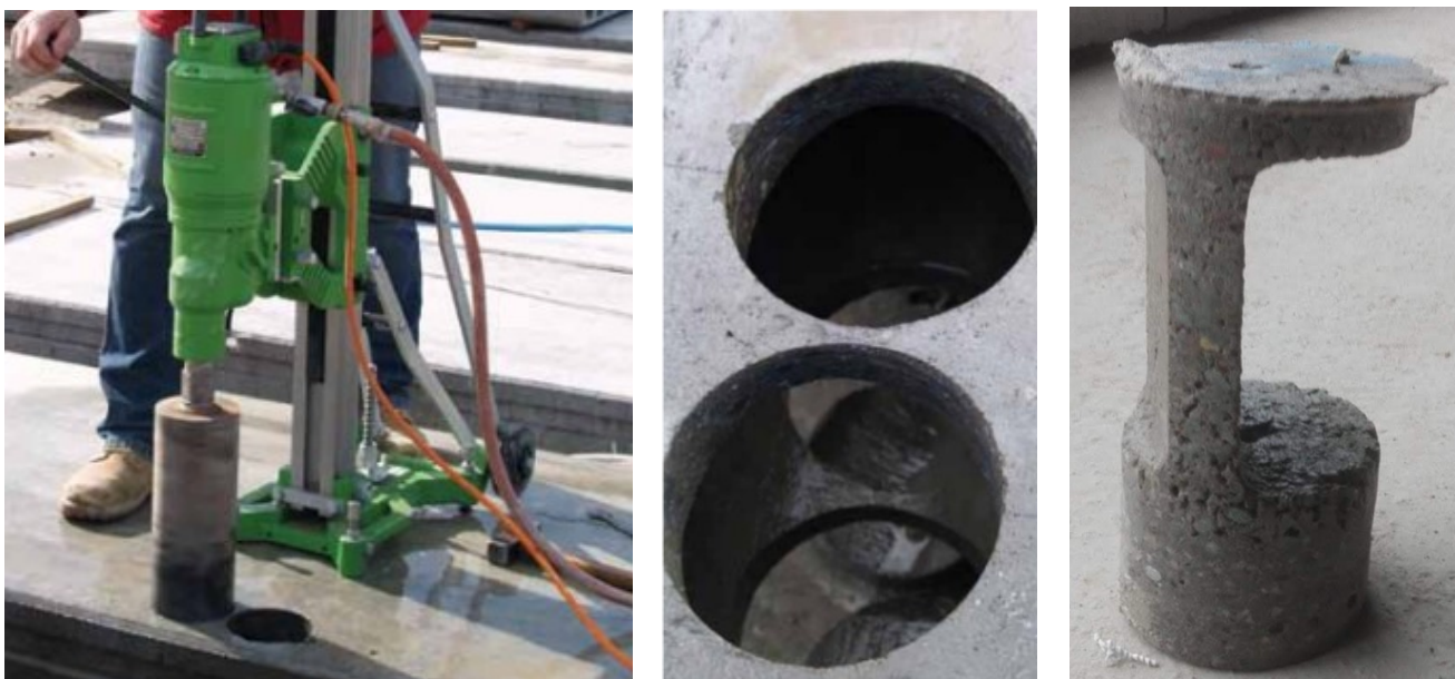
Obr. 2.3.1- Jádrové vrtání do předpjatého panelu. [10]
