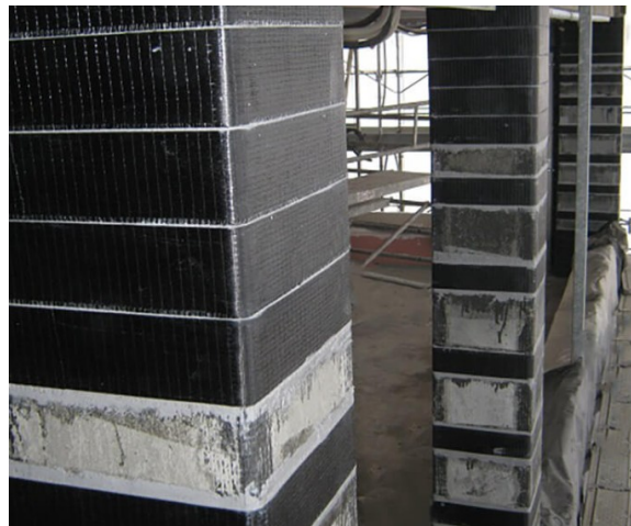
Obr. 2.3.4 – Ukázka zesílení sloupu uhlíkovou tkaninou [ ]
