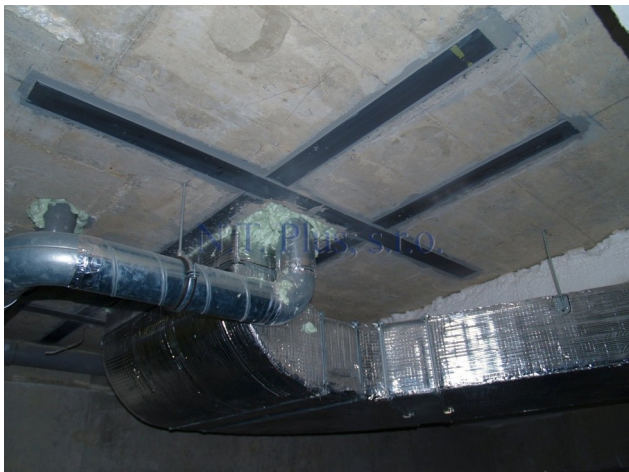
Obr. 2.3.3 – Ukázka zesílení stropní desky kolem prostupu uhlíkovou tkaninou [14]
