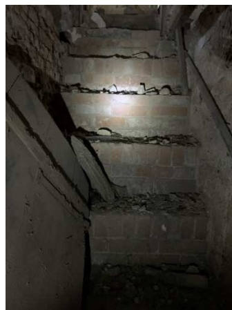
Obr. 30: Schodiště do malého sklepu
