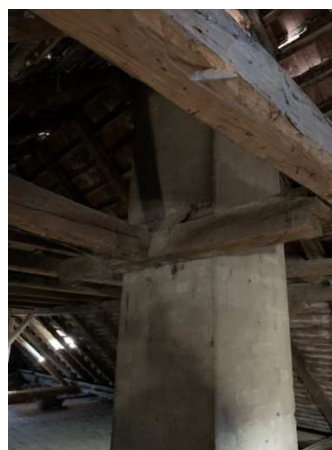
Obr. 34: Komínové těleso ve 2.NP
