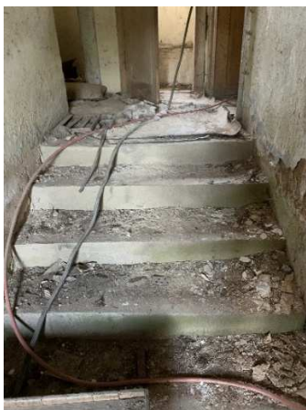
Obr. 29: Schodiště u východního vchodu
