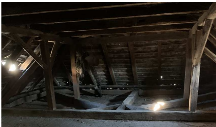
Obr. 24: Hlavní vazba krovu s valbovou částí střechy a diagonálními vazními trámy
