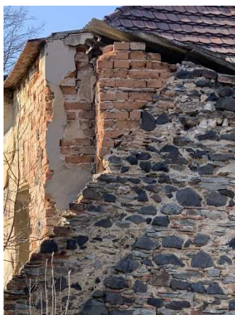
Obr. 100: Jihovýchodní roh objektu
