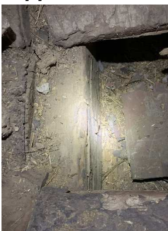
Obr. 17: Záklop a trámy
