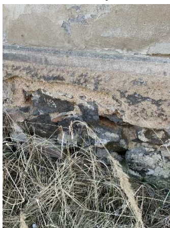
Obr. 69: Odhalené soklové zdivo z exteriéru
