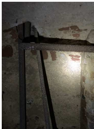
Obr. 77: Prostup P v patě klenby u komínového tělesa
