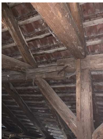
Obr. 26: Spoj vaznic, sloupku krokve, hambalku a pásků
