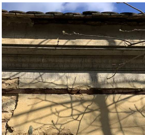
Obr. 10: Římsa z exteriéru s ocelovým páskem pod římsou
