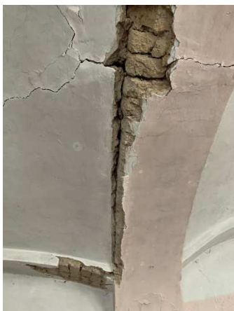
Obr. 73: Poškozený příčný klenební pás
