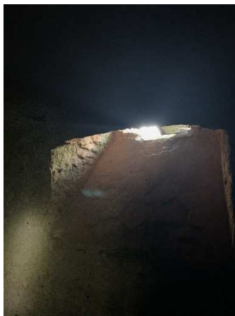
Obr. 36: Okenní otvor O7 velkém sklepu
