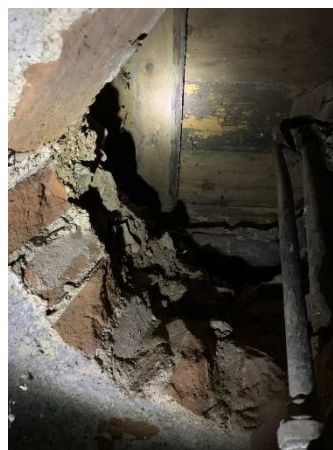
Obr. 21: Pohled otvorem v patě klenby velkého sklepa na konstrukci podlahy 1.NP
