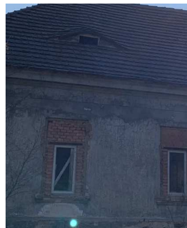
Obr. 37: Severní pohled na otvor O9 – volské oko
