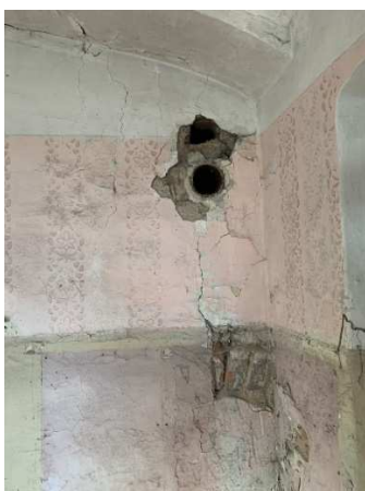
Obr. 33: Kruhový vývod pro napojení kamen
