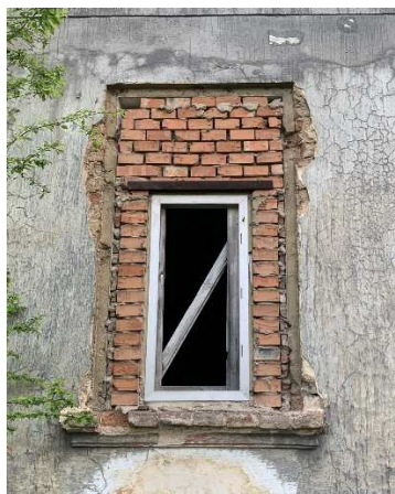
Obr. 35: Dozděný otvor O3
