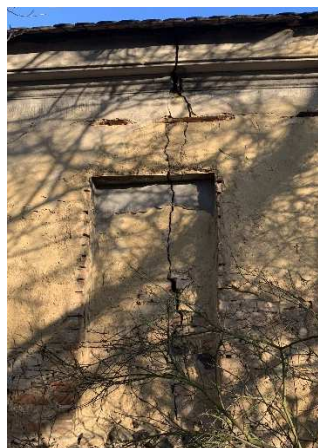
Obr. 59: Pohled z exteriéru I1e
