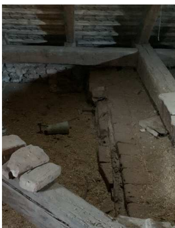
Obr. 16: Půdovky na násypu klenby (vlevo) a na v konstrukci trámového stropu (vlevo)
