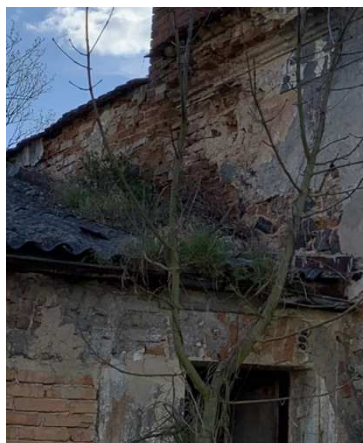
Obr. 98: Vegetace na střešním plášti
