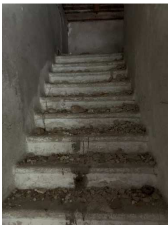
Obr. 28: Schodiště do 2.NP
