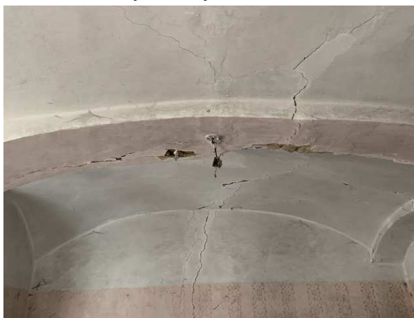
Obr. 11: Podélný pohled místnosti na západní obvodovou stěnu
