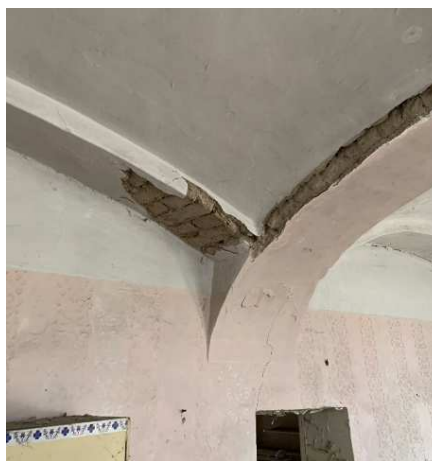
Obr. 12: Styk klenebních pásů a vnitřní stěny
