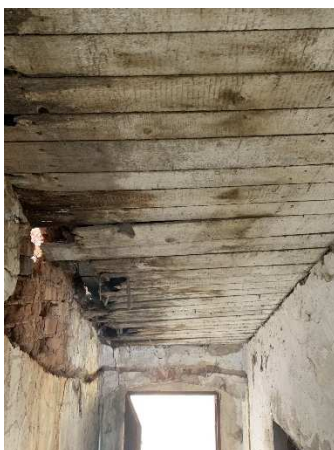
Obr. 20: Podbití trémové konstrukce latěmi
