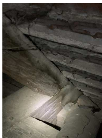
Obr. 27: Spoj krokve, vazního trámu a pozednice
