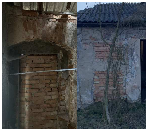
Obr. 43: Vnitřní a venkovní pohled na zazděný dveřní otvor DZ
