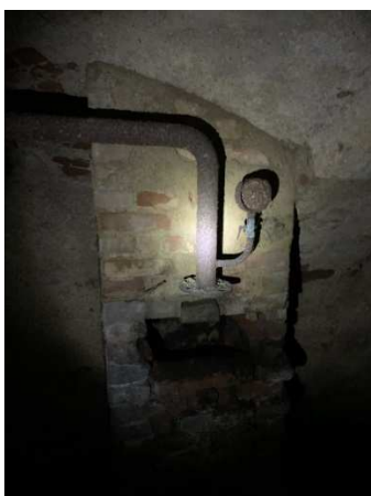
Obr. 32: Otvor komínu ve velkém sklepu
