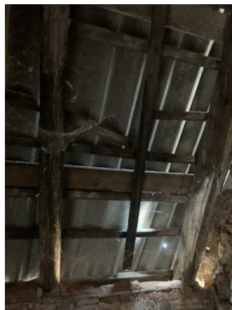
Obr. 80: Nepravidelné a poškozené roznášecí latě
