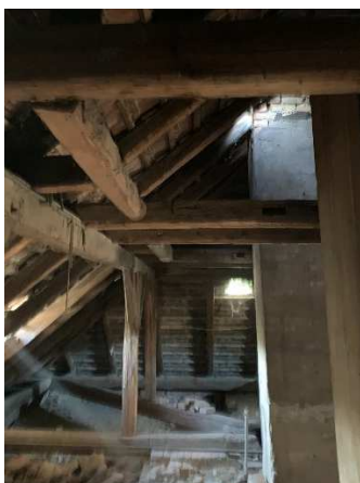
Obr. 88: Chybějící výměny mezi hambalky
