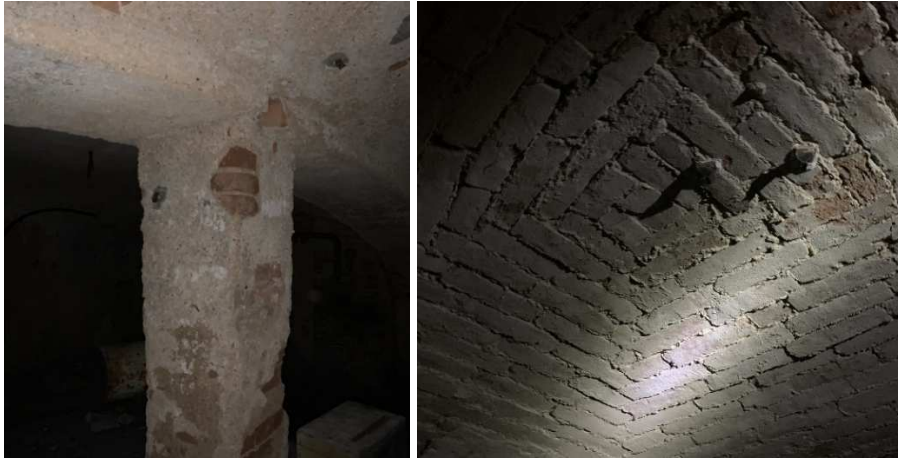
Obr. 13: Pilíř s klenbním pásem Obr. 14: Vrchol klenby v malém sklepe ve velkém sklepe
