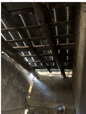
Obr. 19: Zastřešení východní části budovy
