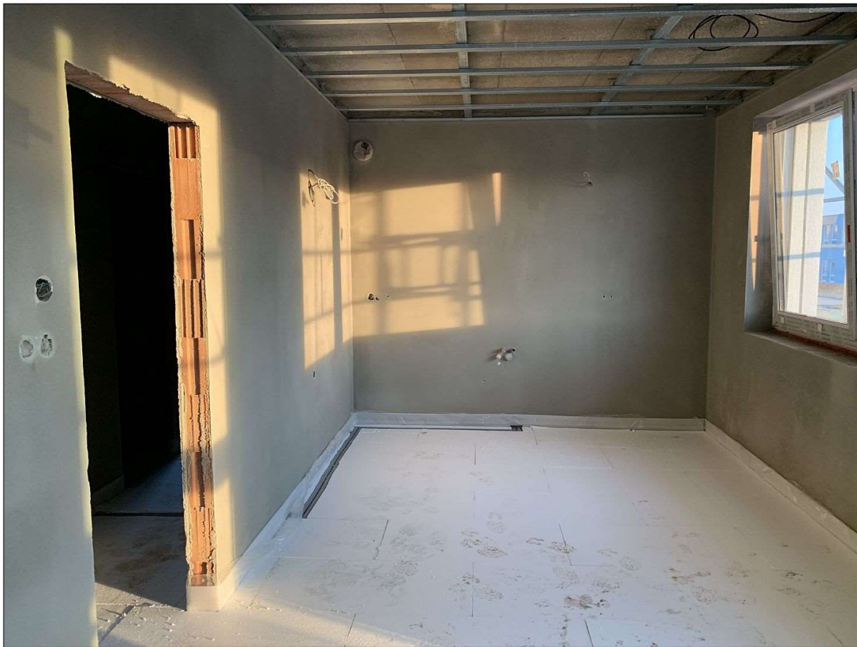
Obrázek 14 - vnitřní úpravy povrchů
