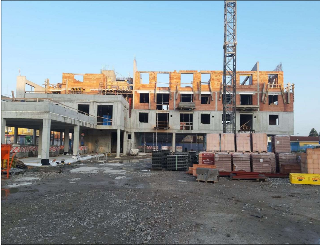
Obrázek 8 - hrubá vrchní stavba
