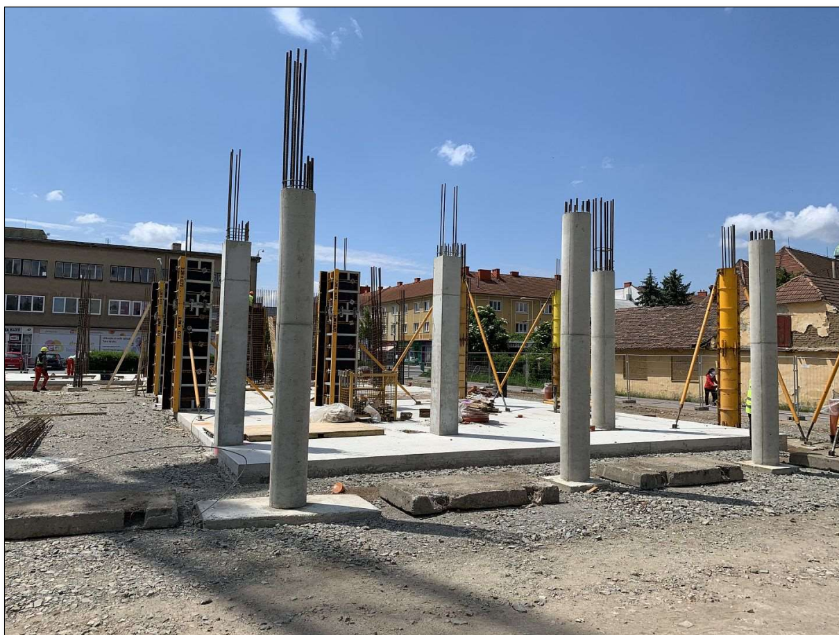
Obrázek 6 - hrubá vrchní stavba
