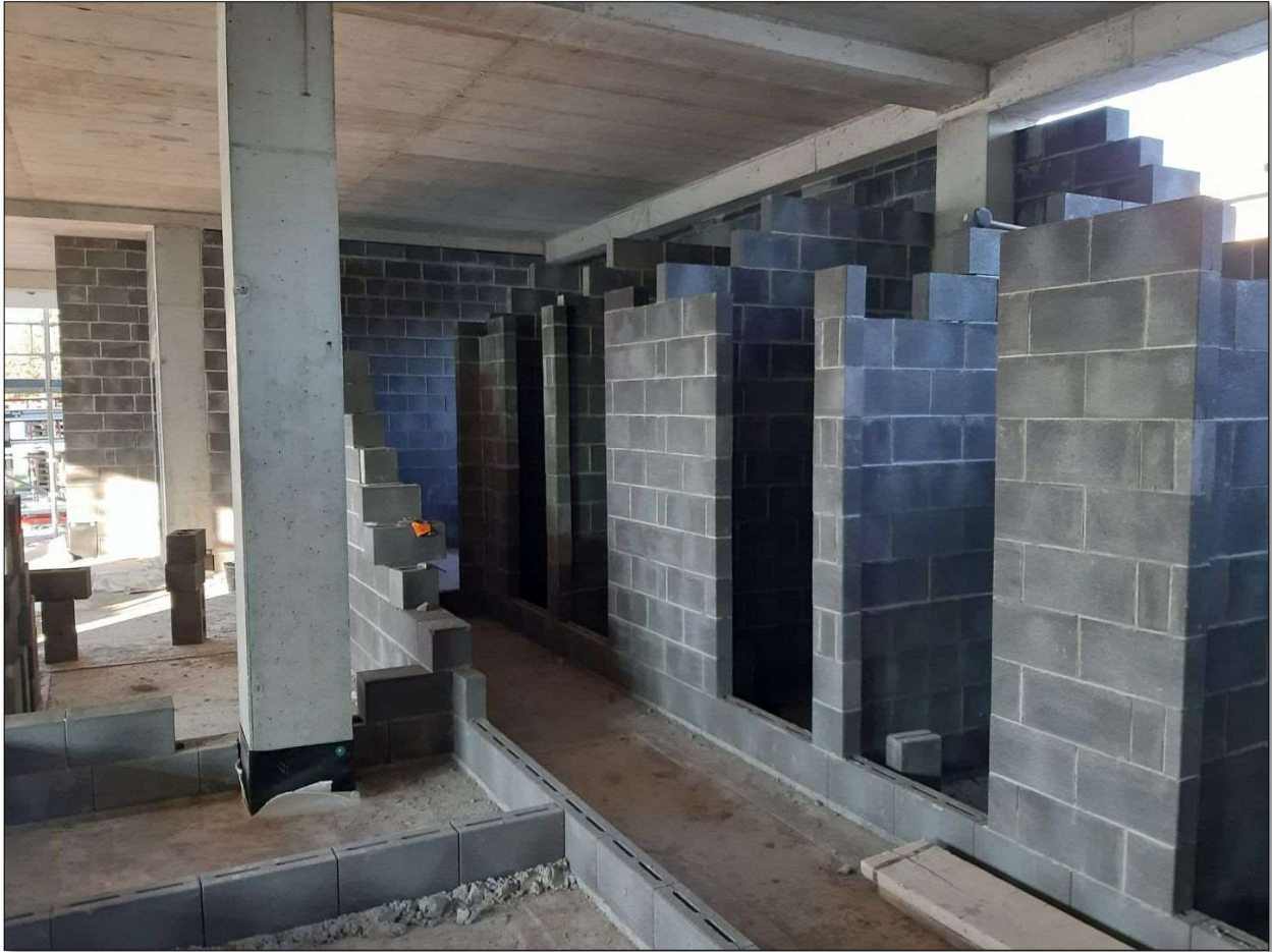
Obrázek 12 – hrubé vnitřní práce
