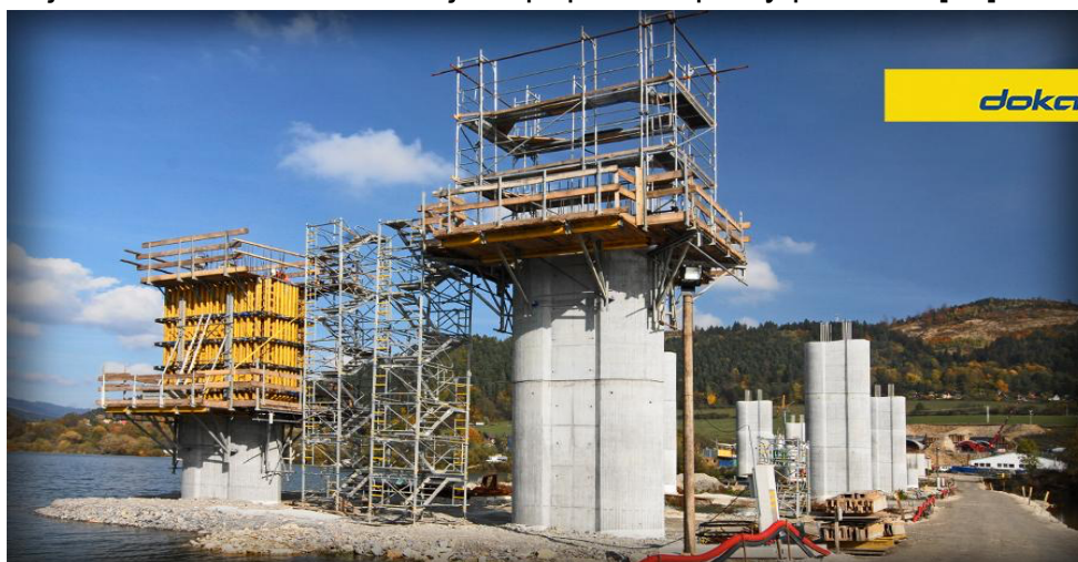
Obrázek 12 Posuvné bednění od firmy DOKA [24]
