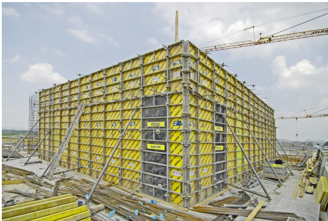
Obrázek 8 Rámové bednění stěn od firmy DOKA [21]
