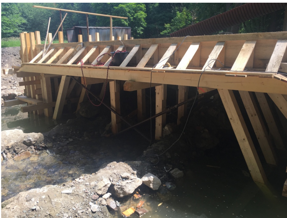
Obrázek 58 Realizace bednění mostu – Sedlejšovice, zdroj: vlastní
