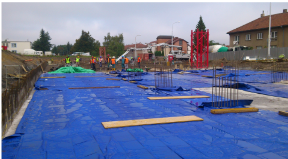
Obrázek 22 Příklad zakrytí konstrukce po betonáži [29]
