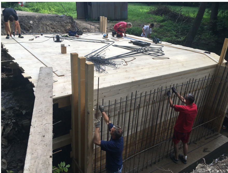
Obrázek 3 Realizace tesařského bednění mostu, zdroj: vlastní
