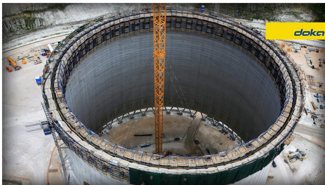
Obrázek 13 Šplhavé bednění od firmy DOKA [25]
