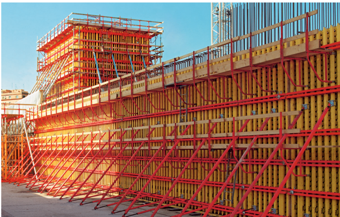
Obrázek 7 Nosníkový systém bednění stěn od firmy PERI [22]
