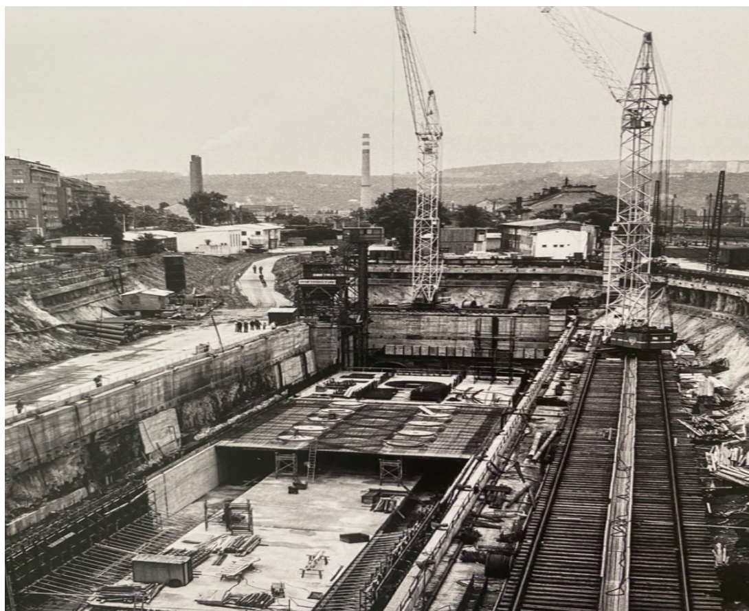
Obrázek 6 Montáž bednění nad nástupištěm stanice Vltavská 1981 [9]
