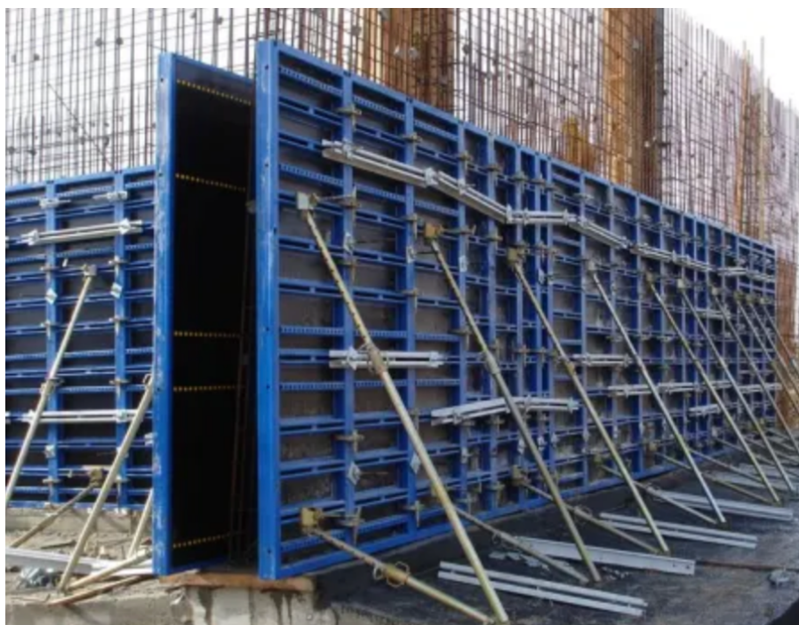
Obrázek 19 Plastové systémové bednění [26]
