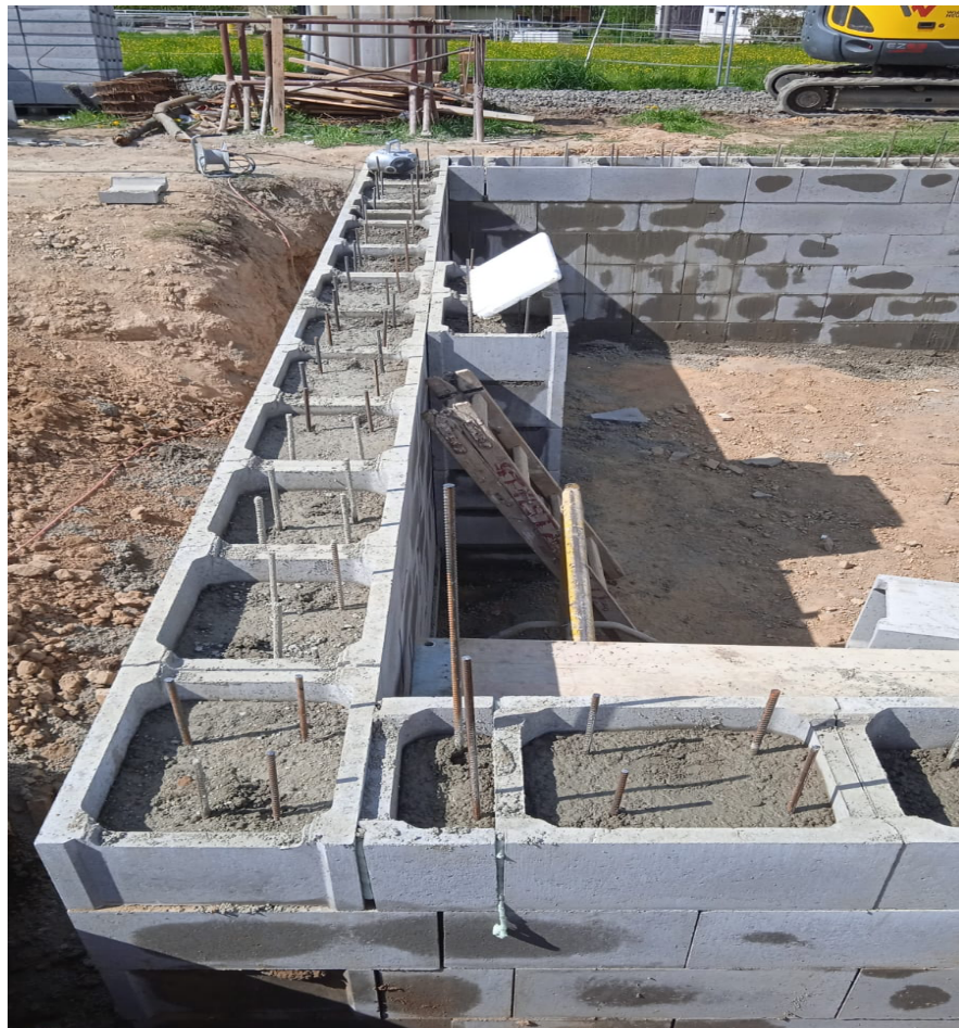
Obrázek 9 Betonové bloky typu ztracené bednění, zdroj: vlastní
