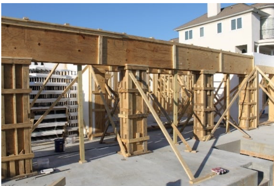
Obrázek 2 dřevěné bednění sloupů a průvlaku [23]
