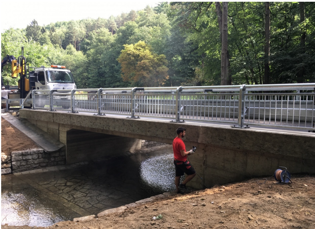
Obrázek 53 Dokončovací práce most – Sedlejšovice, zdroj: vlastní
