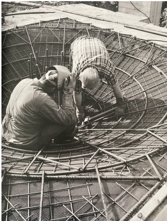
Obrázek 4 bednění sloupové hlavice [16]
