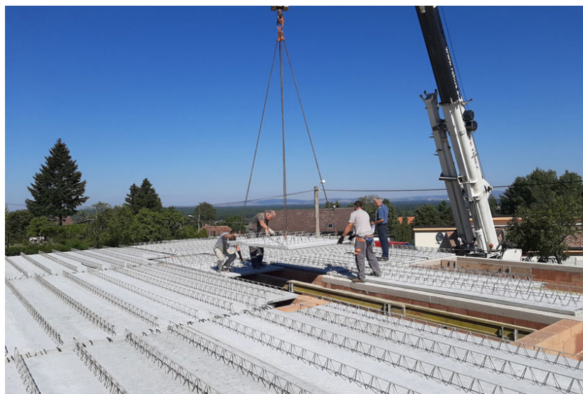
Obrázek 10 Montáž filigránového stropu [20]
