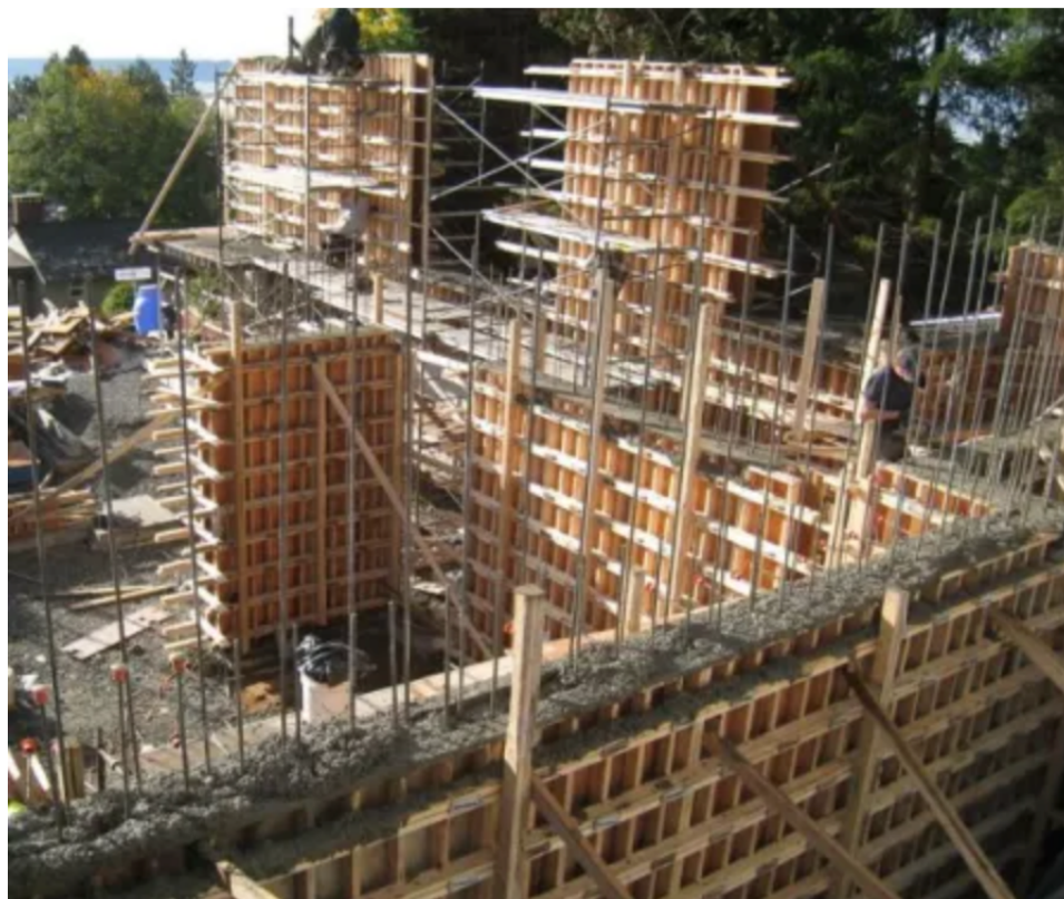
Obrázek 14 Dřevěné bednění stěn [26]
