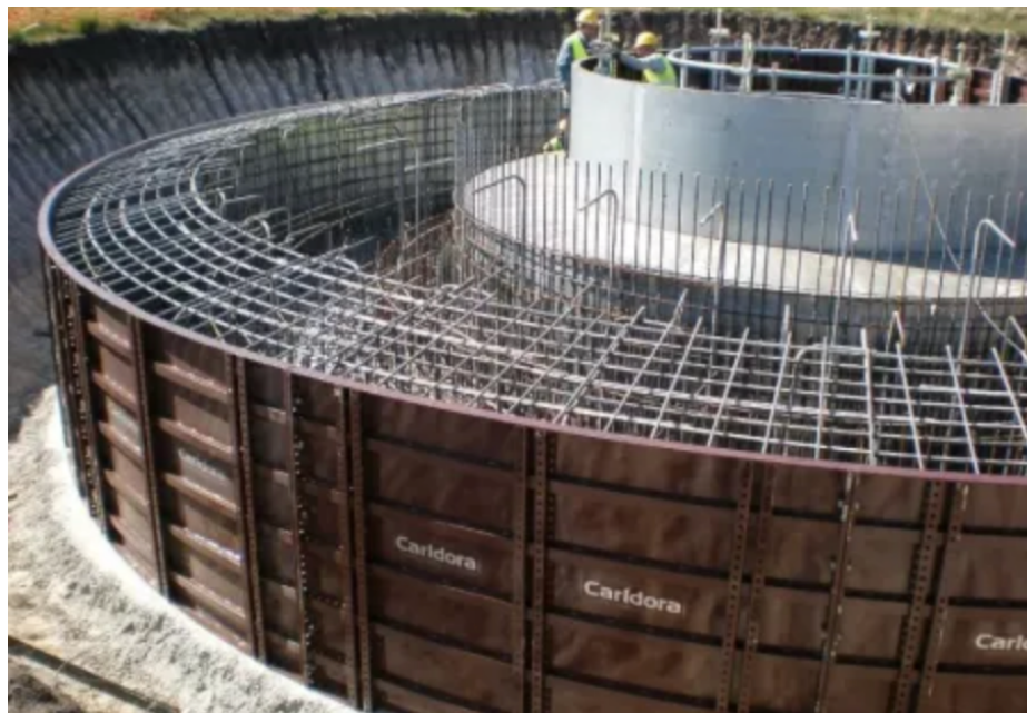
Obrázek 16 Kruhové ocelové bednění [26]
