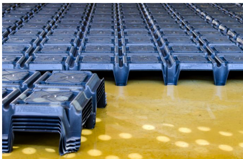
Obrázek 11 Plastové ztracené bednění [19]
