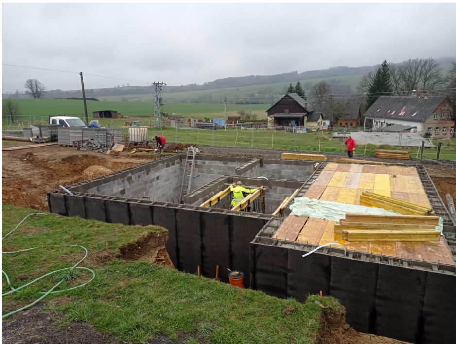
Obrázek 57 Realizace bednění nad 1.PP rodinného domu, zdroj: vlastní
