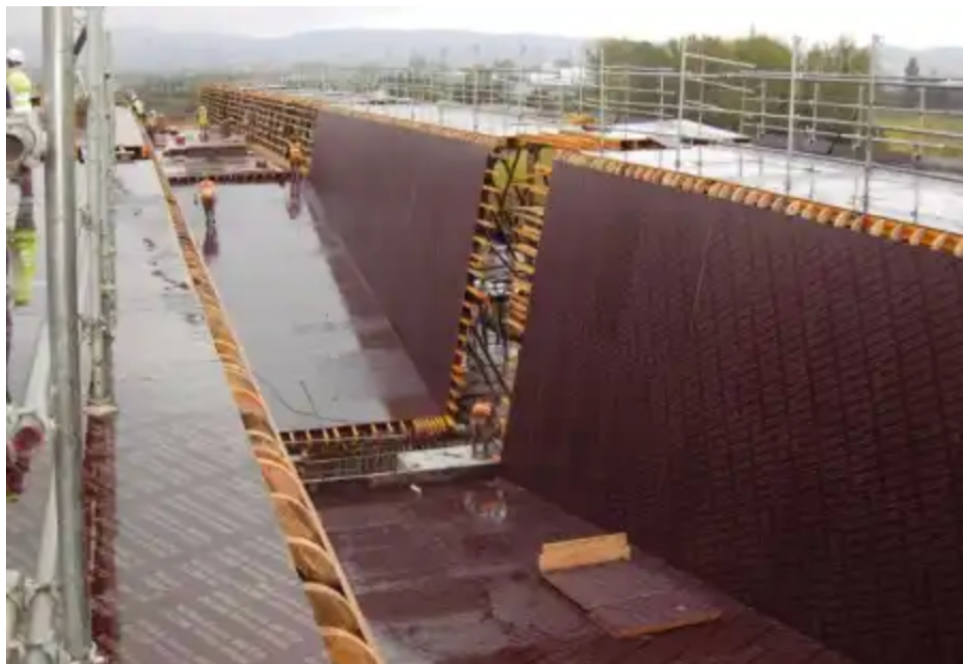
Obrázek 15 Příklad použití překližky jako bednicí desky [26]
