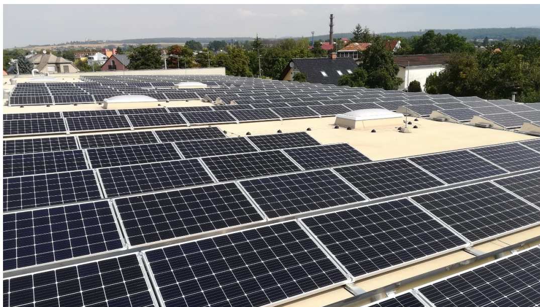
Obrázek 7 – ukázka FVE s použitím samozatěžovací konstrukce na střešní konstrukci
