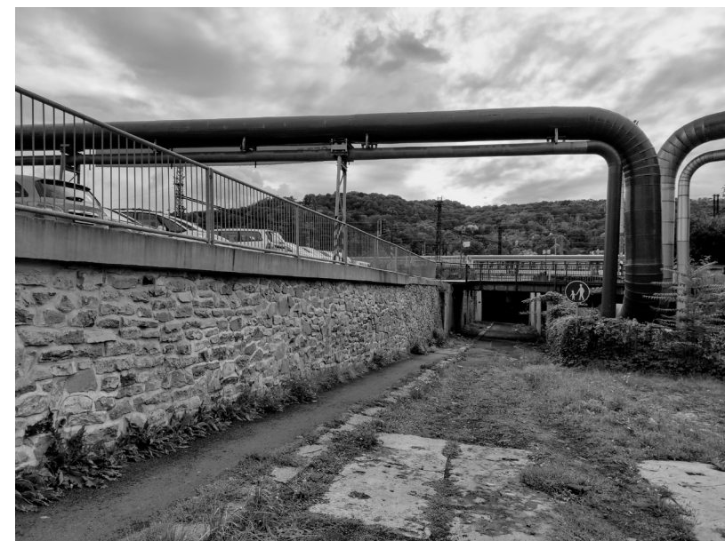
11_Pěší podchod pod kolejí
