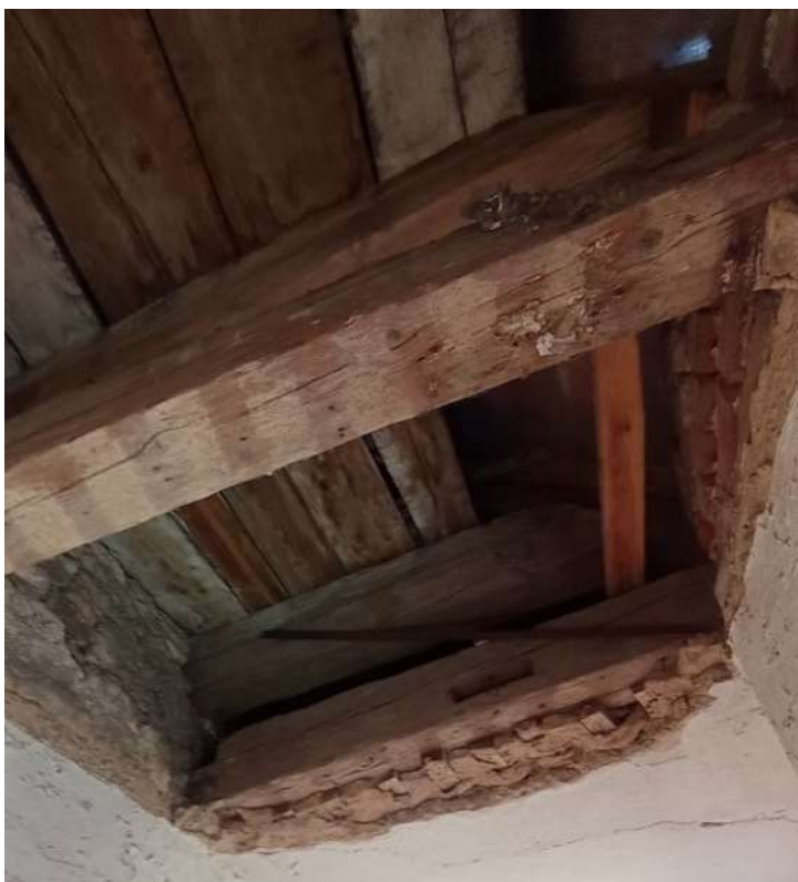
Obrázek 9 - Strop 2.NP v místnosti č. 223
