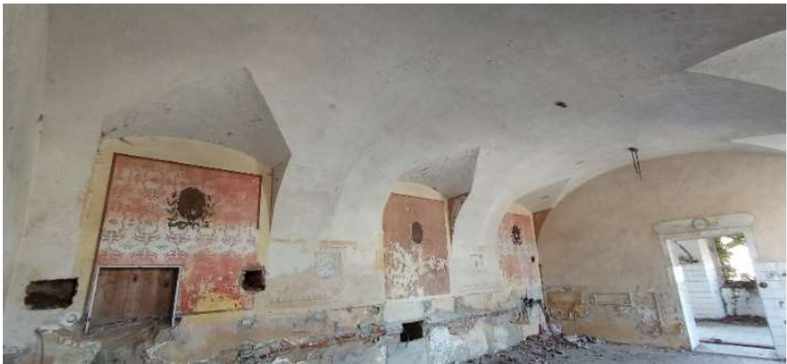
Obrázek 6 - Strop 1.NP v místnosti č. 106
