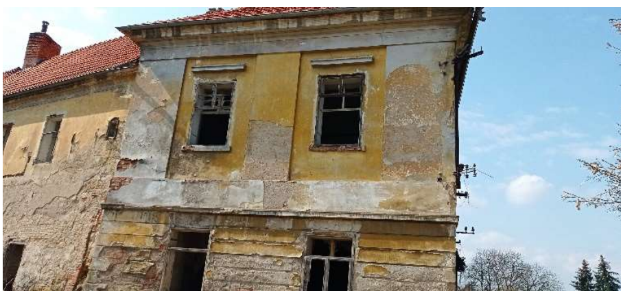
Obrázek 18 - Východní strana severního křídla
