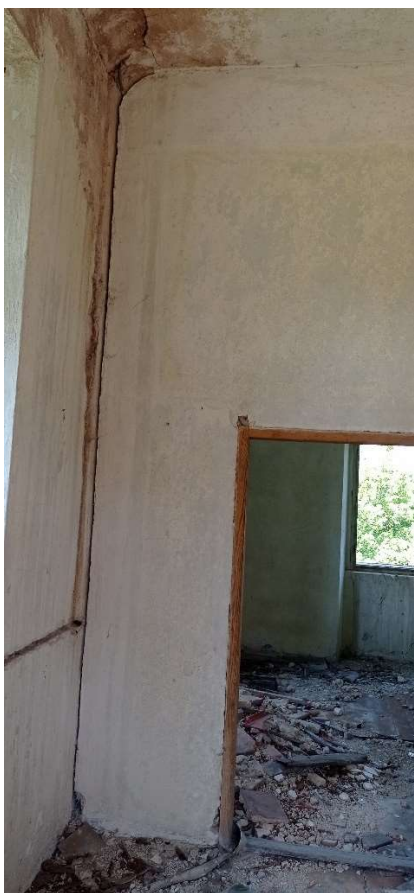
Obrázek 41 - Porucha P27 – porušení příčky Obrázek 42 - Porucha P60 – trhliny hrázděné příčky
