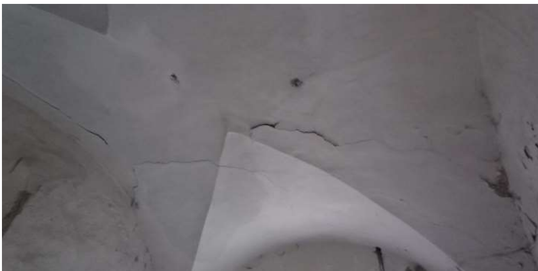
Obrázek 7 - Strop 1.NP v místnosti č. 112
