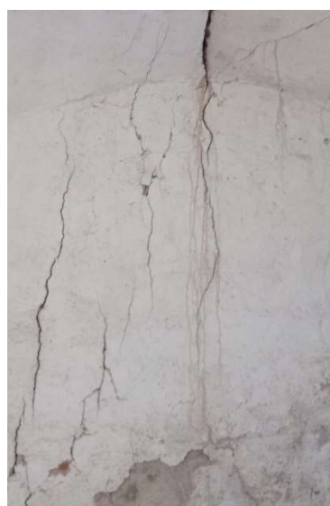
Obrázek 26 – Porucha P67 – trhлина
