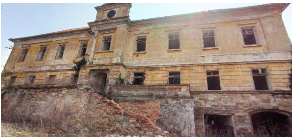
Obrázek 4 - Severní fasáda zámku
