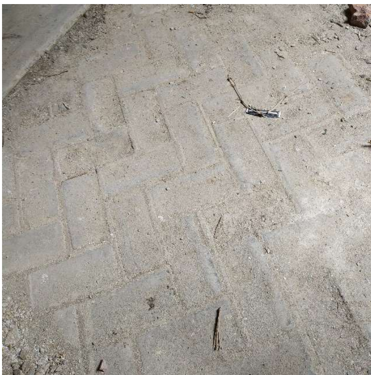
Obrázek 22 - Příklad podlahy z pálených cihel
