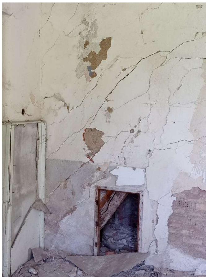
Obrázek 41 - Porucha P27 – porušení příčky Obrázek 42 - Porucha P60 – trhliny hrázděné příčky
