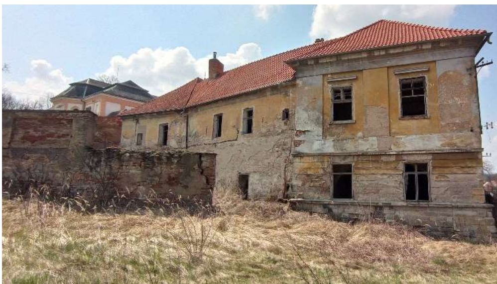
Obrázek 5 - Východní fasáda zámku
