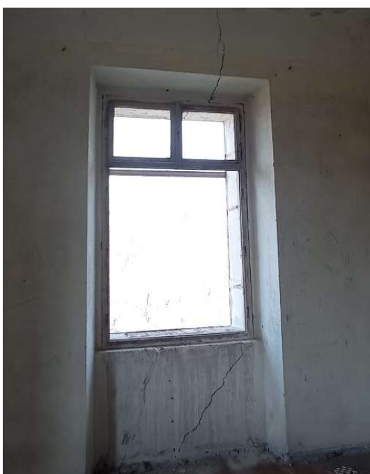
Obrázek 19 - Okno v 2.NP z interiéru
