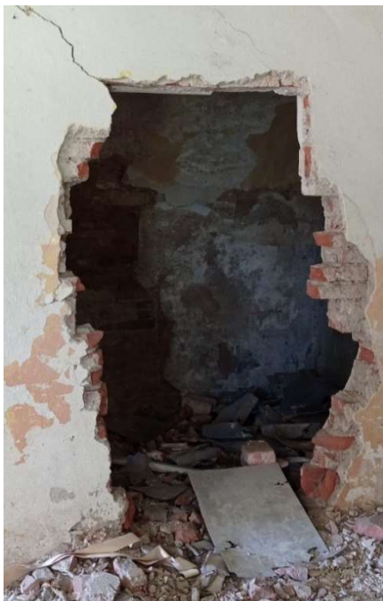
Obrázek 39 - Chybějící zárubeň
