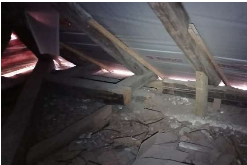
Obrázek 14 - Přerušení pozednice krovu
