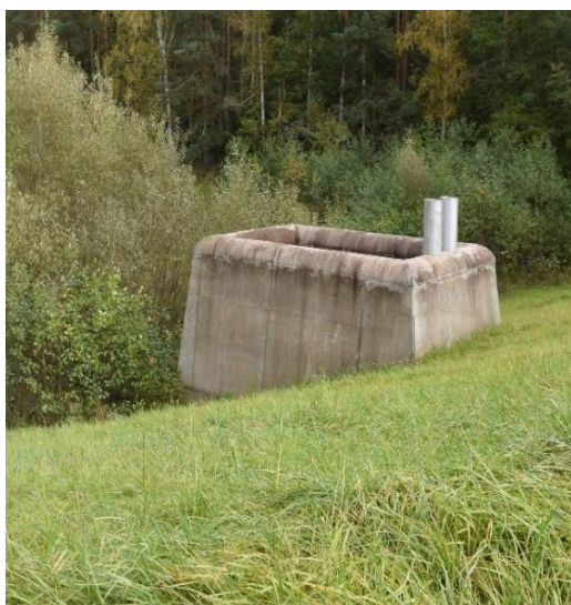
Obr. 21 – Suchá nádrž na Klapovském potoce – sružený objekt se šachtovým přelivem (autor Ing. P. Balvín, Phd.)
