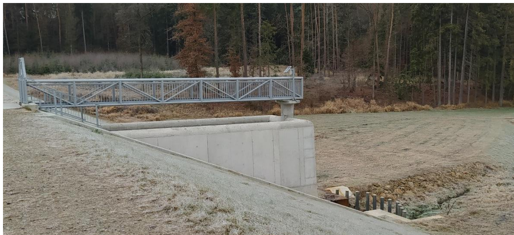
Obr. 17 – Suchá nádrž na Bílském potoce – jednopatrový sdužený objekt s bezpečnostním přelivem, s výpustí zaústěnou do čelní stěny a s otevřeným odpadem od přelivu (autor Veronika Táboříková)
