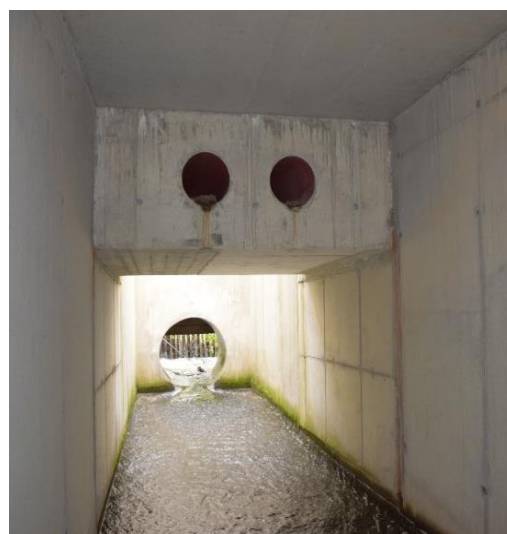
Obr. 21 – Suchá nádrž na Klapovském potoce – sružený objekt se šachtovým přelivem (autor Ing. P. Balvín, Phd.)
