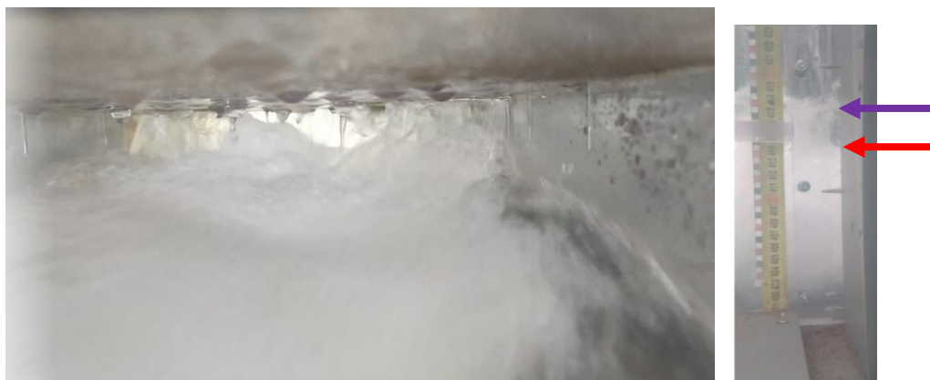
Obr. 58 – Pohled odpadním objektem směrem do spadiště pro průtok 18,0 l/s
