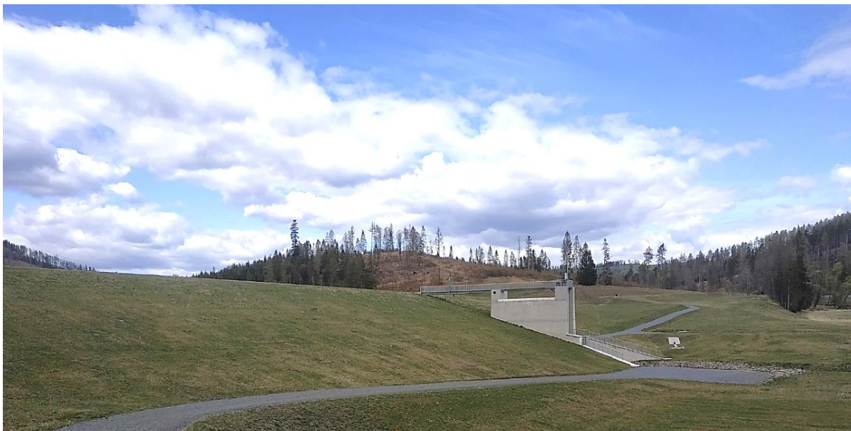
Obr. 2 – Suchá nádrž typu přehrady – Suchá nádrž Jelení [8] (pozn. obrázek zmenšen )
