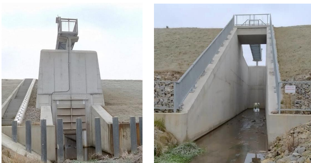
Obr. 18 – Suchá nádrž na Bílském potoce – pohled na výpust sduženého objektu a pohled skluzem (otevřeným žlabem) směrem do spadiště (autor Veronika Táboříková)
