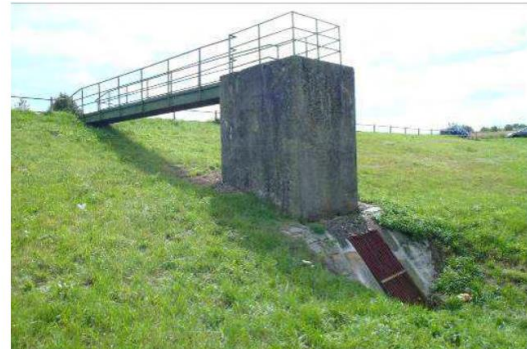
Obr. 12 – Podélný řez výpusti suché nádrže se spodní výpustí s věžovým vtokovým objektem a pohled na věžový vtokový objekt [5, p. 33]
