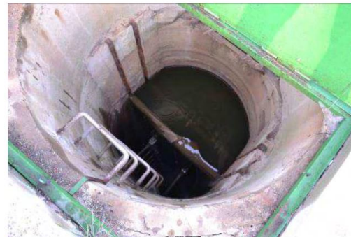
Obr. 14 – Podélný řez výpusti suché nádrže s požerákovým vtokovým objektem a pohled do šachty požeráku [5, p. 35]
