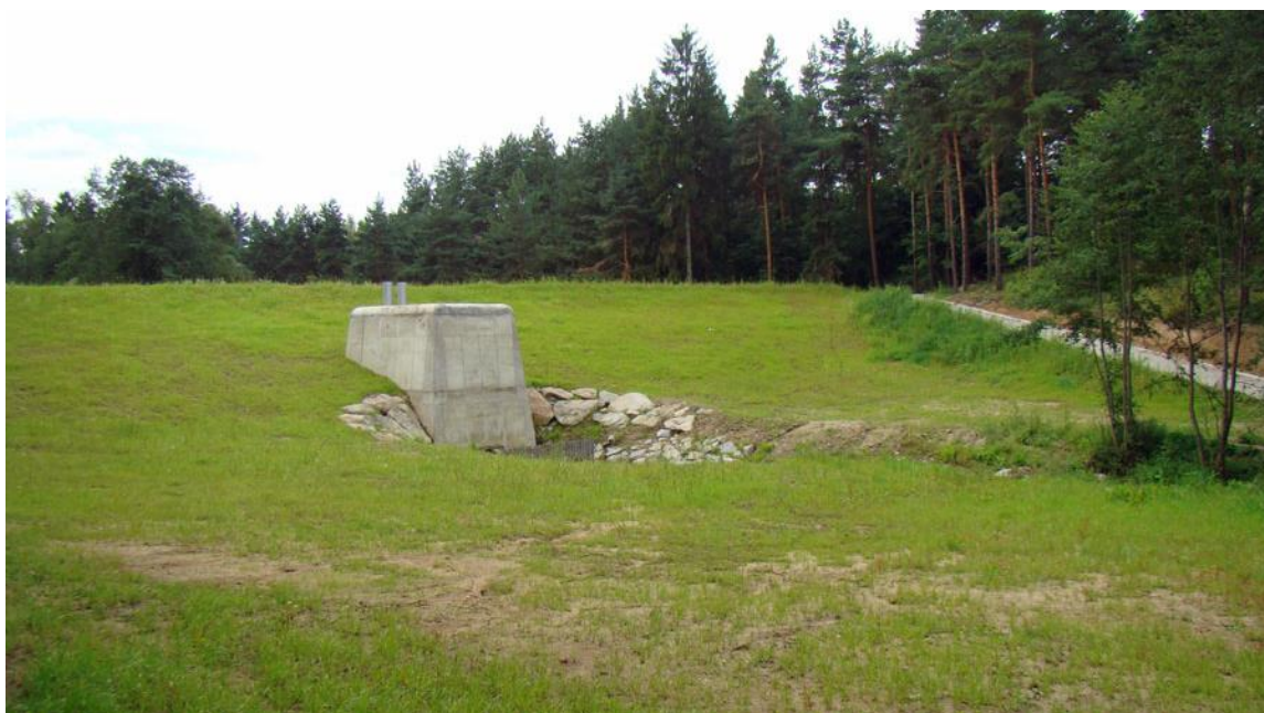
Obr. 1 – Suchá nádrž typu malé vodní nádrže – Suchá nádrž na Klapovském potoce [7] (pozn. obrázek zmenšen)
