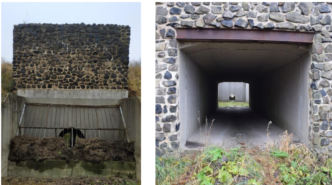
Obr. 16 – Suchá nádrž Vlastislav – pohled na výpust sduženého objektu a pohled odpadní chodbu směrem do spadiště (autor Ing. P. Balvín, Phd.)
