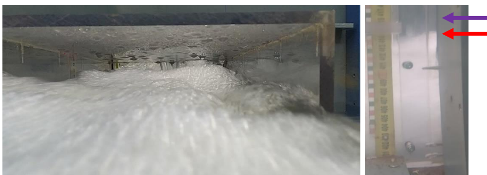
Ob. 80 – Pohled odpadním objektem směrem do spadiště (otevření výpusti 0,06 \text{ m} ) pro průtok 25,5 \text{ l/s} – výpust i přeliv v provozu
