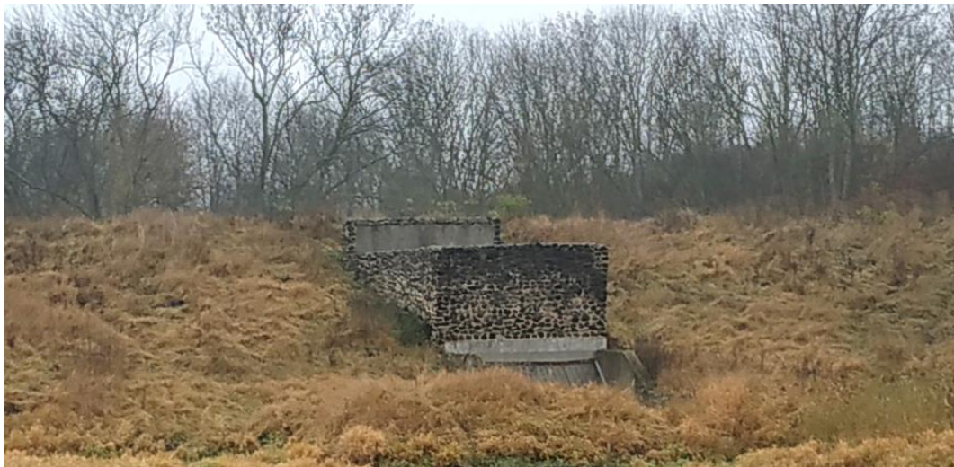
Obr. 15 – Suchá nádrž Vlastislav – jednopatrový sdužený objekt s bezpečnostním přelivem, s výpustí zaústěnou do čelní stěny a s uzavřeným odpadem od přelivu (autor Ing. P. Balvín, Phd.)
