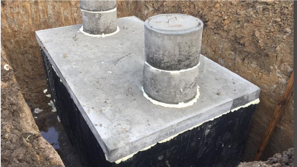
[obr. 5] – Betonová jímka uložena do výkopu
