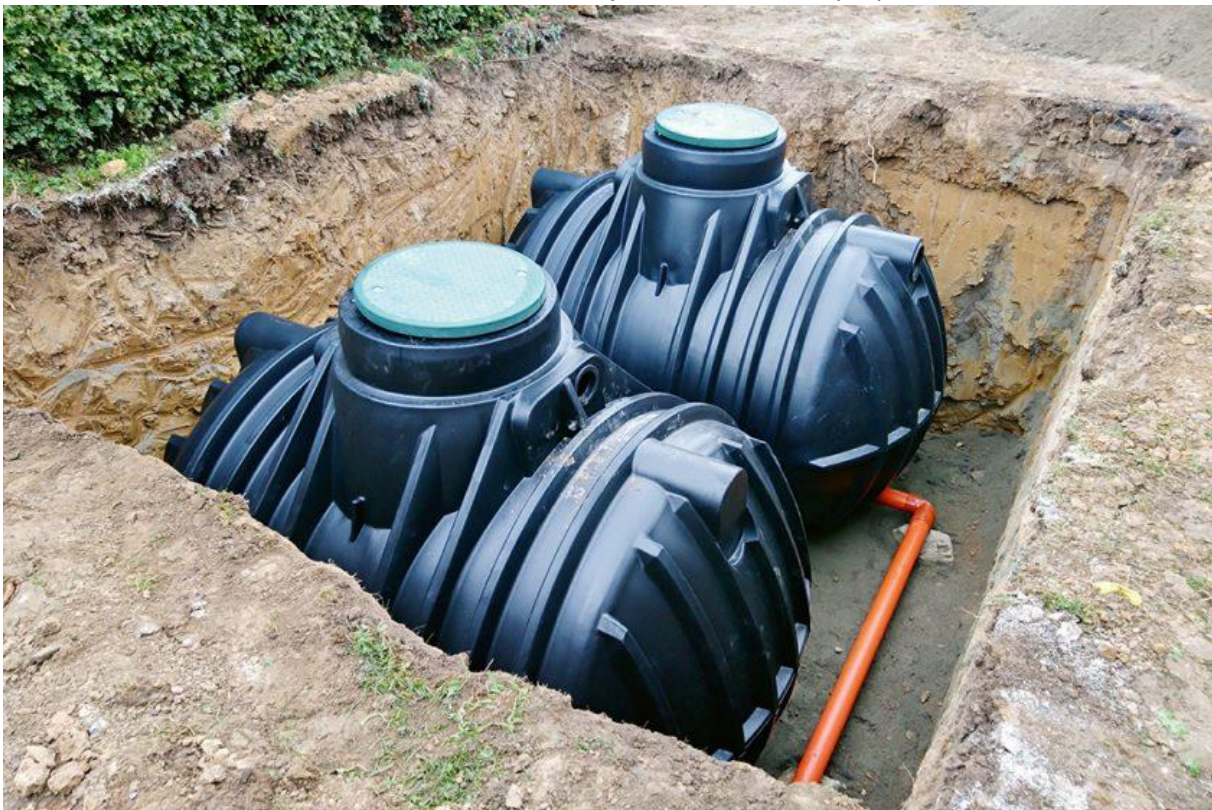
[obr. 6] – Plastová jímka uložena do výkopu
