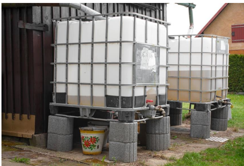
[obr. 4] – Zachytávání vody do IBC kontejneru
