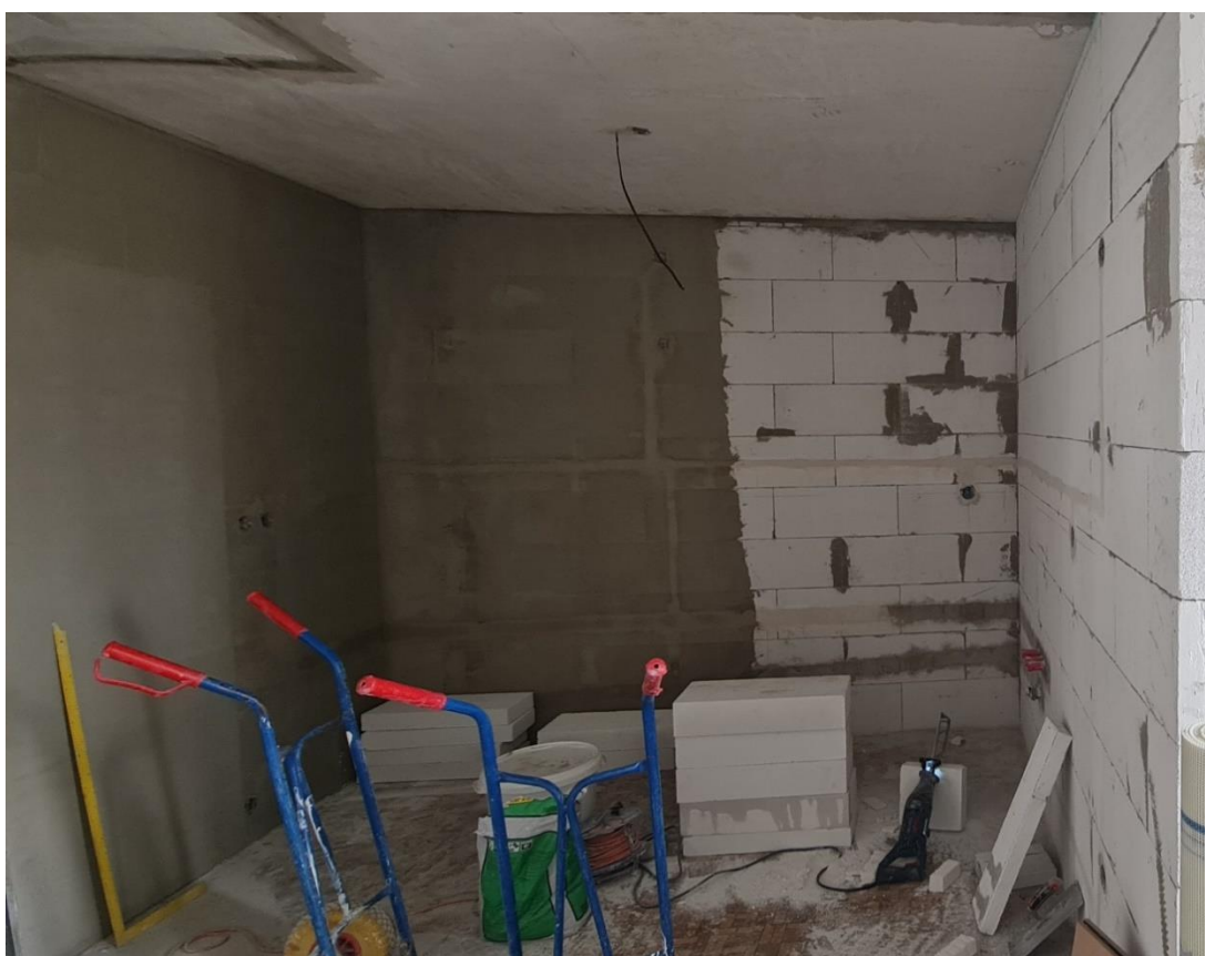
Obr. č. 22 – Částečně provedená úprava povrchu stěn Zdroj: Foto autora
