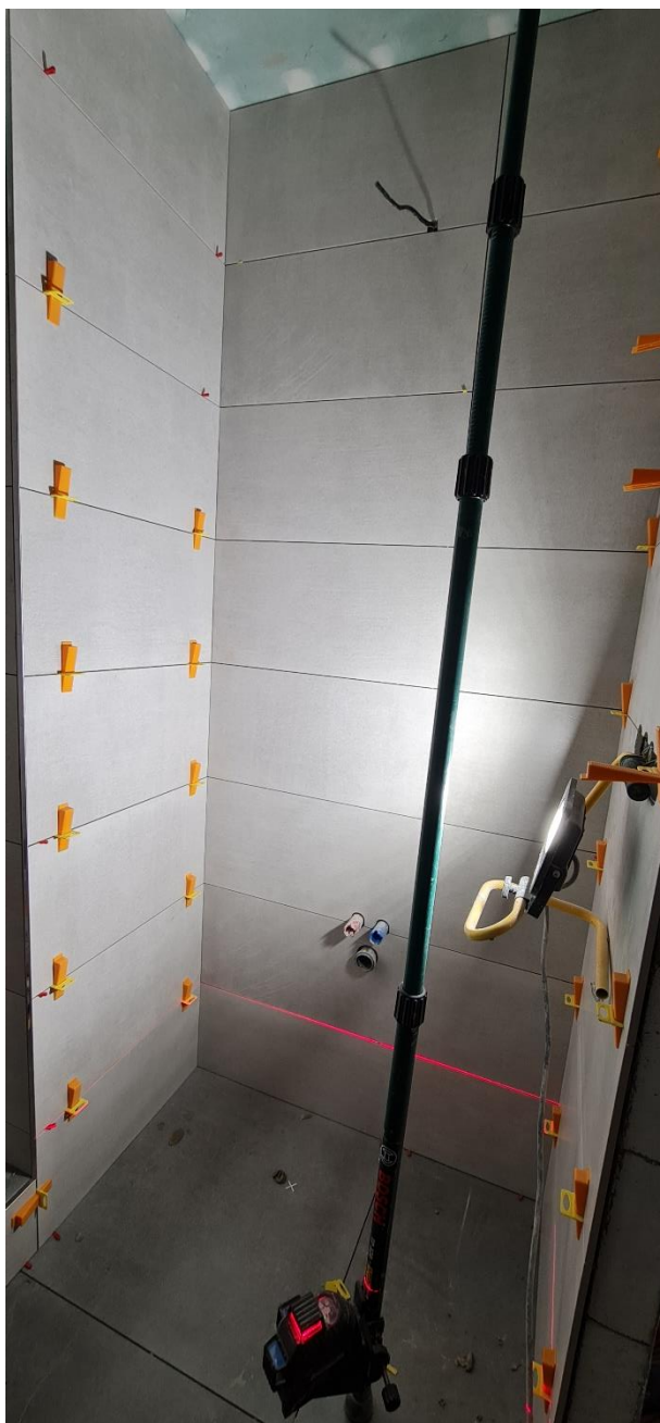
Obr. č. 25 – Provádění obkladu z velkoformátových dlaždic Zdroj: Foto autora
