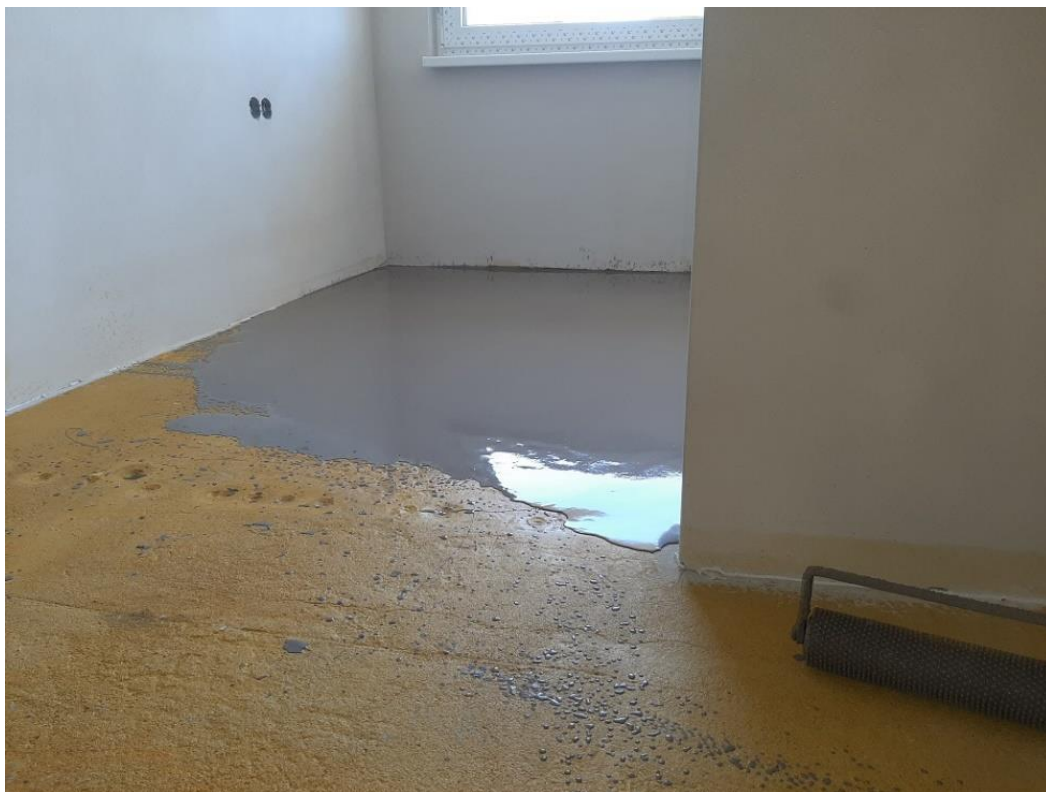
Obr. č. 26 – Aplikace samonivelační hmoty na penetrovaný podklad
