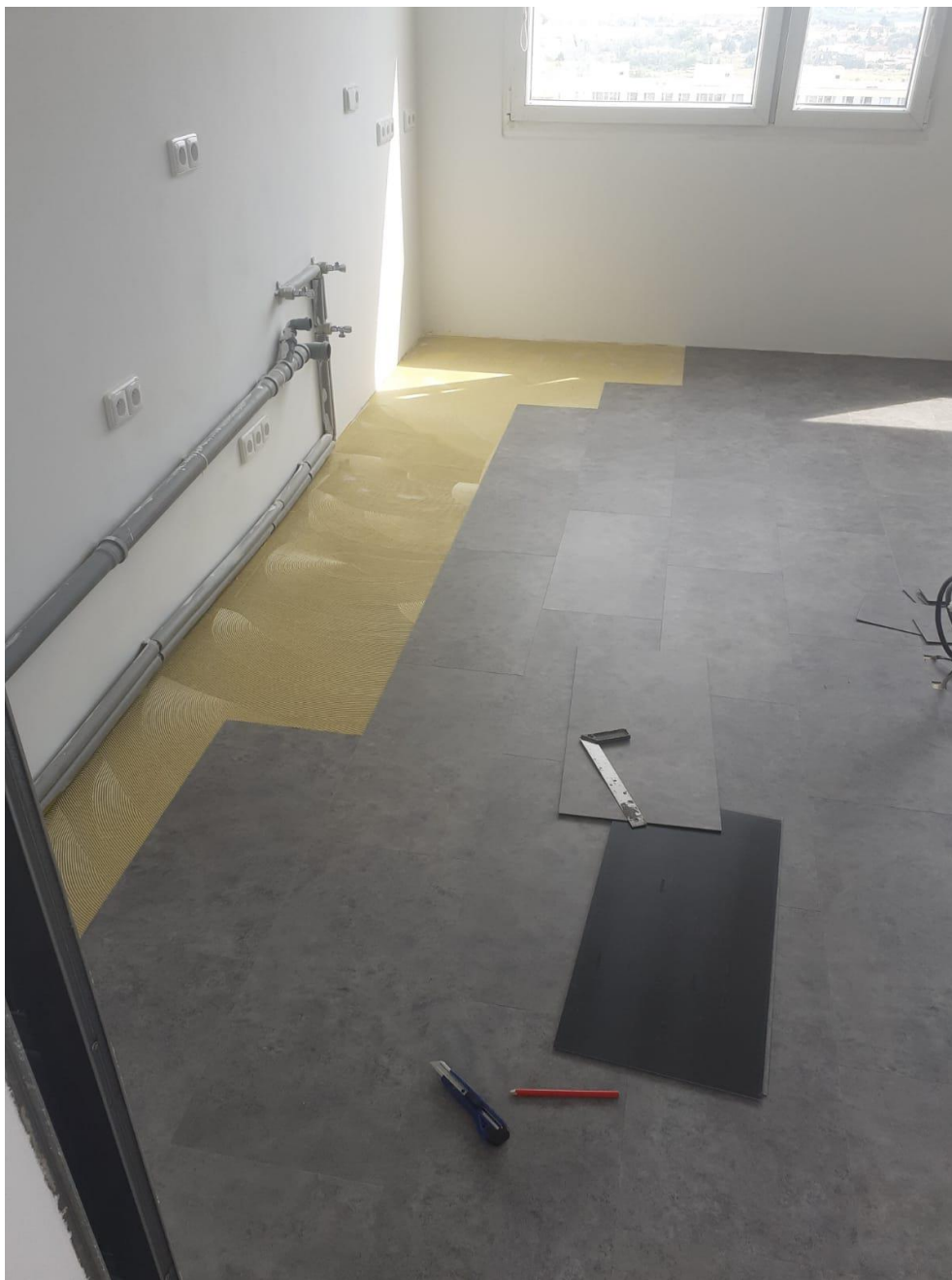
Obr. č. 27 – Pokládka podlahy z lepených vinylových dílců
