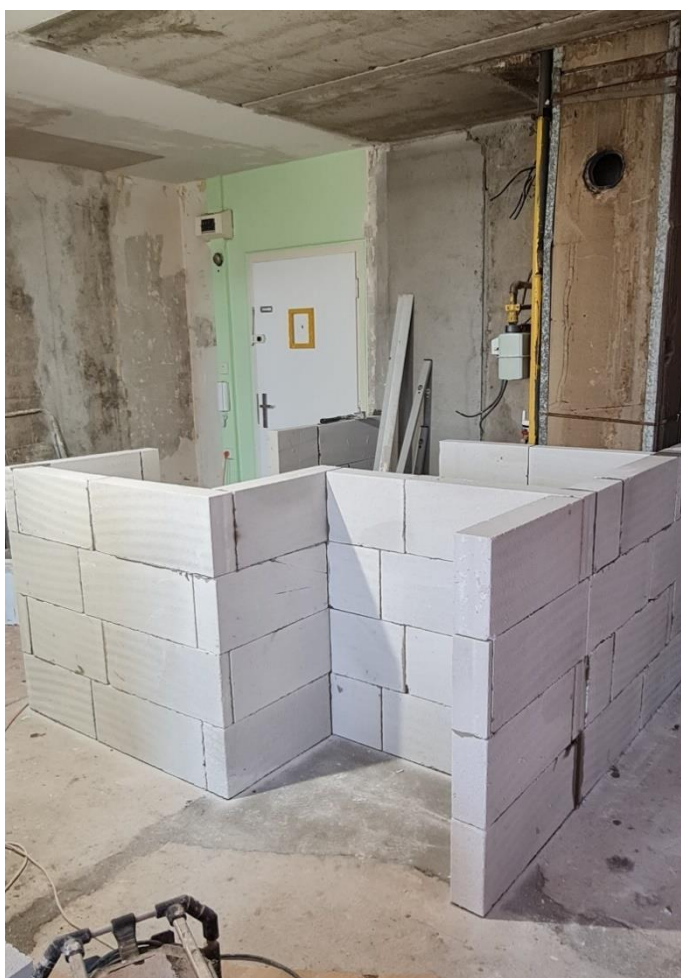
Obr. č. 19 – Ukázka výstavby z pórobetonových tvárnic
