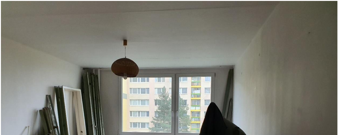
Obr. č. 9 – Viditelné styky stropních dílců
