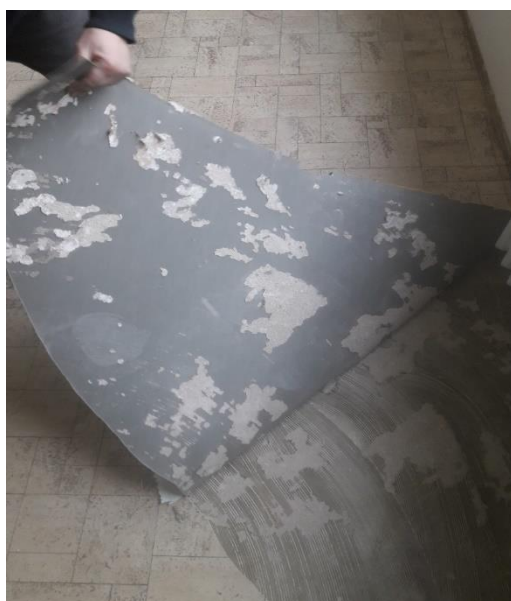
Obr. č. 15 – Strhávání původního lepeného PVC
