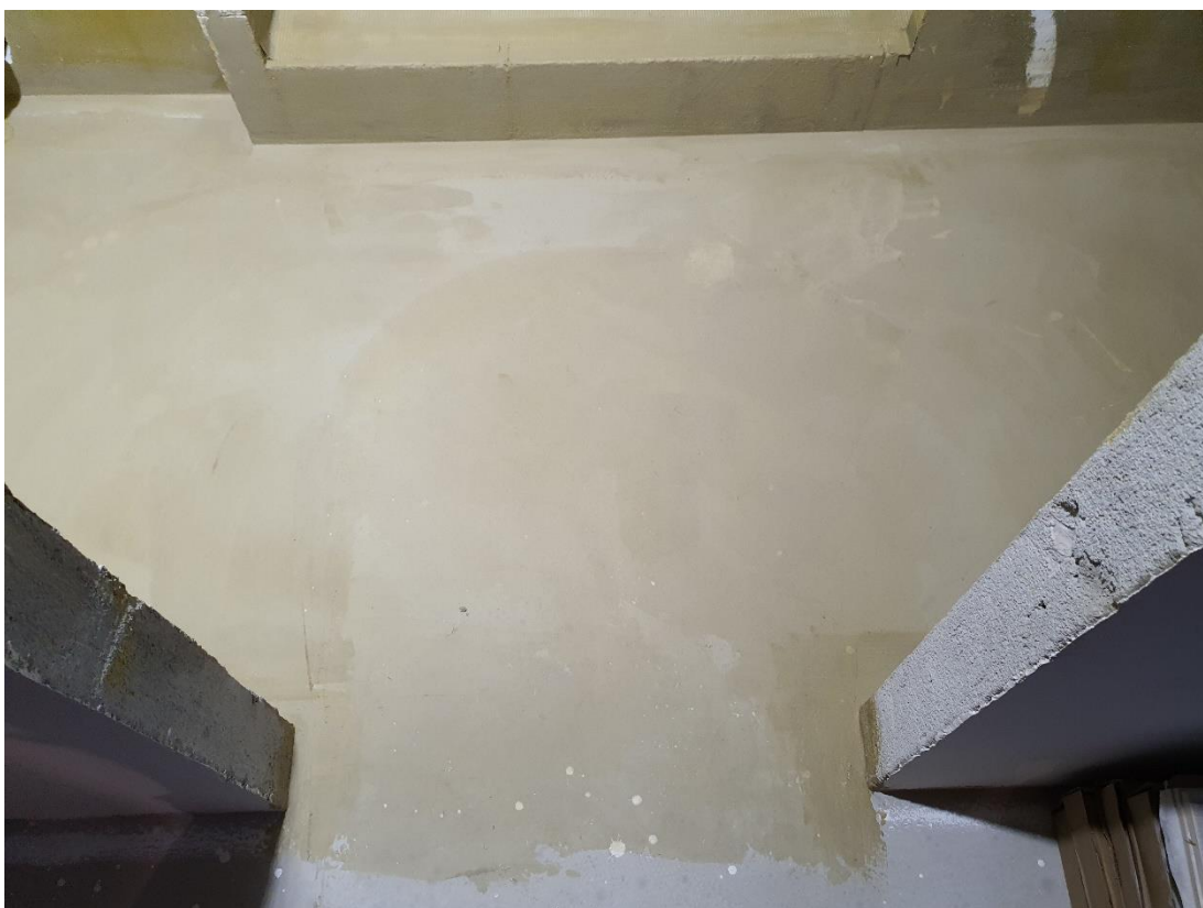
Obr. č. 24 – Hydroizolační nátěr na površích v koupelně Zdroj: Foto autora
