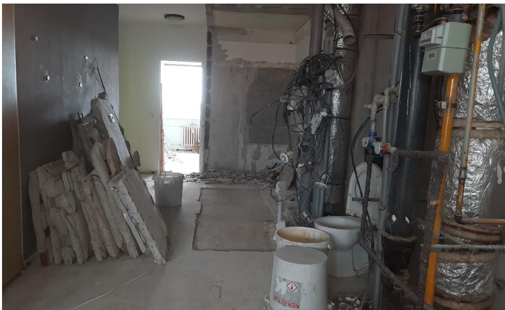
Obr. č. 17 – Demontované jádro a části odstraněné nenosné panelové příčky
