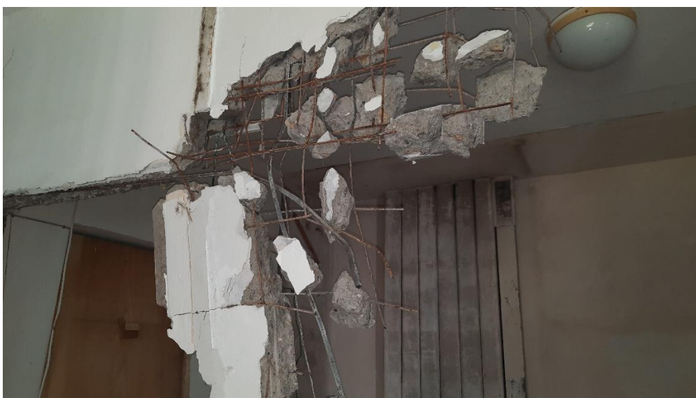
Obr. č. 18 – Ukázka obnažené výztuže při demolici nenosné příčky
