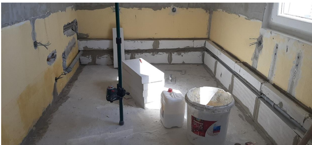
Obr. č. 21 – Příprava pro kuchyňskou linku pomocí laserového nivelačního přístroje Zdroj: Foto autora
