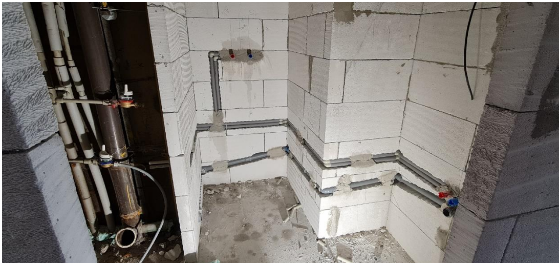
Obr. č. 20 – Provedení rozvodů ZTI v drážkách a napojení na stoupací potrubí Zdroj: Foto autora
