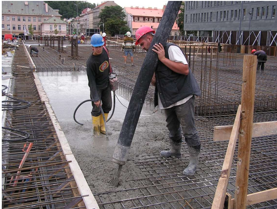
Obrázek 38 Realizace stropní desky se smršťovací pásem [22]
