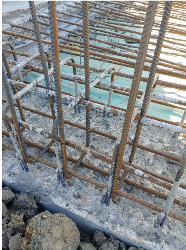
Obrázek 7: Zdrsňený základový pás pneumatickým kladivem, vlastní zpracování
