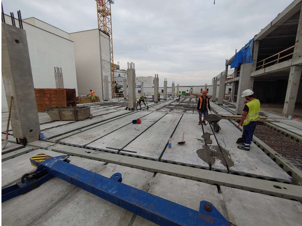
Obrázek 31 Betonování spár mezi prefabrikovanými prvky, vlastní zpracování
