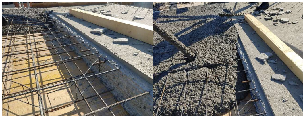
Obrázek 16: Betonovaná pracovní spára stropní desky, vlastní zpracování
