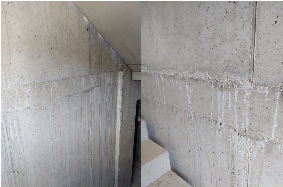
Obrázek 20: Pracovní spáry mezi stropní deskou a stěnami, vlastní zpracování
