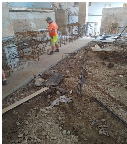
Obrázek 26: Realizace zesilujícího základového pasu již stávajících prefabrikovaných sloupů, vlastní zpracování
