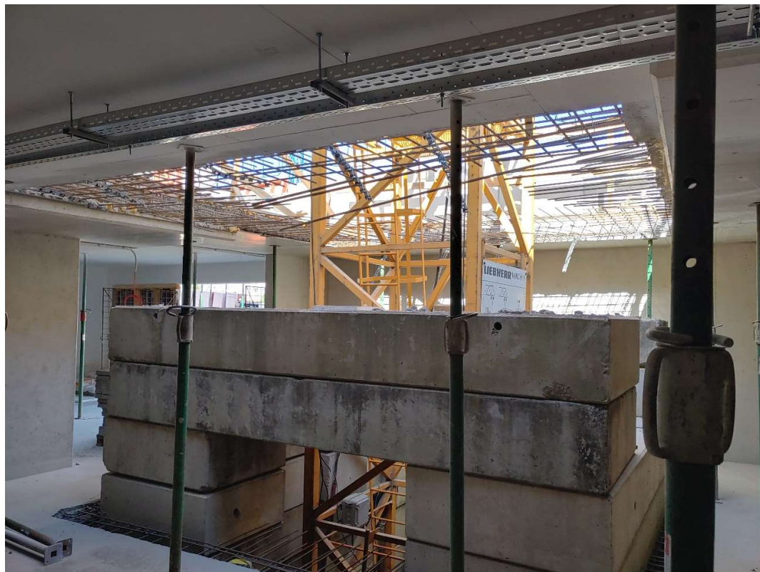
Obrázek 11: Věžový jeřáb prostupující stropními konstrukcemi, vlastní zpracování
