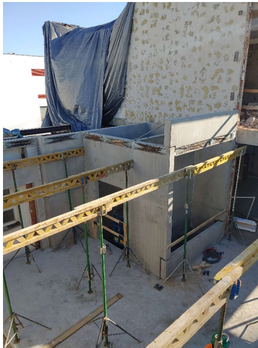
Obrázek 24: Prefabrikované stěny s instalovanou vylamovací výztuží, vlastní zpracování
