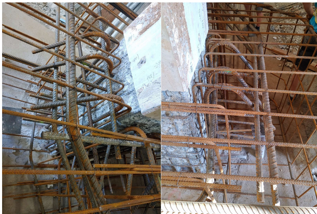
Obrázek 27: Připravená pracovní spára s vlepovanou výztuží, vlastní zpracování
