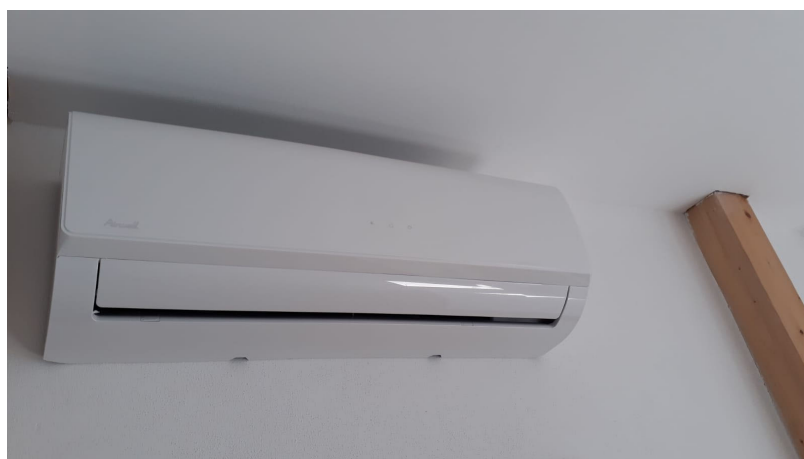
Obr. 1.6: Splitová jednotka pro apartmány [Foto: Jiří Frantik]
