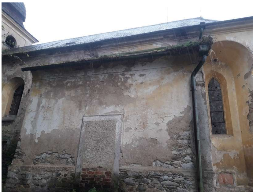
obrázek 18 – podokapní žlab ucpaný náletovou zelení
