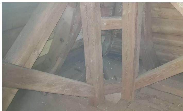
obrázek 16 – pohled na sloupky, ztužení, ramenáty a část spodního roštu krovu věže
