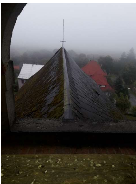
obrázek 47 – pohled na střechu
