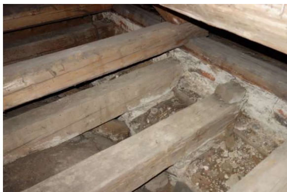
obrázek 7 – uložení trámů stropu lodi
