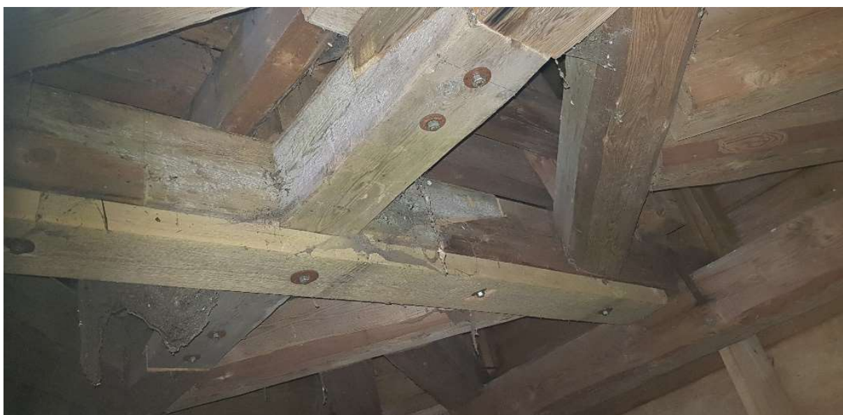
obrázek 42 – dřívější sanace horního věnce krovu věže
