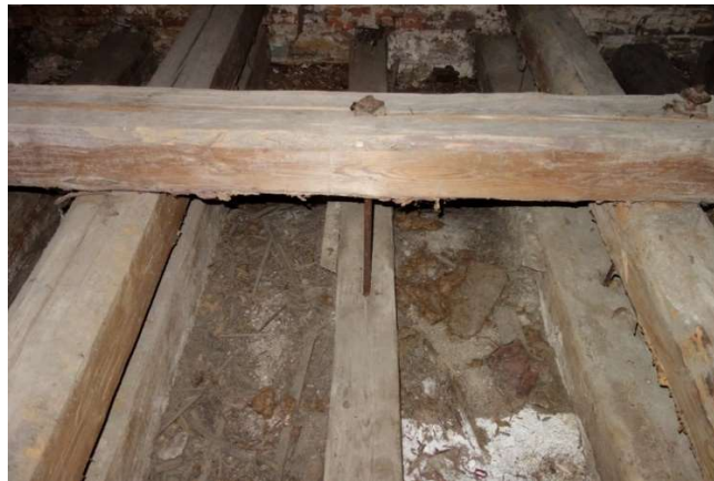
obrázek 12 – kotvení stropního trámu do vynášecího trámu
