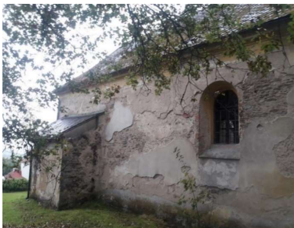
obrázek 5 – severní fasáda kostela s odhaleným zdivem
