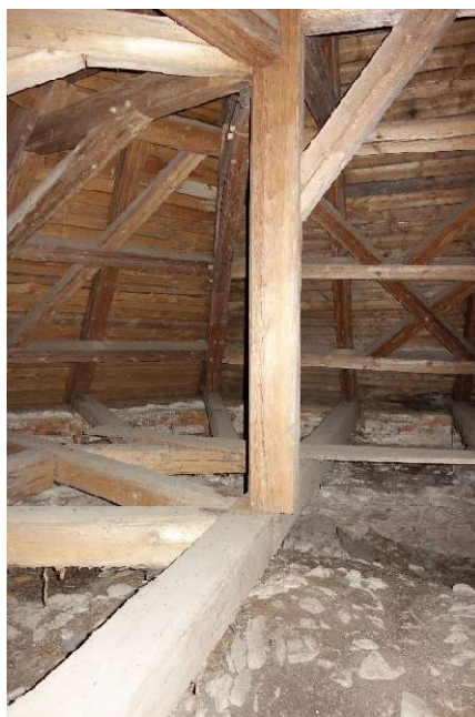
obrázek 39 – vyosený středový sloupek nad presbyteriem
