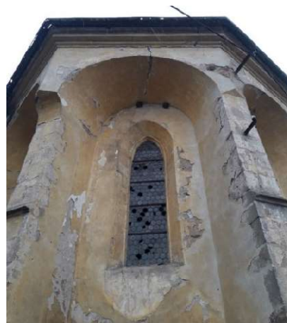
obrázek 6 – východní fasáda presbytáře – opracované kamenné bloky pilířů
