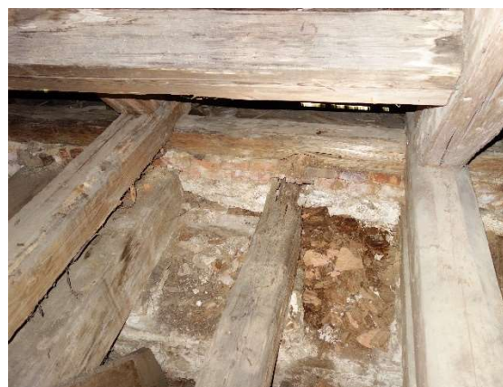
obrázek 31 – ztrouchnivělé zhlaví trámu
