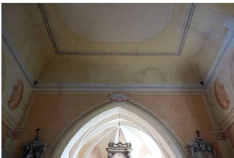
obrázek 46 – vlhkostní mapy a hnízda ptáků v hlavní lodi
