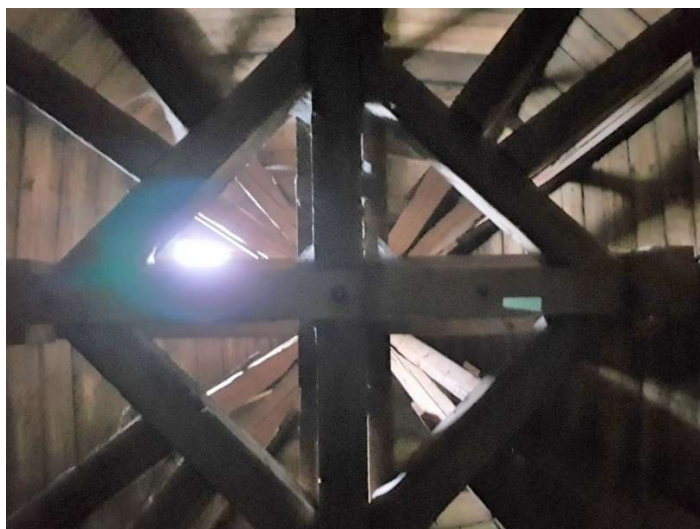
obrázek 15 – pohled na horní věnec krovu věže zespodu
