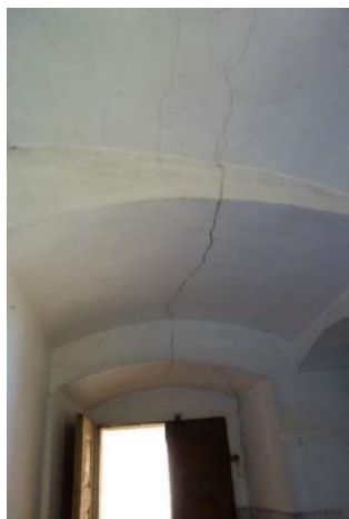
obrázek 34 – trhлина v klenbě předsíňe
