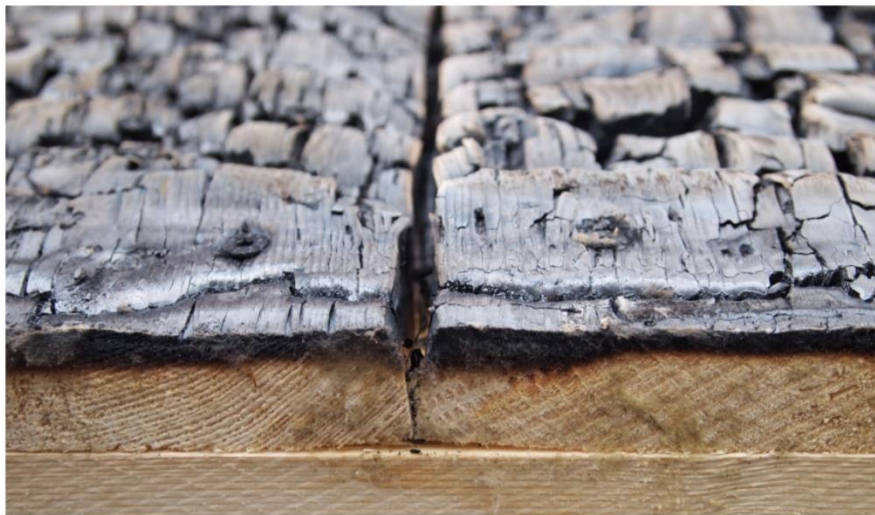
Obrázek 13. – Panel po požární zkoušce [7]
