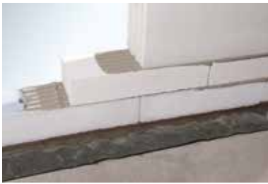
Založení první řady pomocnou tvárnici Ytong Start
