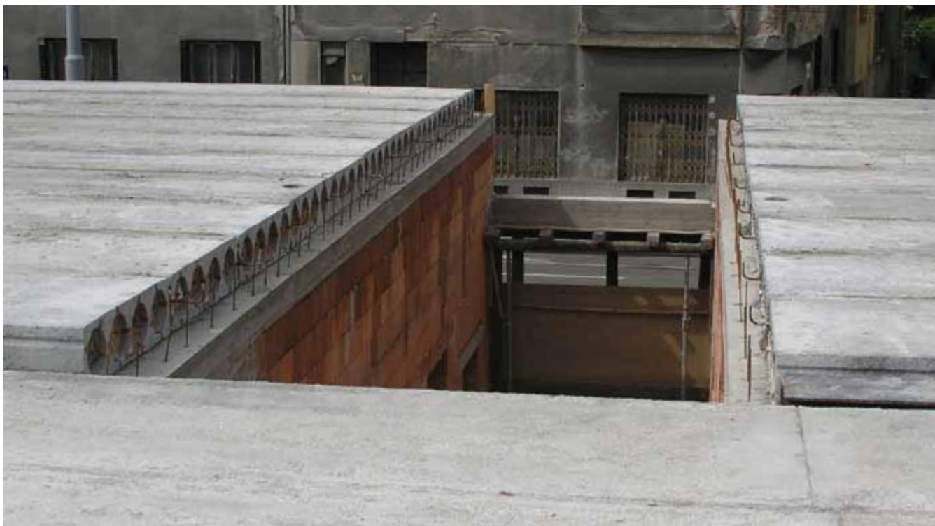
Obr. 3: Stropní konstrukce se zalitými spárami
