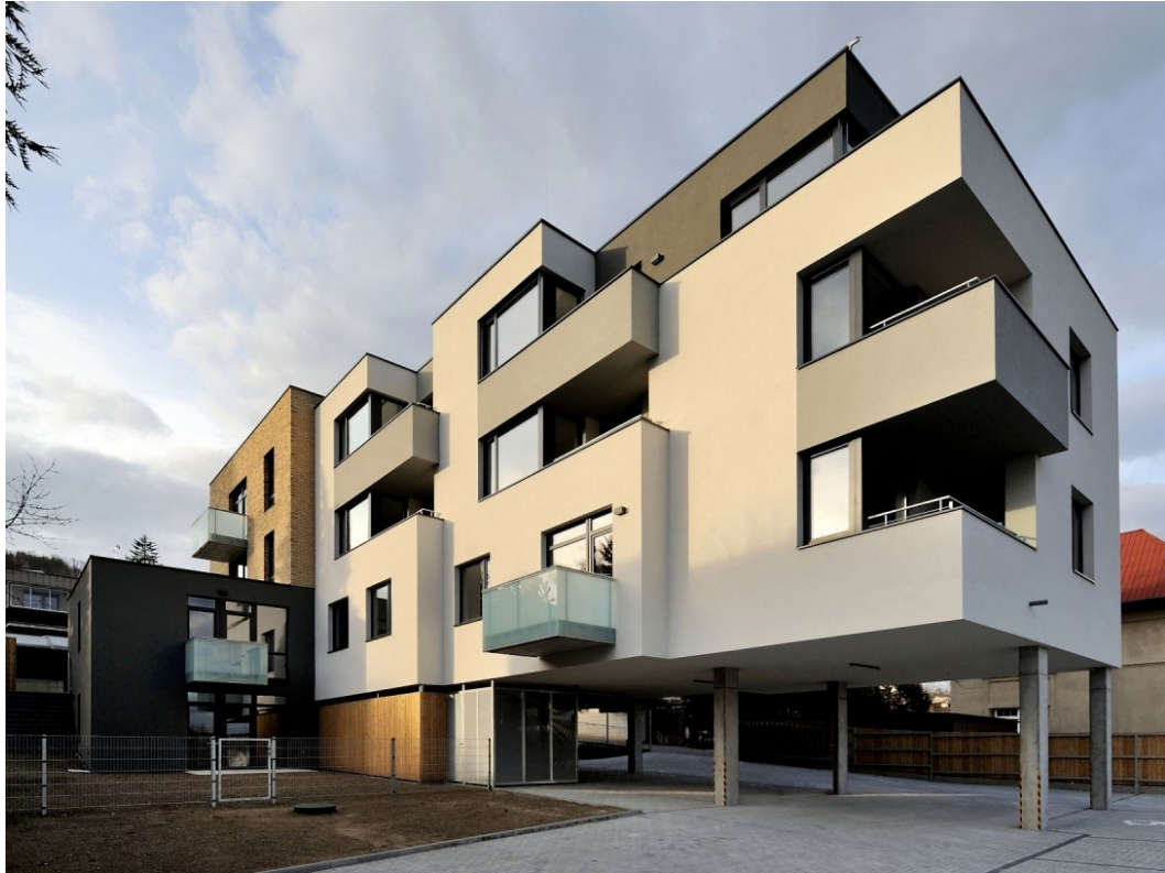
Obrázek 4.2: Fotografie bytového domu z přilehlého pozemku [5]
