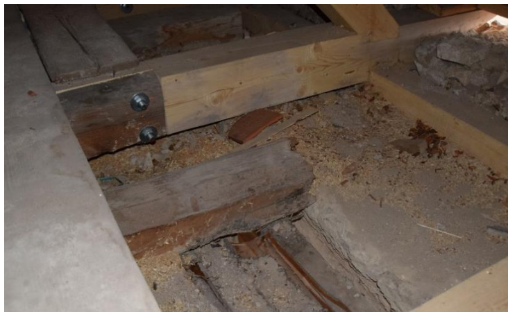
Obr. 50 Shnilé zhlaví rákosníku
