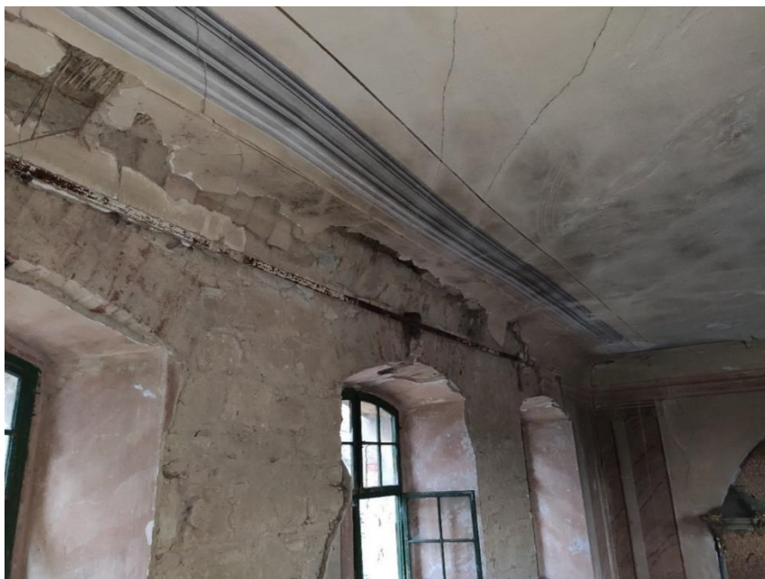
Obr. 70 Tmavá místa od vlhkosti a s tím související opadaná omítka
