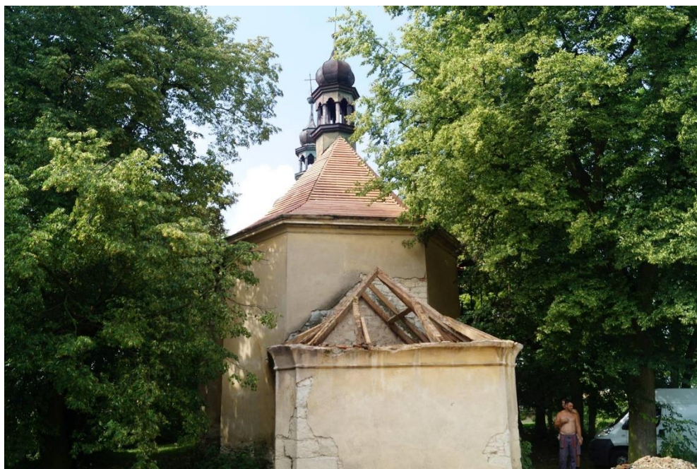
Obr. 10 Oprava krovu v roce 2016 (11)
