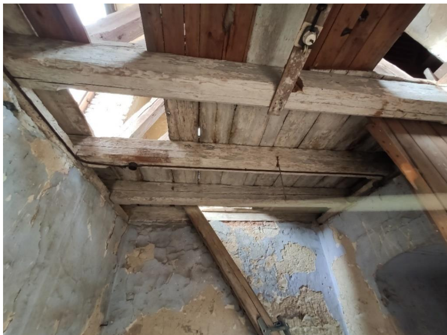
Obr. 17 Stropní konstrukce věže
