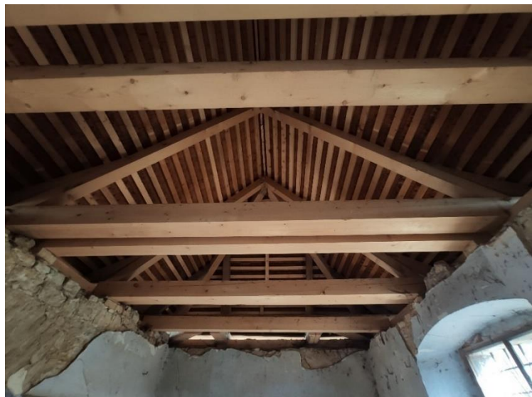
Obr. 23 Nový krov sakristie
