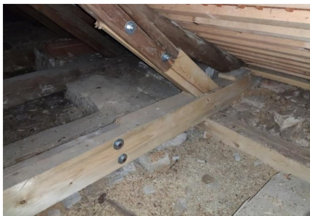
Obr. 58 Protézování – krokev, vazný trám
