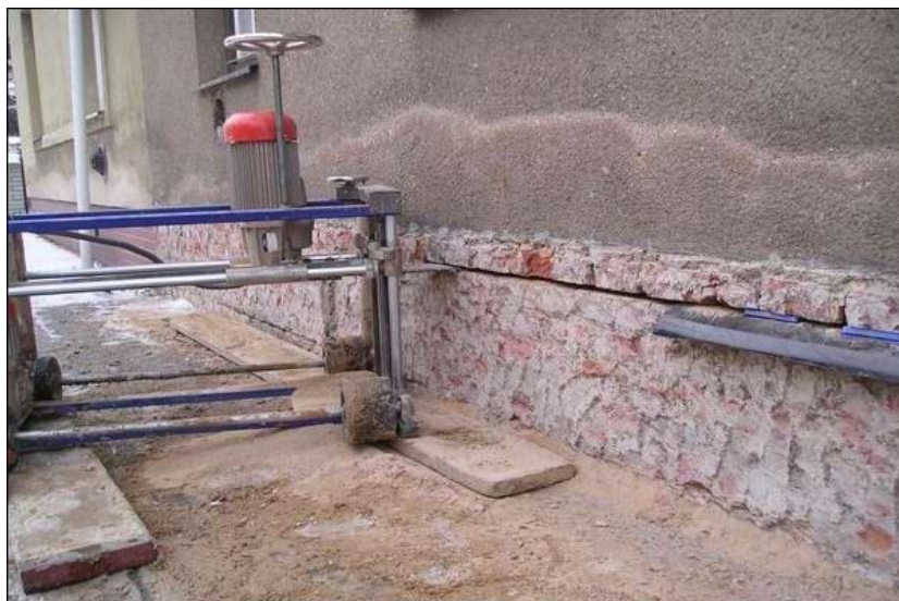
Obr. 106 Podřezání zdiva řetězovou pilou (17)
