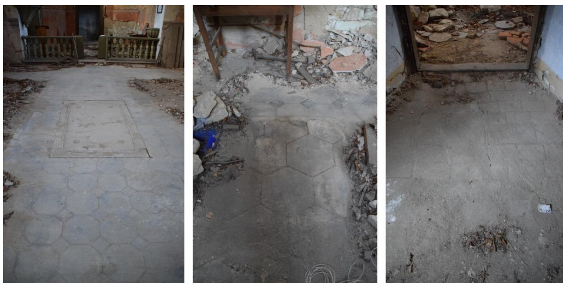
Obr. 29, 30, 31 Podlahy, zleva: loď, presbytář, sakristie
