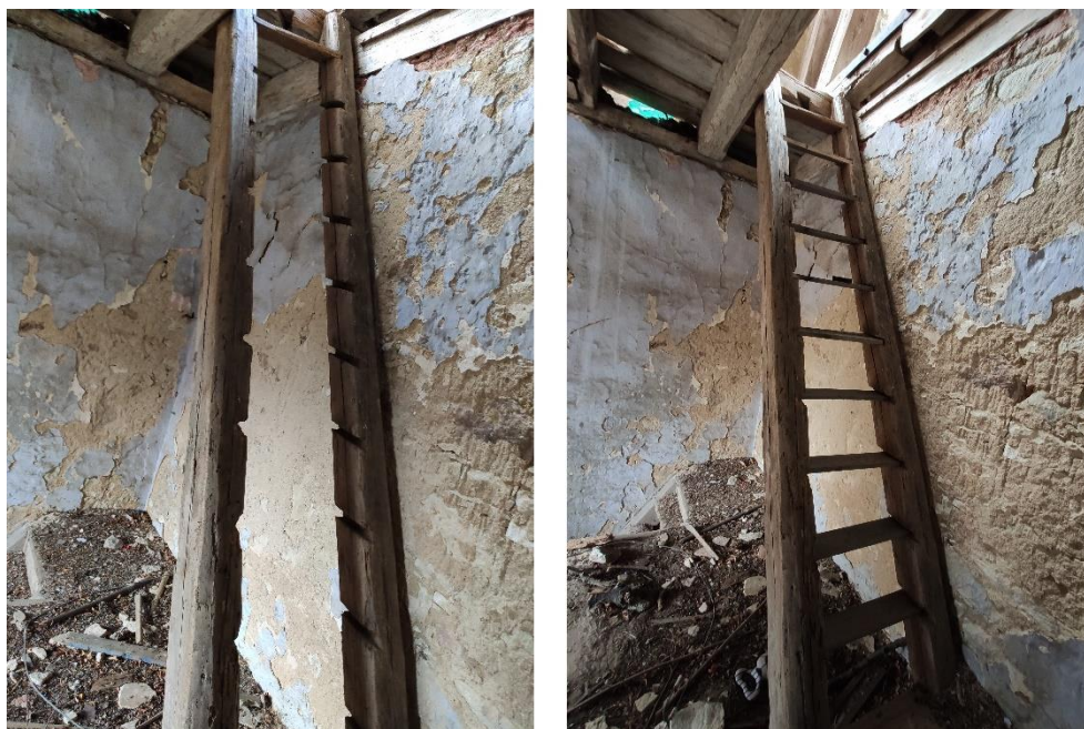
Obr. 65, 66 Schody před a po provizorní opravě
