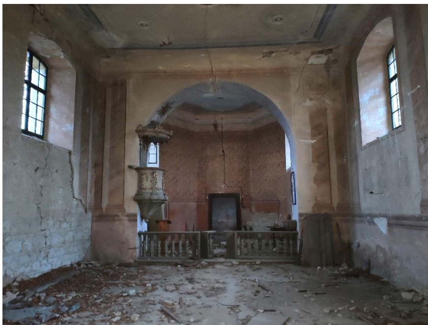
Obr. 69 Podlaha lodi před začátkem STP
