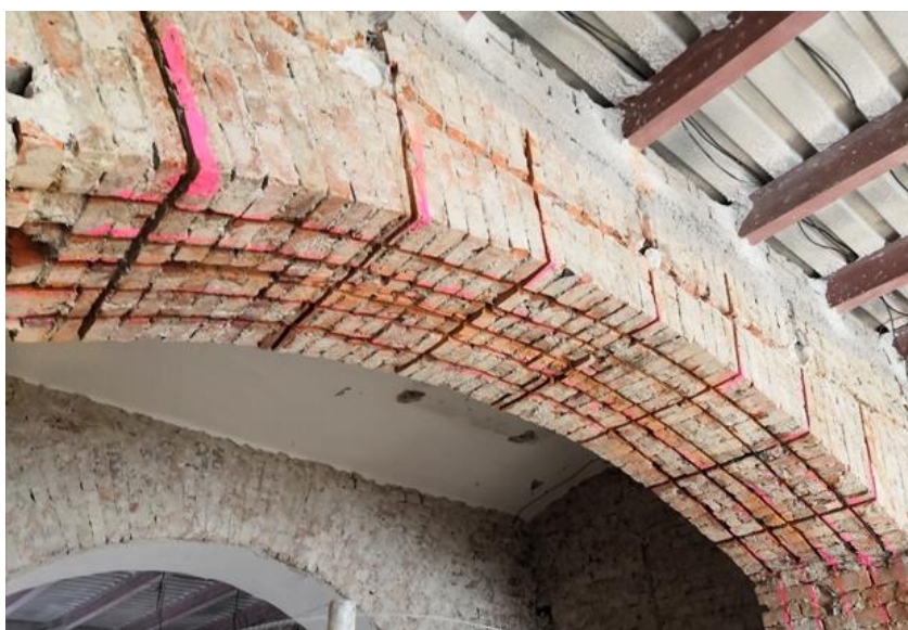
Obr. 119 Sanace klenebného pasu helikální výztuží (33)
