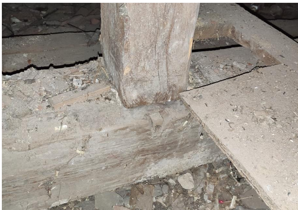
Obr. 20 Spoj sloupku a vazného trámu
