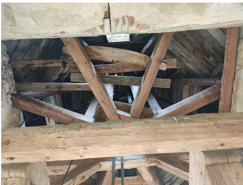
Obr. 24 Konstrukce střechy věže
