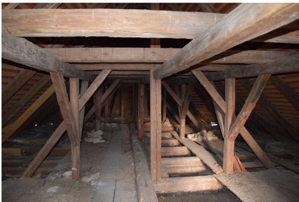
Obr. 18 Krov nad lodí
