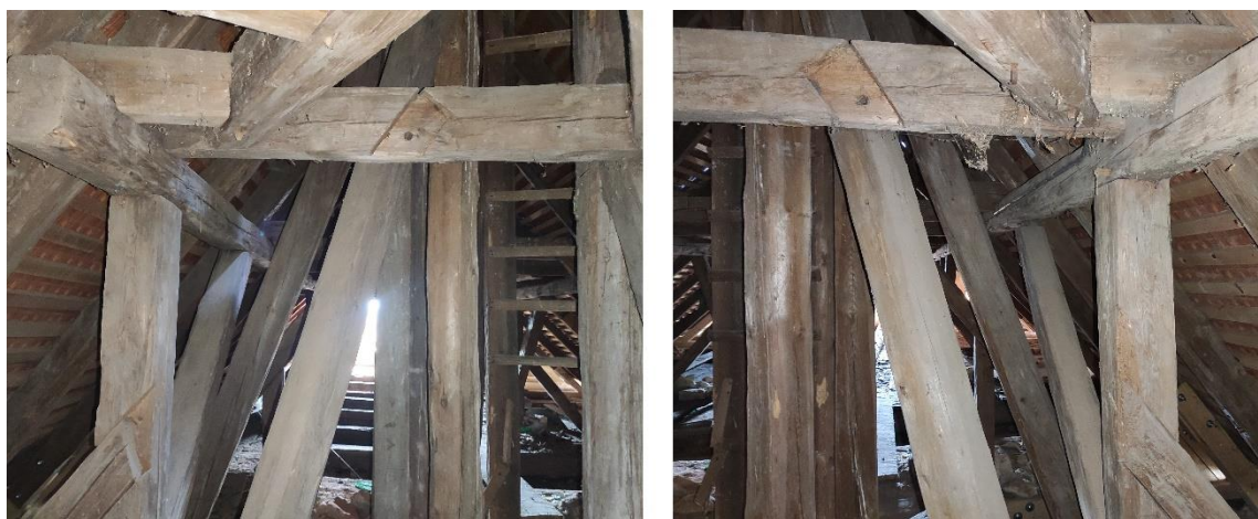
Obr. 60, 61 Chybějící vzpěry
