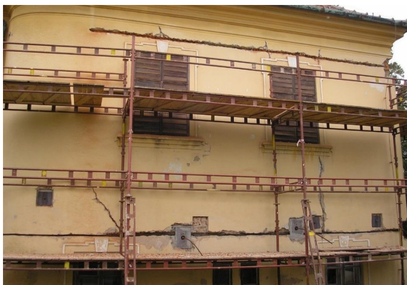
Obr. 117 Sepnutí objektu (30)
