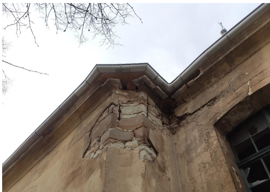
Obr. 13 Odhalené závlače táhel
