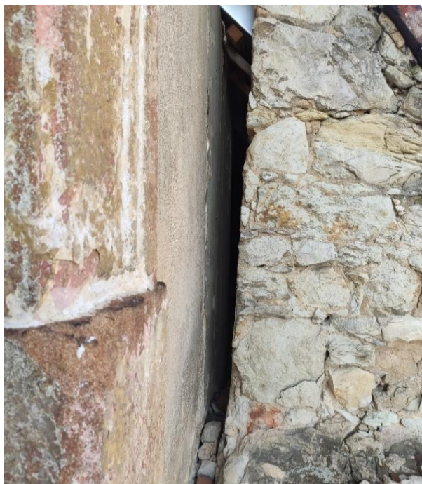
Obr. 42 Separace atiky od věže
