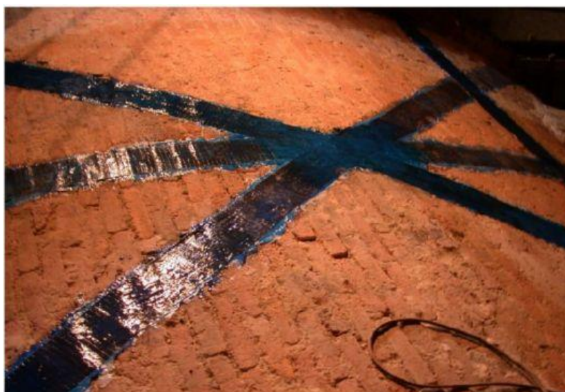
Obr. 118 Sanace klenby lamely z uhlíkových vláken (32)
