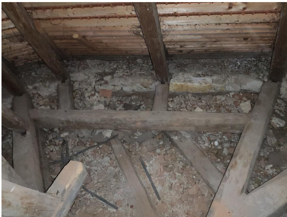
Obr. 19 Výměna a krátčata nad presbytářem
