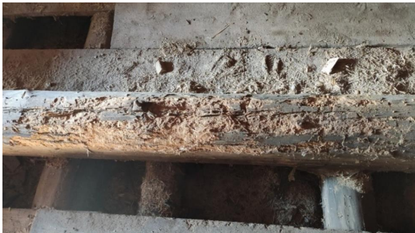
Obr. 51 Napadení vynášejiho trámu
