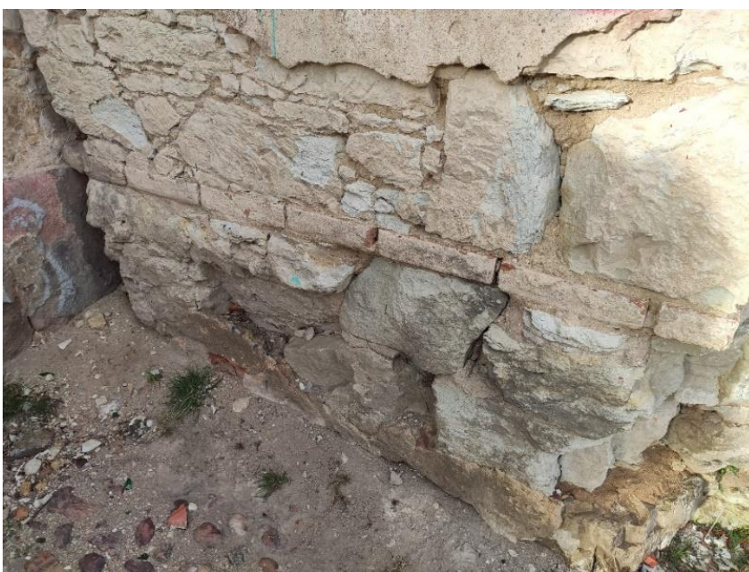
Obr. 11 Odhalené opukové zdivo u soklu
