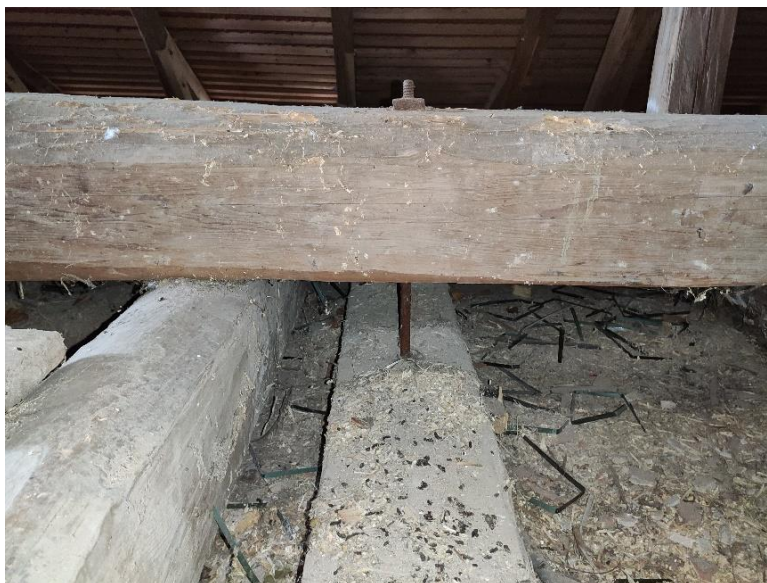
Obr. 15 Vynesení rákosníku pomocí trnu do pomocného trámu
