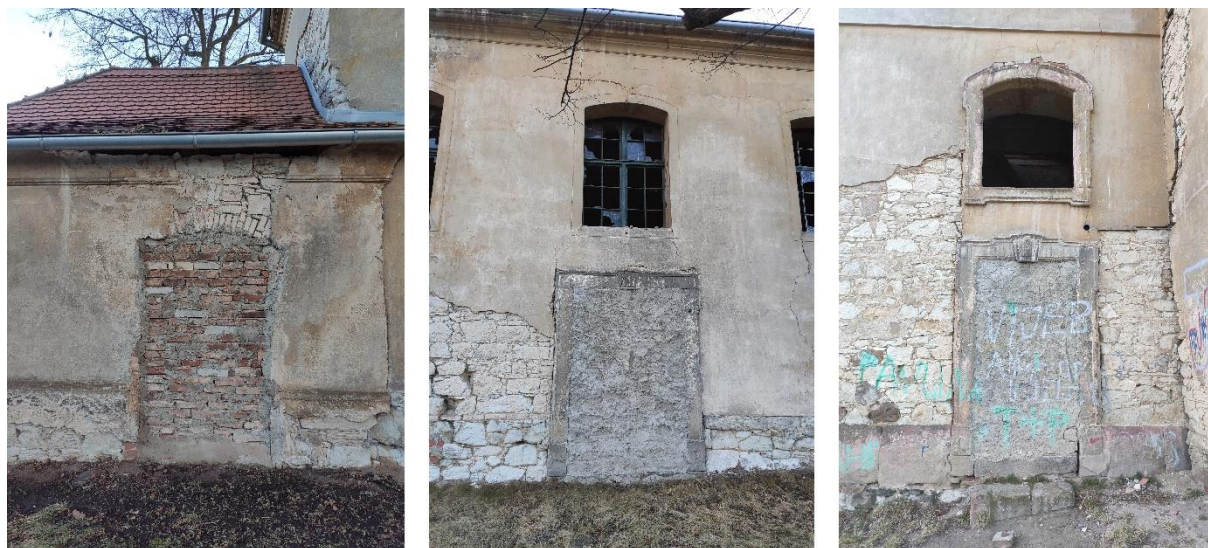
Obr. 6, 7, 8 Zazdžené vstupy, zleva: sakristie, loď, věž
