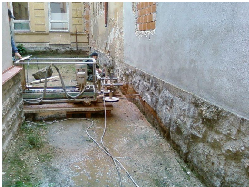
Obr. 107 Podřezání pilou s diamantovým lanem (18)
