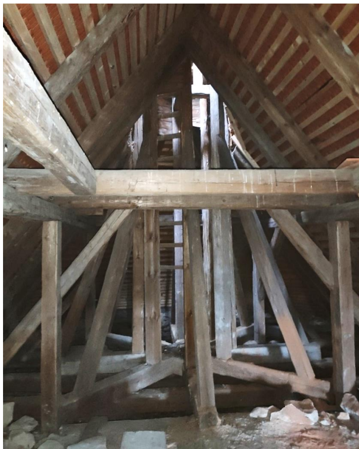
Obr. 21 Konstrukce sanktusníku nad presbytářem
