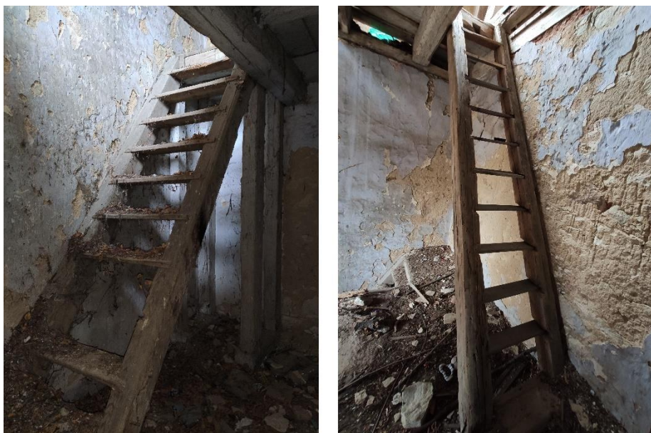
Obr. 25, 26 Schodiště ve věži
