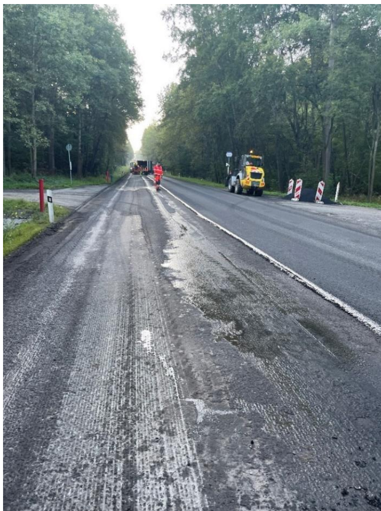
Obrázek 26 - Pokládka na studenou spáru [zdroj vlastní]
