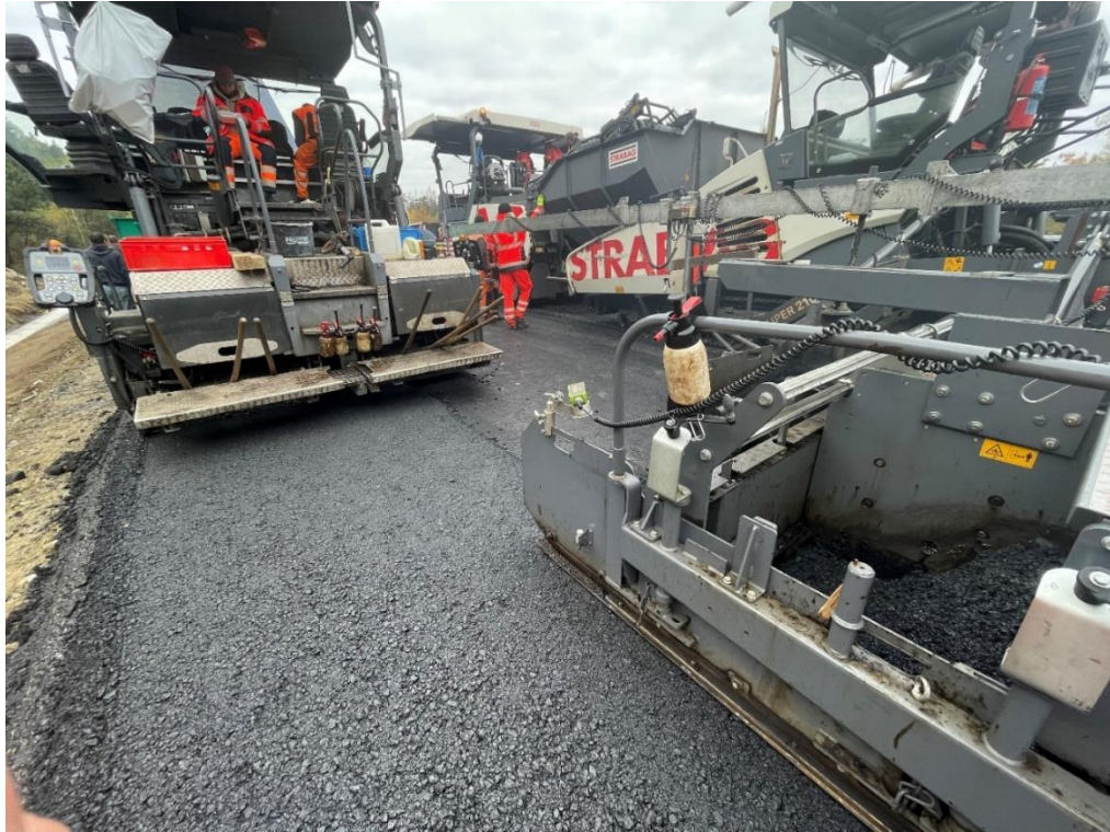
Obrázek 25 - Pokládka na teplou spáru [zdroj vlastní]
