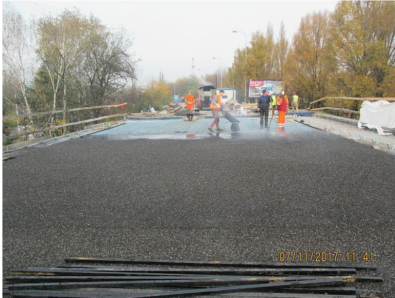
Obrázek 1 - Realizace litého asfaltu na mostní konstrukci [6]
