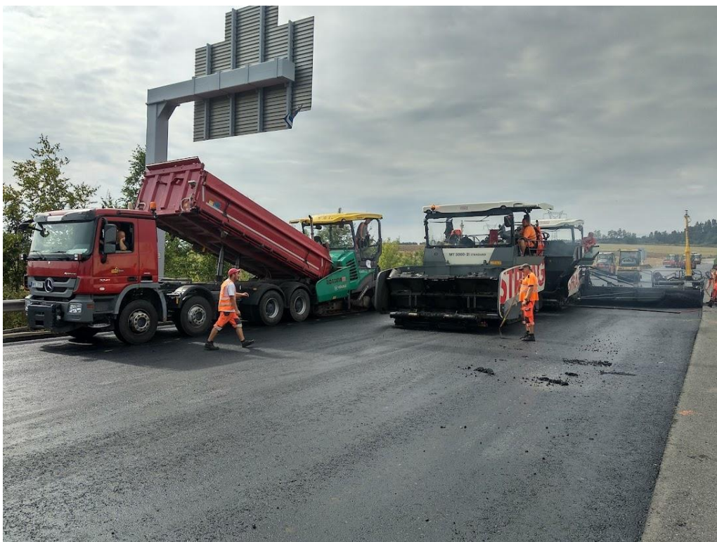
Obrázek 28- Průběh stavby 1 [zdroj vlastní]
