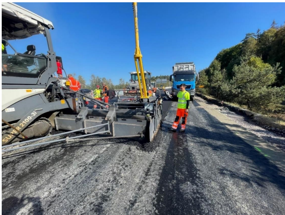
Obrázek 29 - Průběh stavby 2 [zdroj vlastní]
