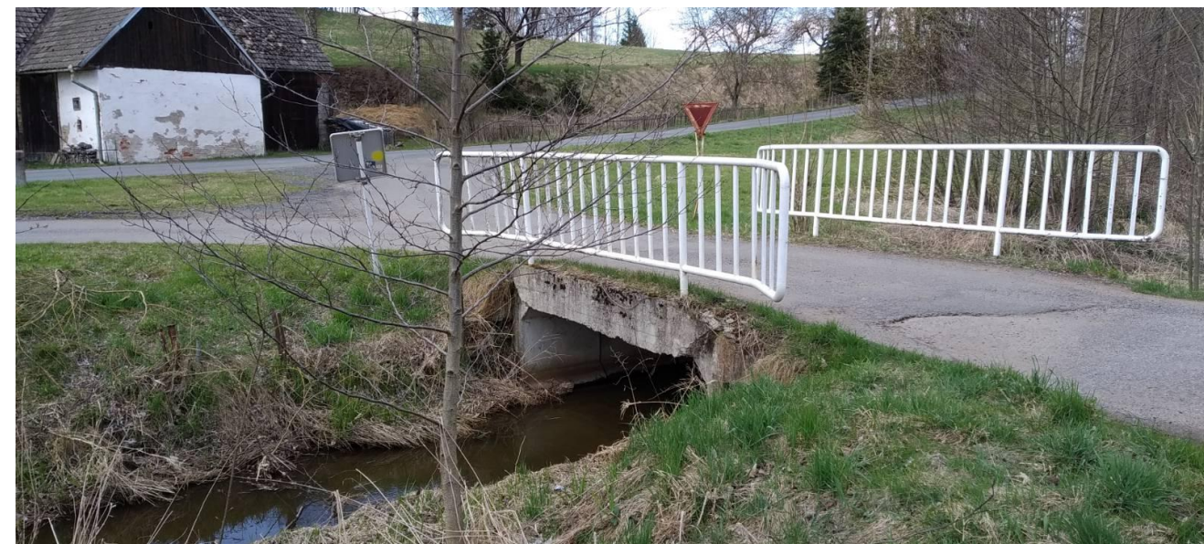
Obrázek číslo 35: Pohled na železobetonovou konstrukci mostu
