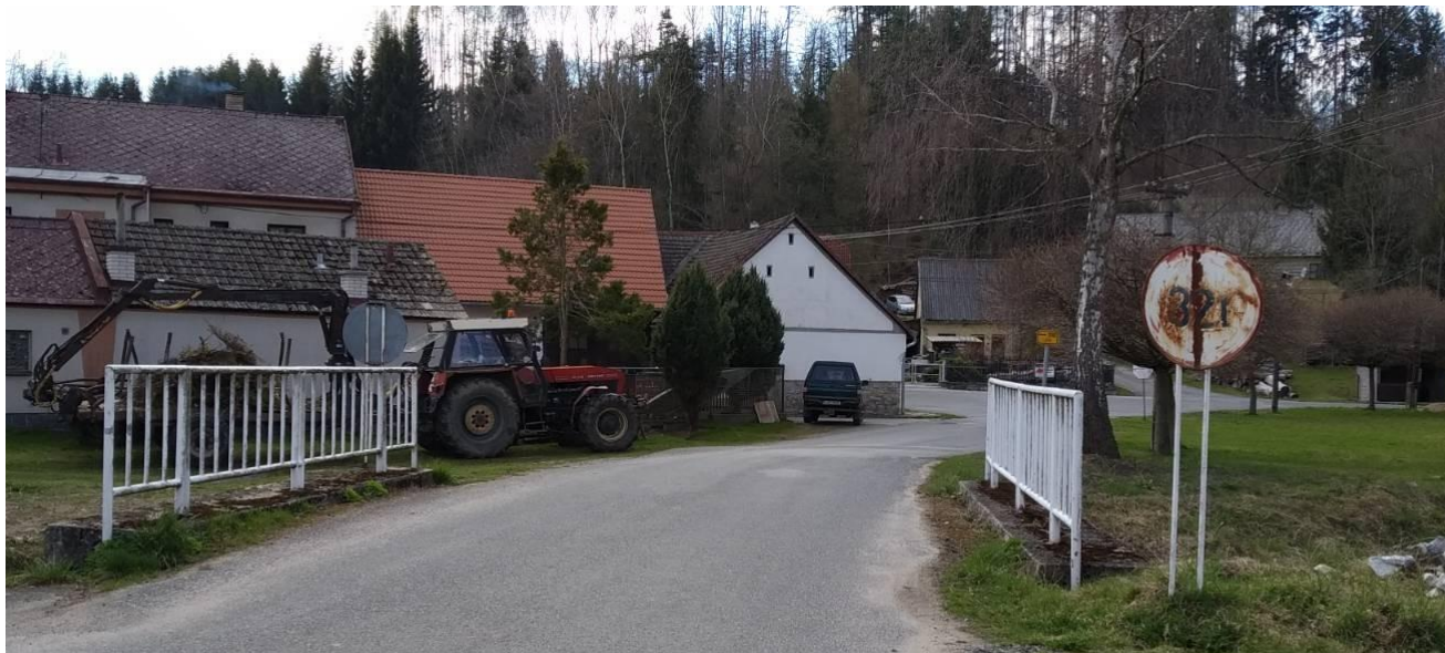
Obrázek číslo 41: Stav svislého dopravního značení na jednom z mostů
