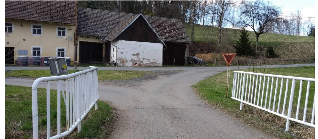
Obrázek číslo 39: Nevyhovující značka vedlejší silnice
