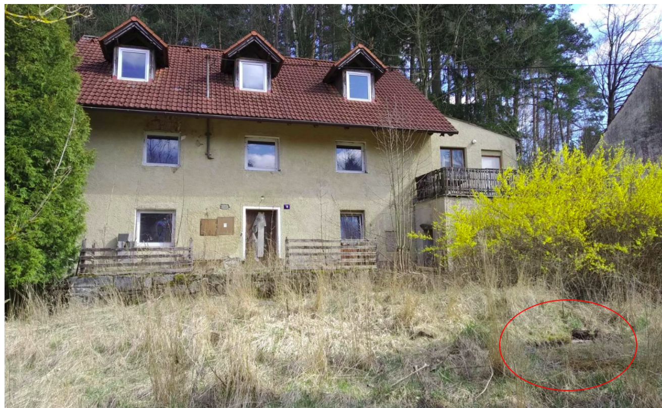
Obrázek číslo 47: Neudržovaný dům s nezajištěnou studnou a septikem (vyznačen červeně)
