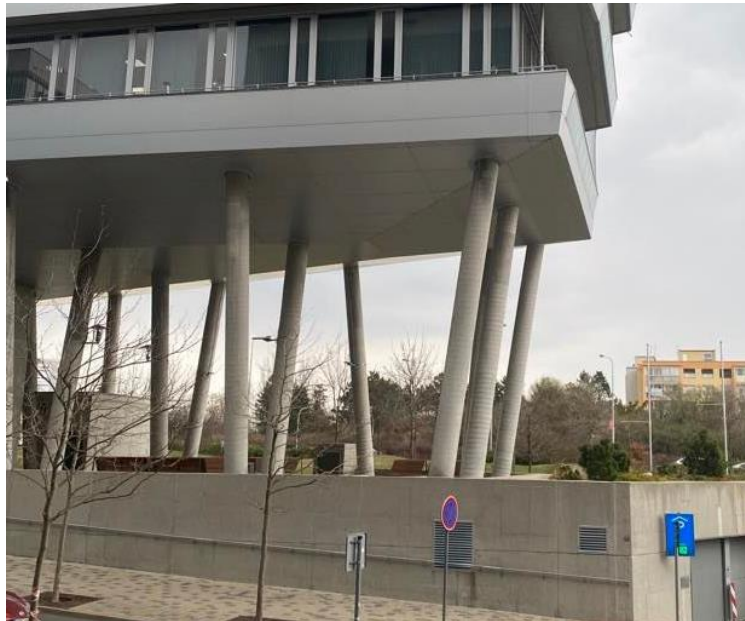
Obr. 17 Příklad štíhlého sloupu – Sídlo Siemens, Praha 13 - Stodůlky
