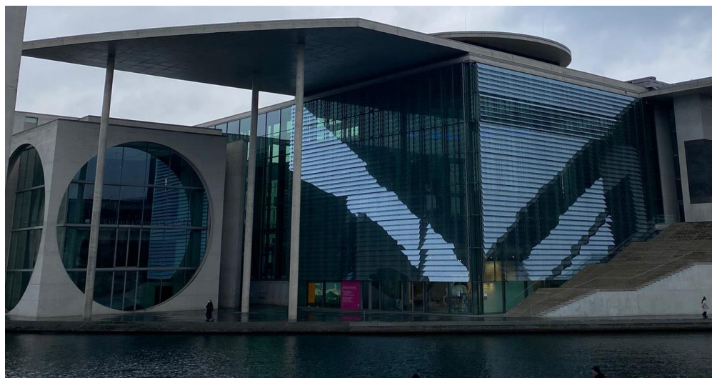
Obr. 18 Příklad velmi štíhlého železobetonového sloupu – Paul-Löbe-Haus Berlin
