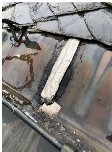
Obrázek 23 - Degradace úžlabí
