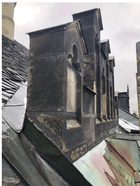
Obrázek 25 - Tmavé zbarvení kamene
