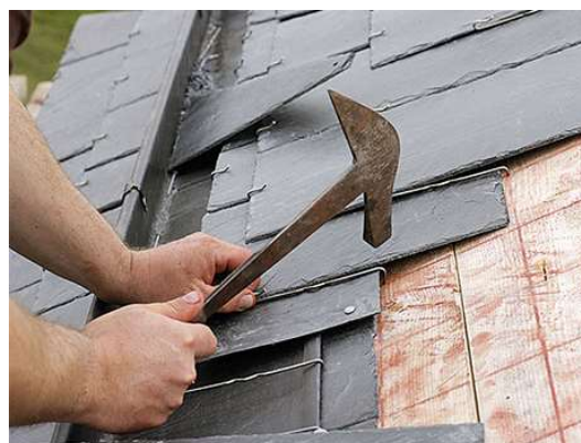
Obrázek 33 - Pokládka břidličné krytiny [33]
