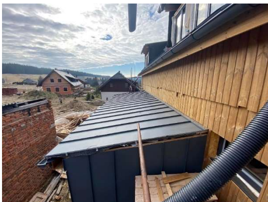
Obrázek 34 - Pokládka falcované krytiny
