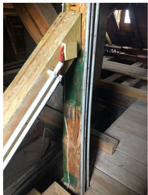
Obrázek 26 - Označené napadené prvky
