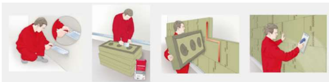
Obrázek 95, nanášení lepidla na desky z kamenné vlny (14)
