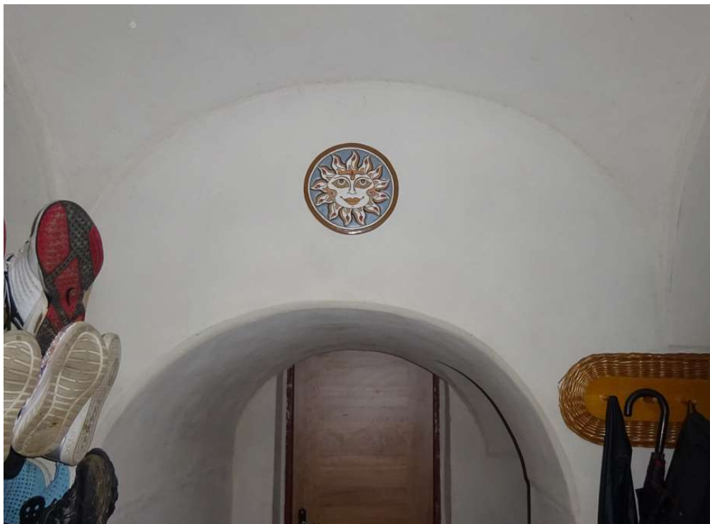
Obrázek 10, valená klenba u schodiště
