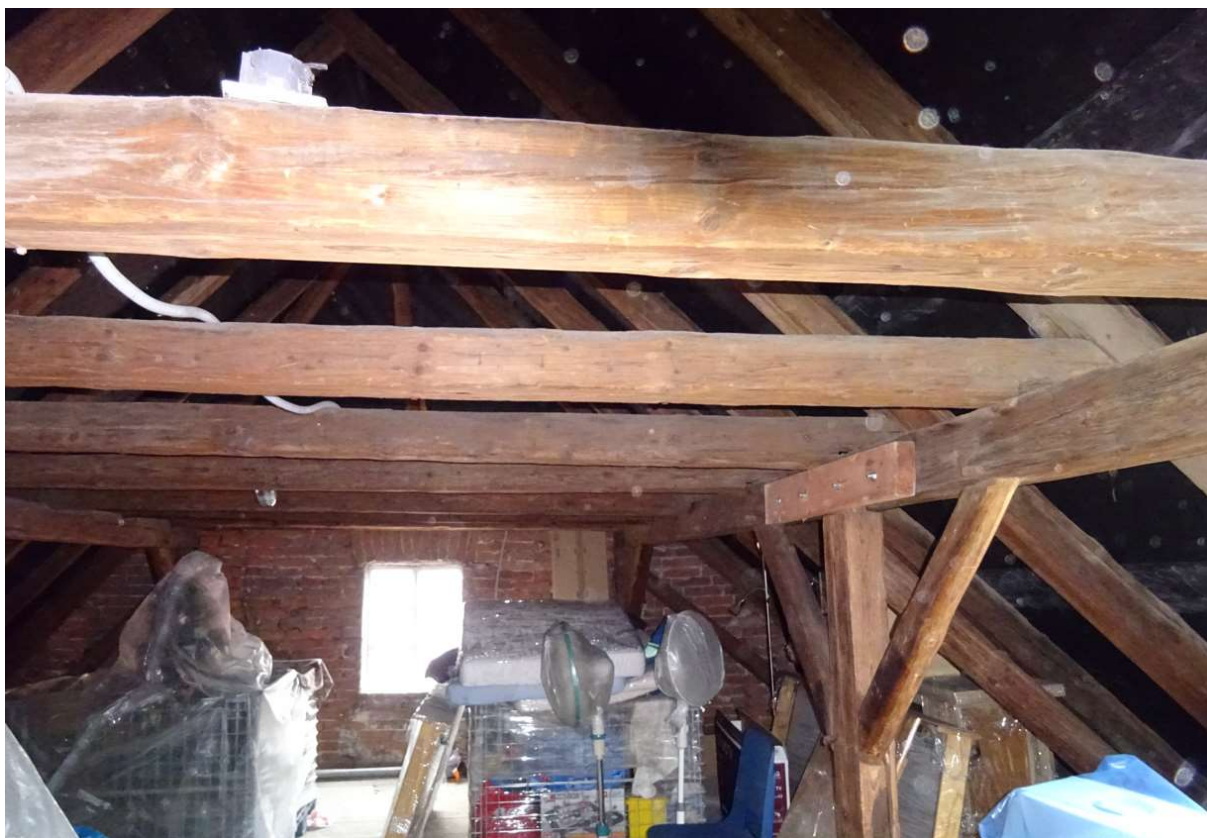
Obrázek 14, hambálkový krov podepřený stojatou stolicí
