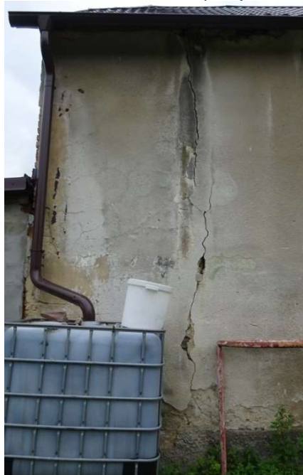
Obrázek 23, svislé trhliny na fasádě
