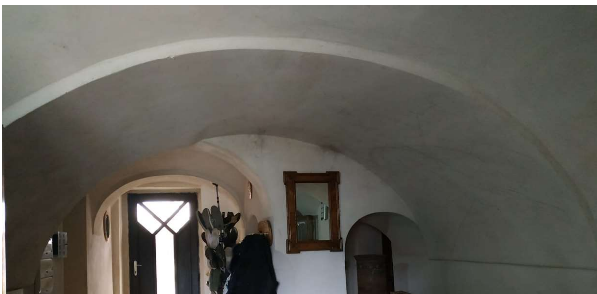
Obrázek 9, valená klenba s největším rozpětím a její rozdělení
