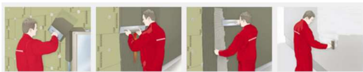
Obrázek 97, uhlazení povrchu desek z kamenné vlny (14)
