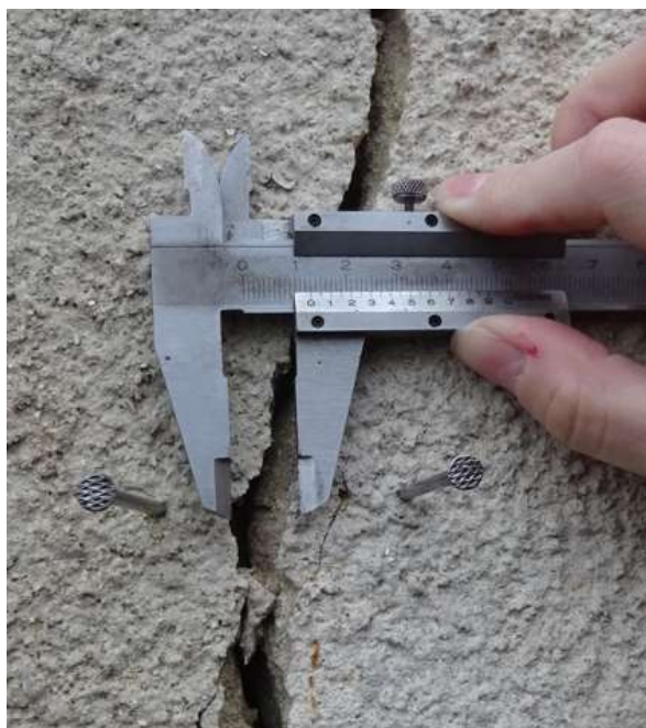
Obrázek 32, začátek měření aktivity trhliny: listopad 2021
