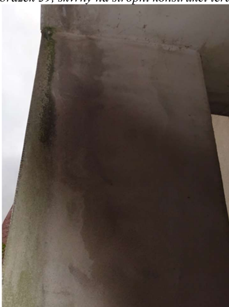
Obrázek 40, řasy na levém sloupu terasy
