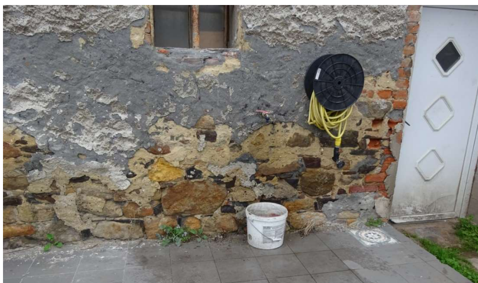
Obrázek 3, svislá nosná konstrukce z dvou typů cihel
