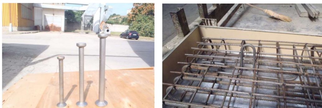
Obrázek 47- Ukázka trnu s kulovou hlavou (vlevo) [22] a ukázka osazení klasického úchytu (vpravo) [22]
