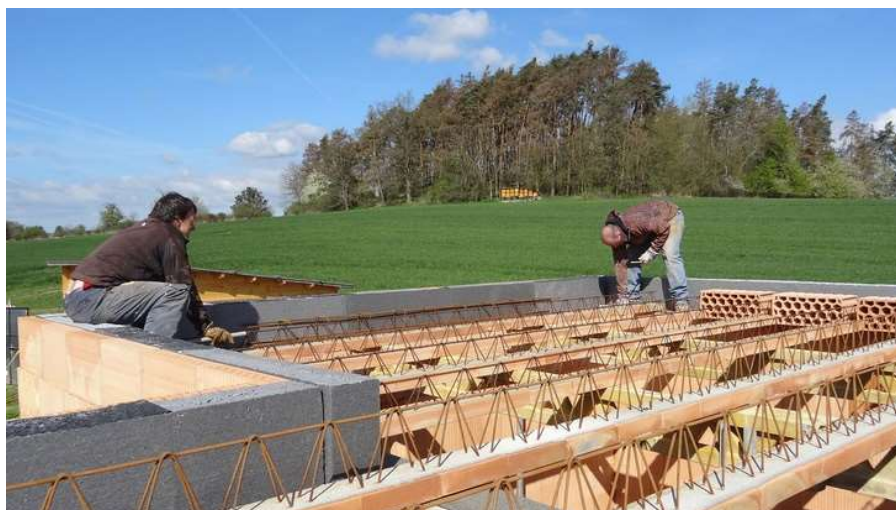
Obrázek 17- Usazování stropních trámů [12]
