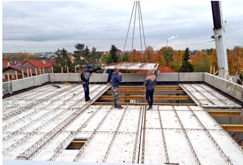
Obrázek 24- Ukázka vhodného užití filigránových stropů [17]
