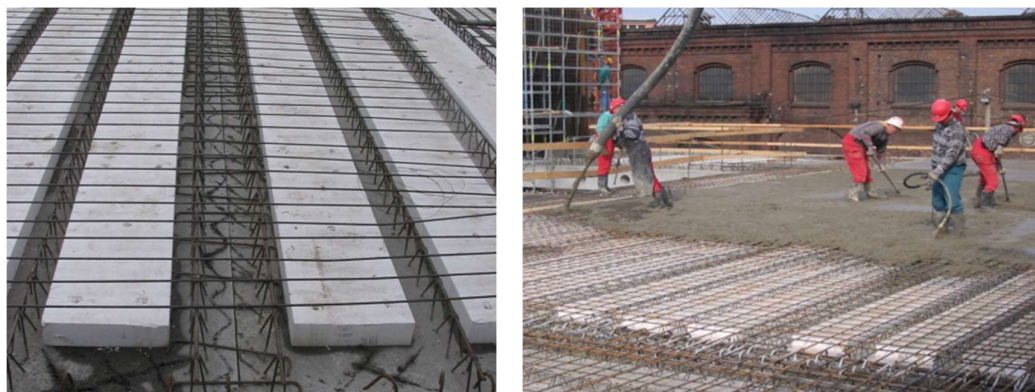
Obrázek 27- Vylehčení filigránových desek pomocí EPS [10]
