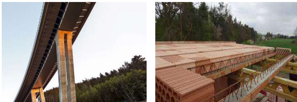
Obrázek 1- Lochkovský most (vlevo) [13] a strop z Miako vloček (vpravo) [12]
