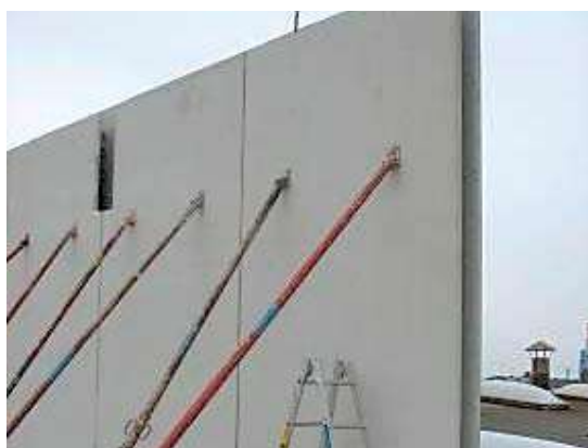
Obrázek 3- Prefamolitický stěnový dílec na stavbě [9]
