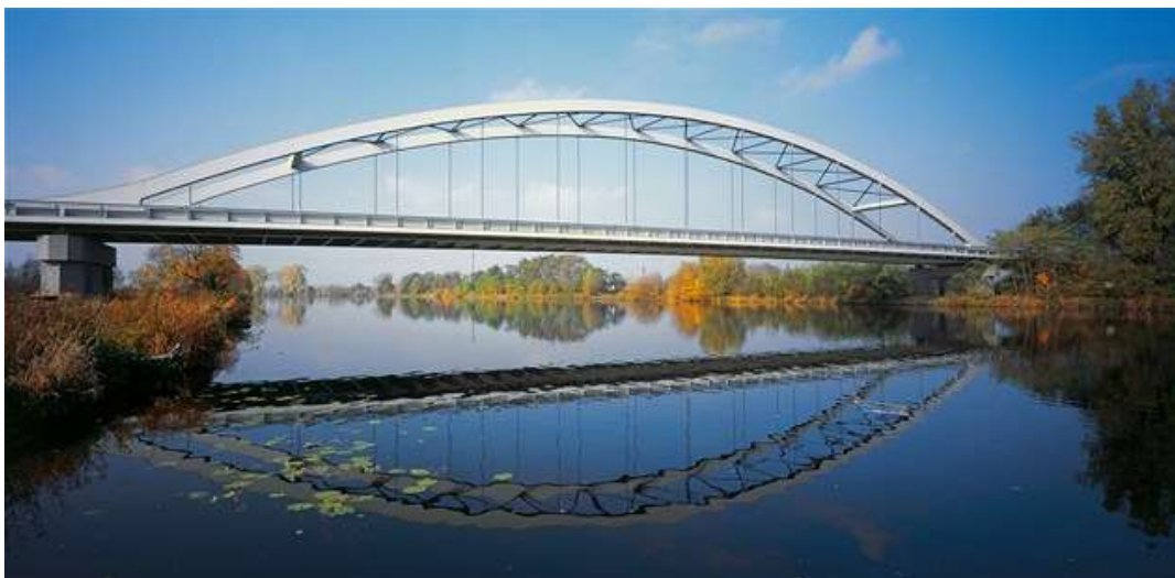
Obrázek 9- Dokončený most přes Labe v obci Litol [6]
