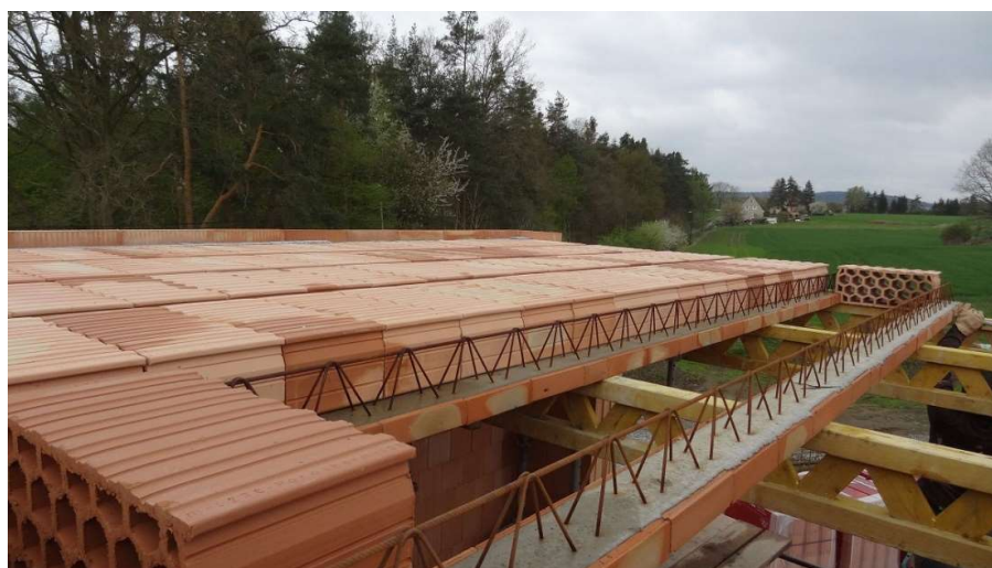
Obrázek 18- Skládání stropních vložek [12]
